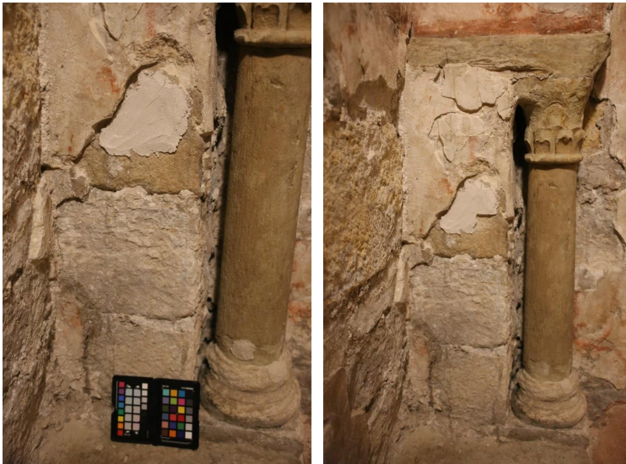
Abb. A26 und 27: Probenahmepunkte MK05, 06 und 07, Innenraum; Kompressen vor der Abnahme (links), nach der teilweisen Abnahme (rechts)
