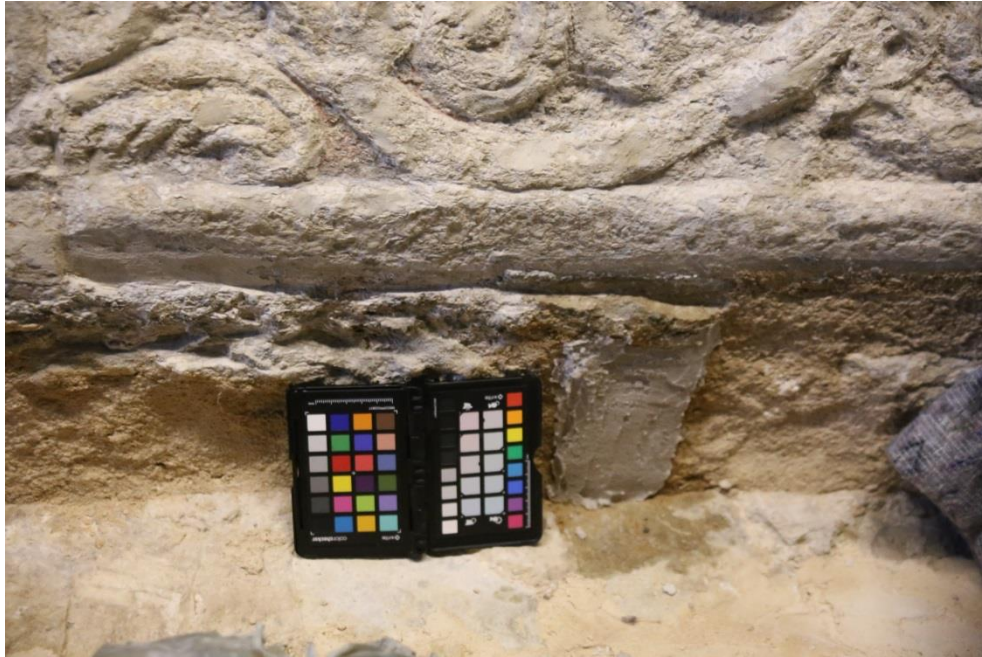
Abb. A29: Probenahmepunkt MK01, Graben unterhalb der Westwand des Heiligen Grabes; Kompressen neu
