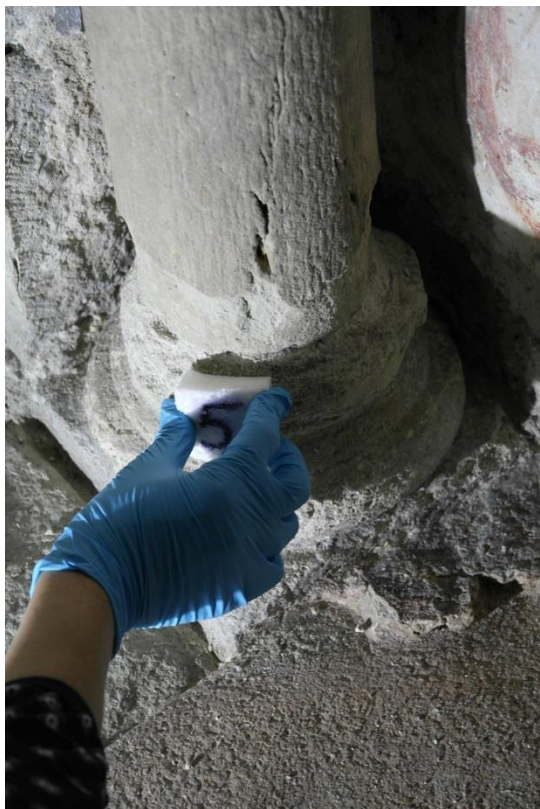
Abb. A17: Probenahmepunkt SK05, Beprobung einer Säule an der Westwand des Heiligen Grabes, Innenraum
