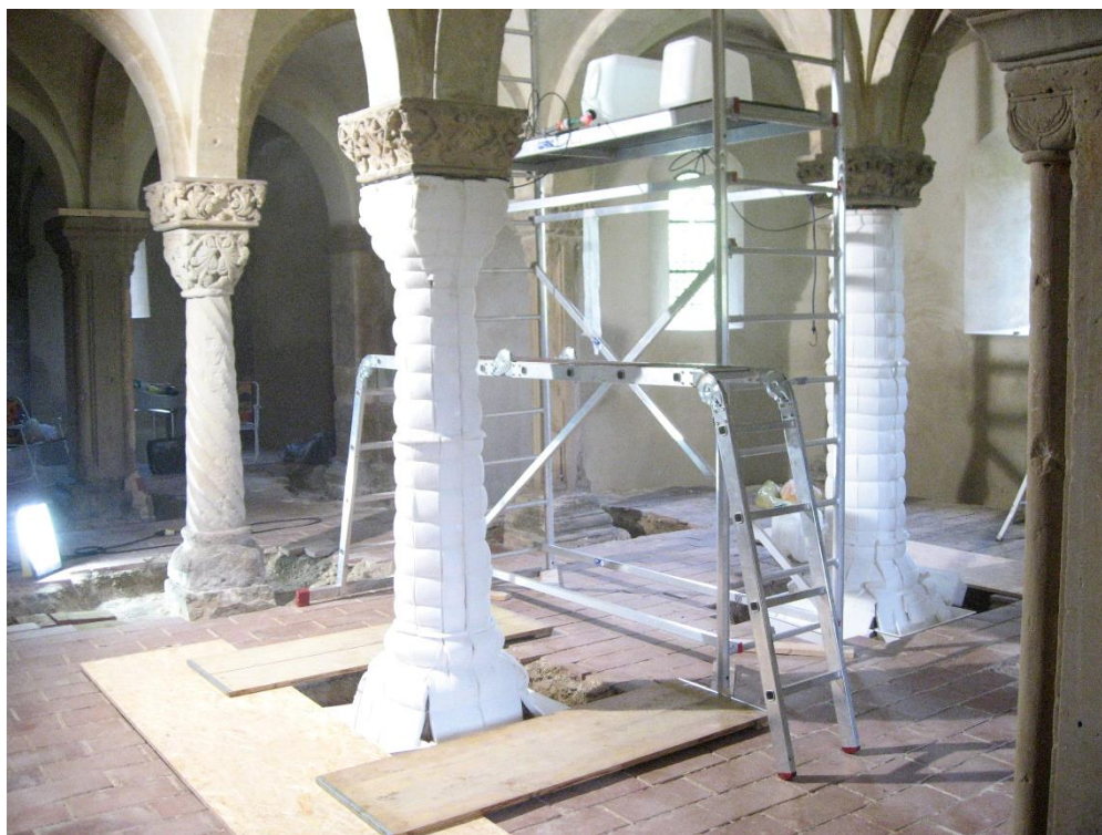
Abb. 47: Blick in die Krypta während der Arbeiten 2007.
