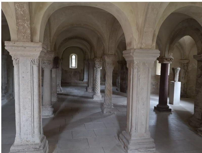
Abb. 46: Blick in die Krypta nach Westen, Zustand nach den Konservierungsmaßnahmen.
