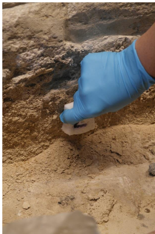
Abb. A14: Probenahmepunkt SK02, Graben unterhalb der Westwand des Heiligen Grabes: Beprobung des stark Salzbelasteten Opferputzes
