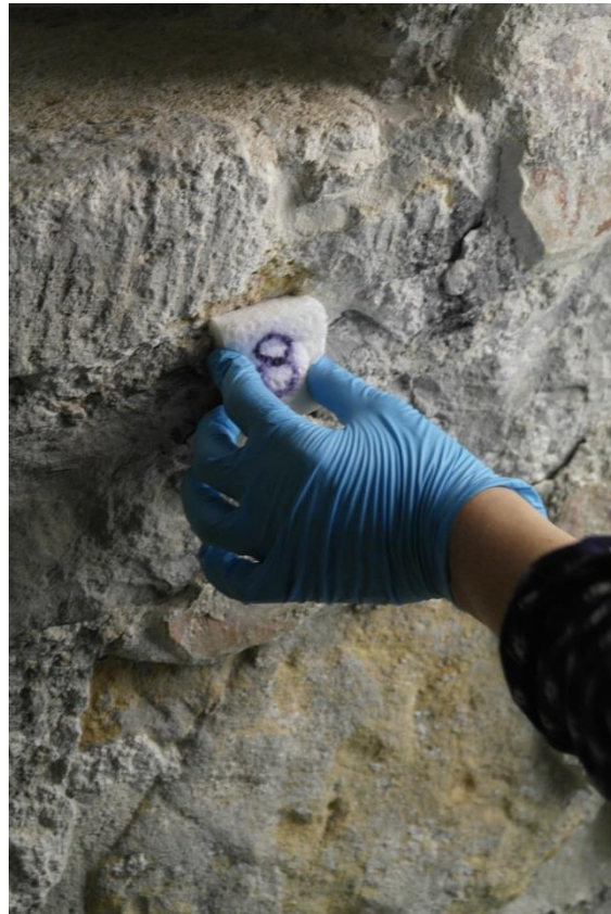
Abb. A20: Probenahmepunkt SK08, Beprobung an der Süd- wand des Heiligen Grabes, Innenraum
