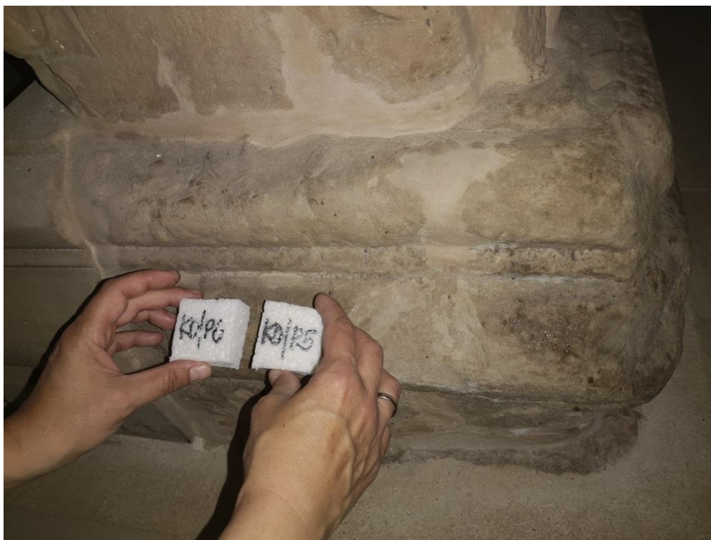
Abb. A34: Ermsleben, Konradsburg, Krypta: Schwammkompressen zur Beprobung salzbelasteter Oberflächen (Säule, Basis)
