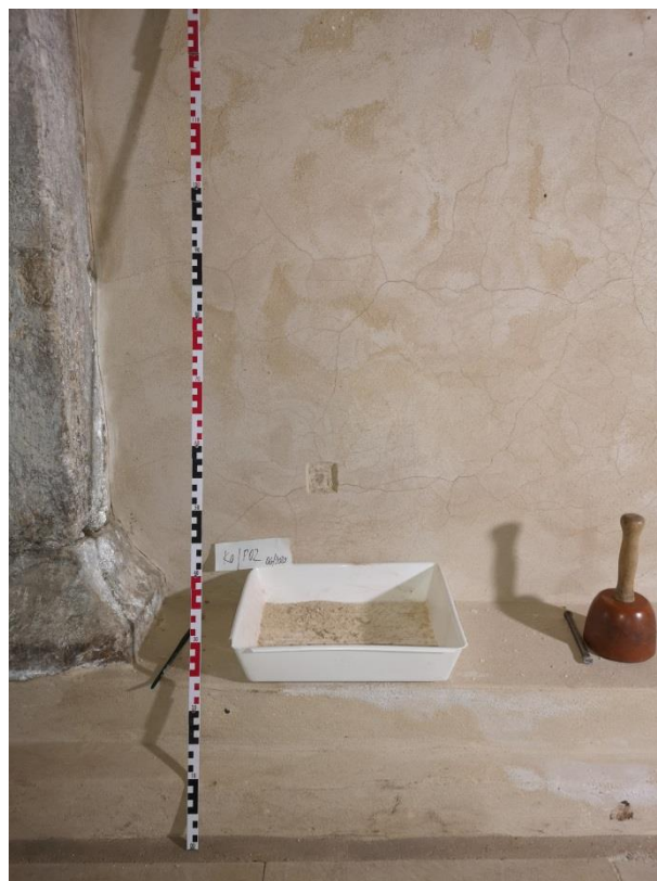
Abb. A31: Ermsleben, Konradsburg, Krypta: Probenahmepunkt 1, Ostwand, NO-Ecke
