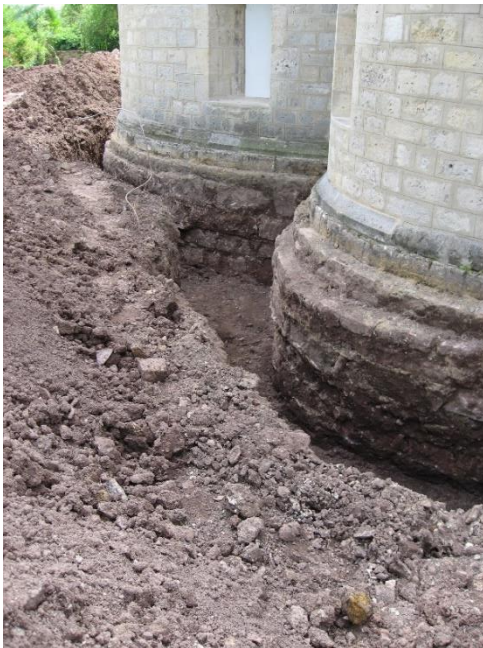
Abb. 49: An der Ostseite abgegrabener Sockelbereich.
