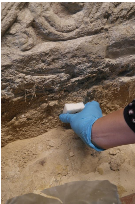
Abb. A13: Probenahmepunkt SK01, Graben unterhalb der Westwand des Heiligen Grabes: Beprobung des stark Salzbelasteten Opferputzes
