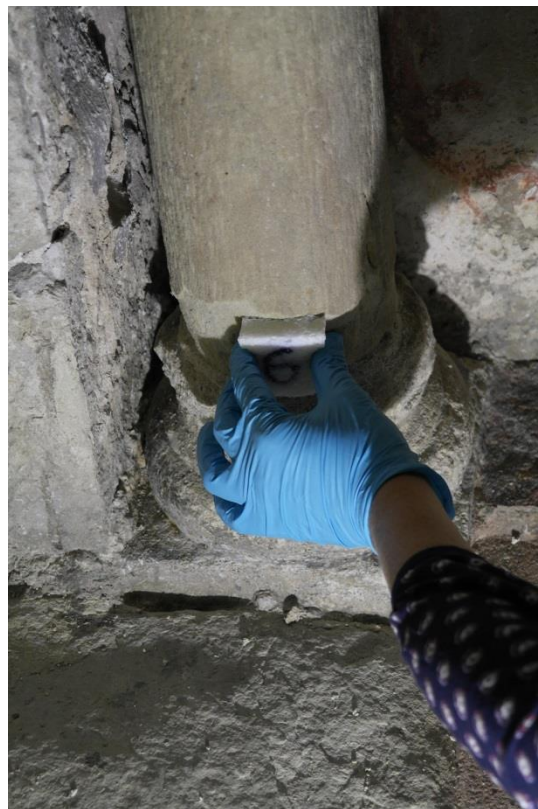
Abb. A18: Probenahmepunkt SK06, Beprobung einer Säule an der Westwand des Heiligen Grabes, Innenraum
