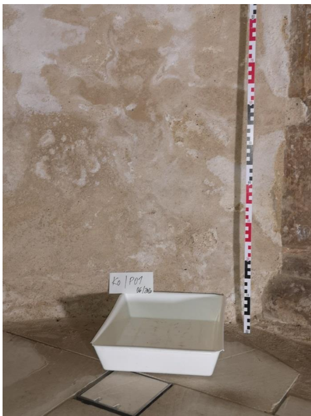
Abb. A30: Ermsleben, Konradsburg, Krypta: Probenahmepunkt 1, Ostwand, NO-Ecke
