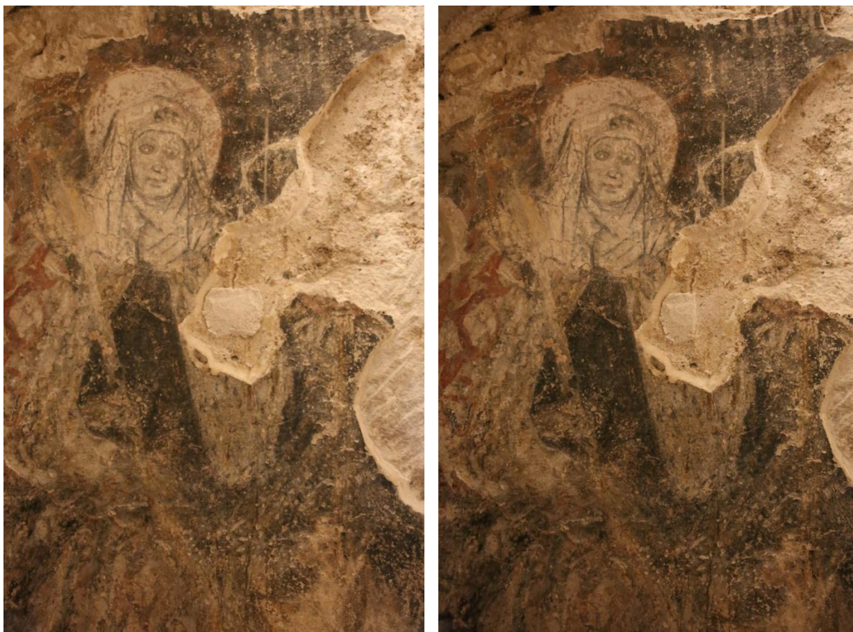
Abb. A23 und 24: Probenahmepunkt MK03, Innenraum; Kompresse vor der Abnahme (links), nach der teilweisen Abnahme (rechts)
