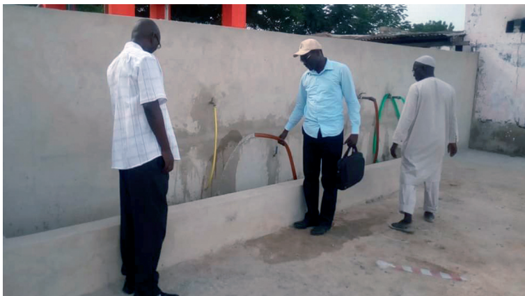
Abnahme Abbass Kane (Baufirma) und Andre Senghor (Caritas Thiès)
