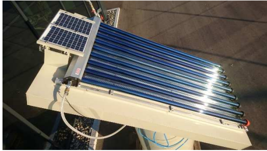
Solarmodul mit Vakuumtechnik durch Röhrenkollektoren
