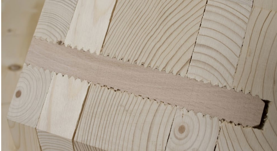
Abbildung 21: Verbindung der Buchenschraube mit den Brettlagen (Quelle: NUR-HOLZ)
