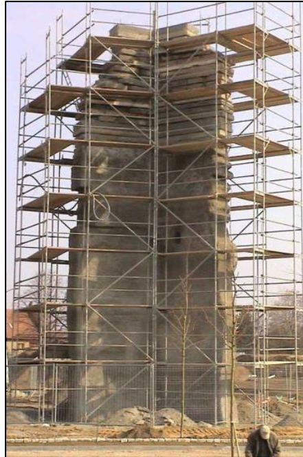
Foto 5.7: Kletterfelsen Y-Variante im Bau, Guben Baujahr 2004, Foto: DAV Guben
