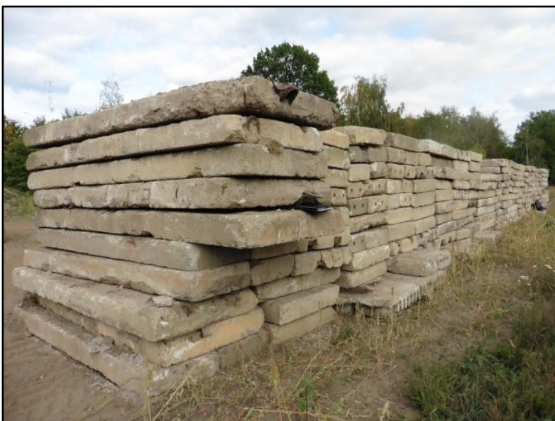
Foto 5.9: Lagerplatz der Straßenbauplatten
