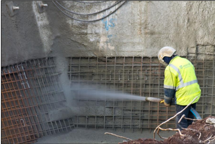
Foto 3.1: Spritzbetonapplikation im Zuge eines Grubenbaus [Bildnachweis: © Raimond Spekking / CC BY-SA 4.0 (via Wikimedia Commons)]
