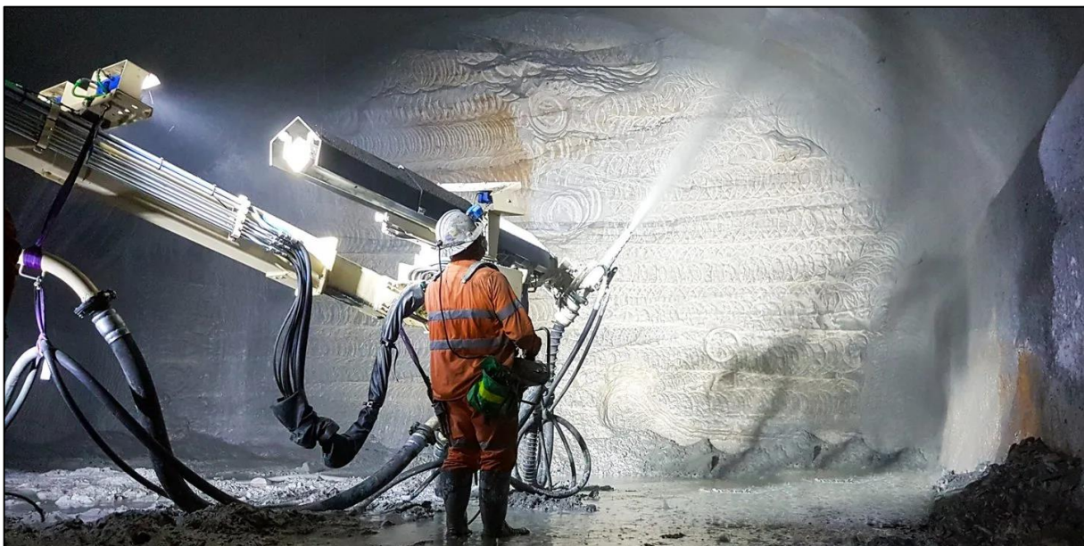
Foto 3.2: Maschinelle Spritzbetontechnik im Tunnelbau [Bildnachweis: https://azichem.network/universo-azichem/fluid-spritz-il-nostro-accelerante-liquido-per-spritz-beton/ ]
