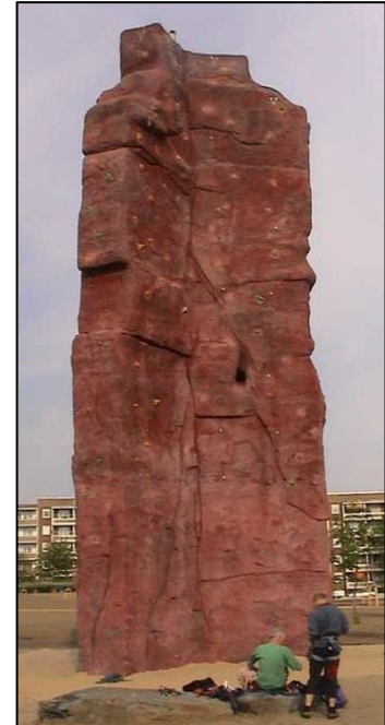
Foto 5.8: Fertiggestellter Felsen mit gefärbter Spritzbetonschale, „Reichenbacher Zinne“ in Guben, Foto: DAV-Guben
