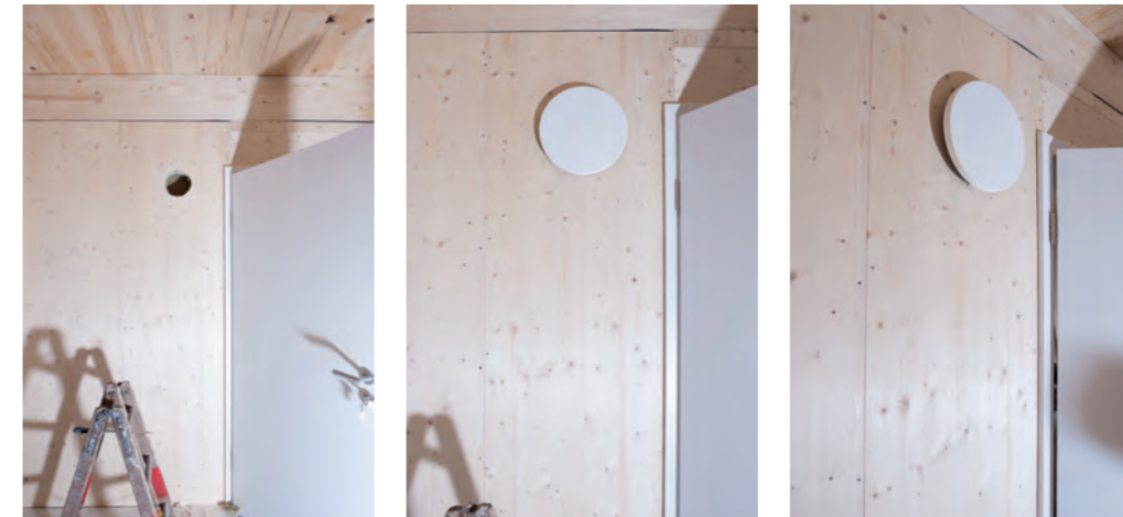
Abbildung 32: (rechts) Überströmelement mit Schalldämmung. Fotos: Carina Bauer.
