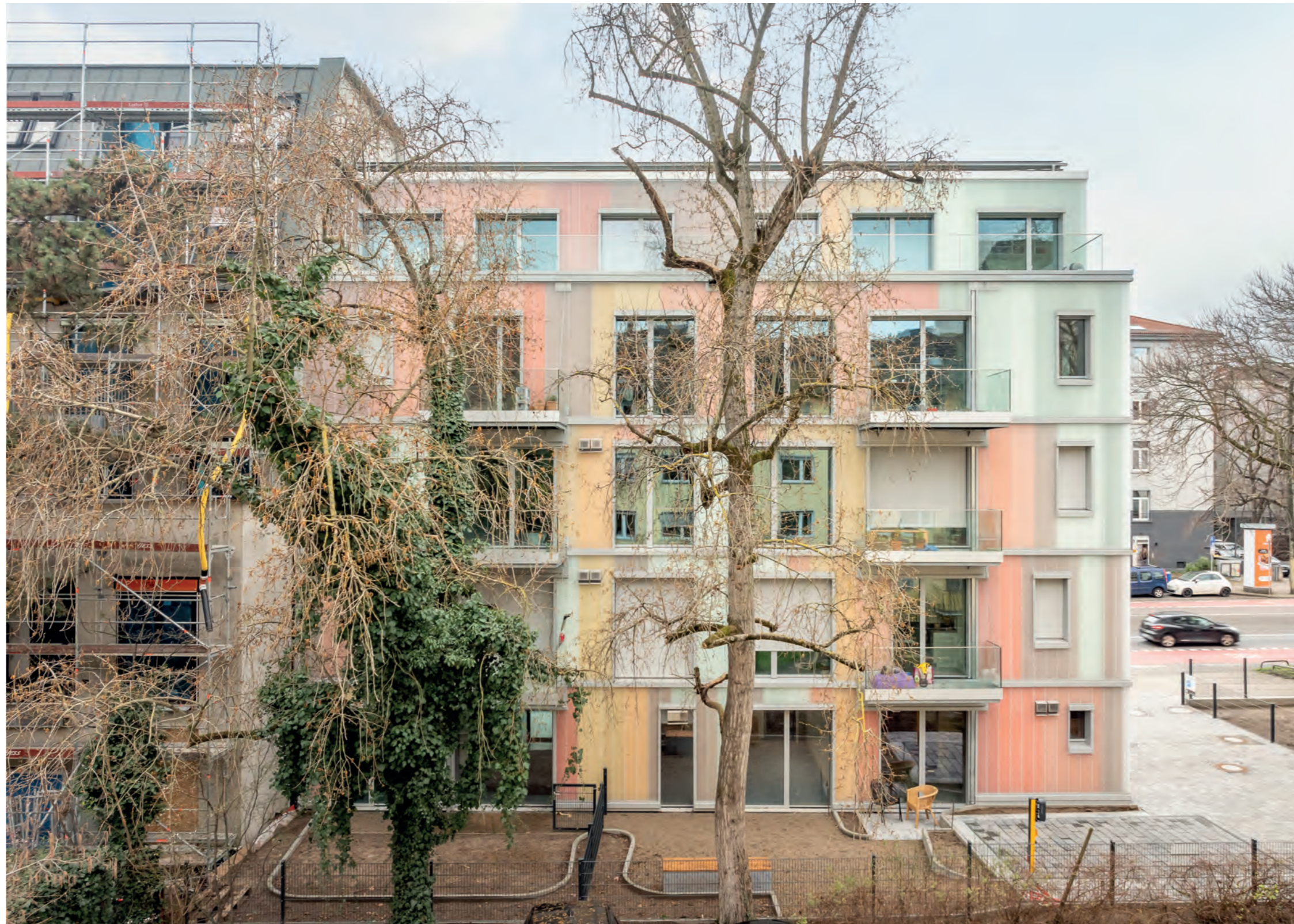
Abbildung 110: Rückwärtige, der Friedberger Landstraße abgewandte Seite des Gebäudes mit entstehendem Garten, Spielplatz und gemeinschaftlichem Außenraum, rechts im Bild der Tiefparker und die E-Ladestation. Foto: Urheberrecht Thilo Ross Urh. Nr. 4026999, Quelle: DGJ Architektur GmbH.
