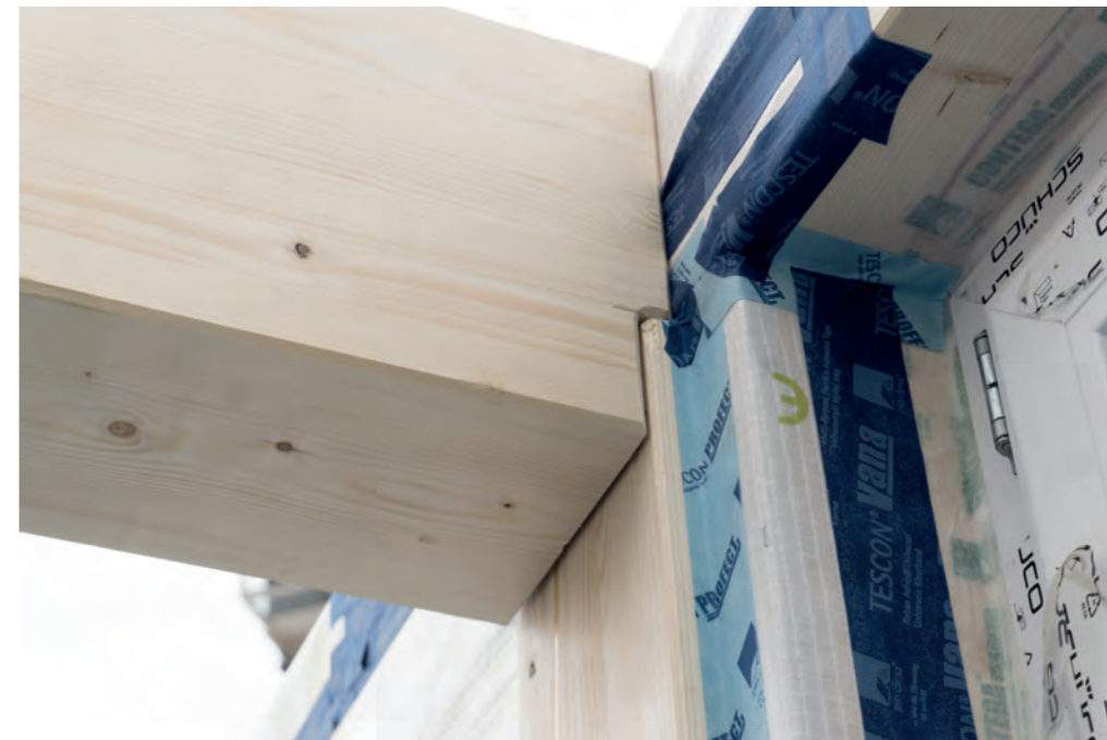
Abbildung 78: Montageprozess Deckenträger beim Modellvorhaben Fotos: DGJ Architektur.
