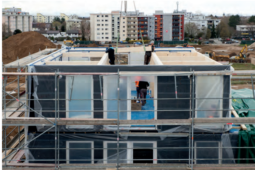
Abbildung 74: Montageprozess Deckenträger beim Modellvorhaben Fotos: DGJ Architektur.
