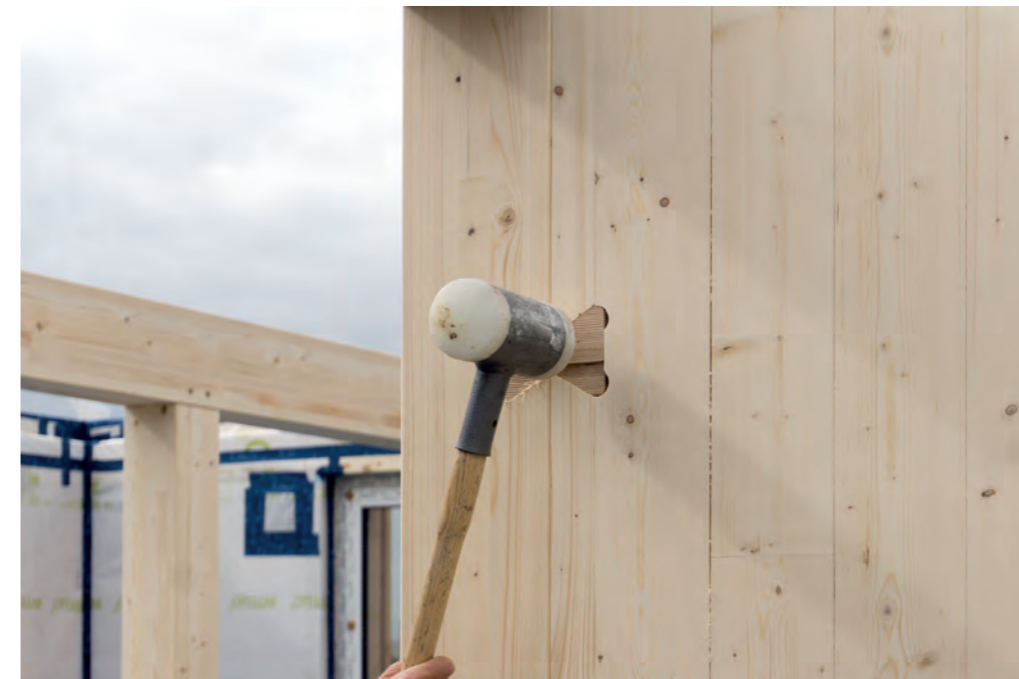
Abbildung 73: Montageprozess aussteifende Innenwände beim Modellvorhaben Fotos: DGJ Architektur.
