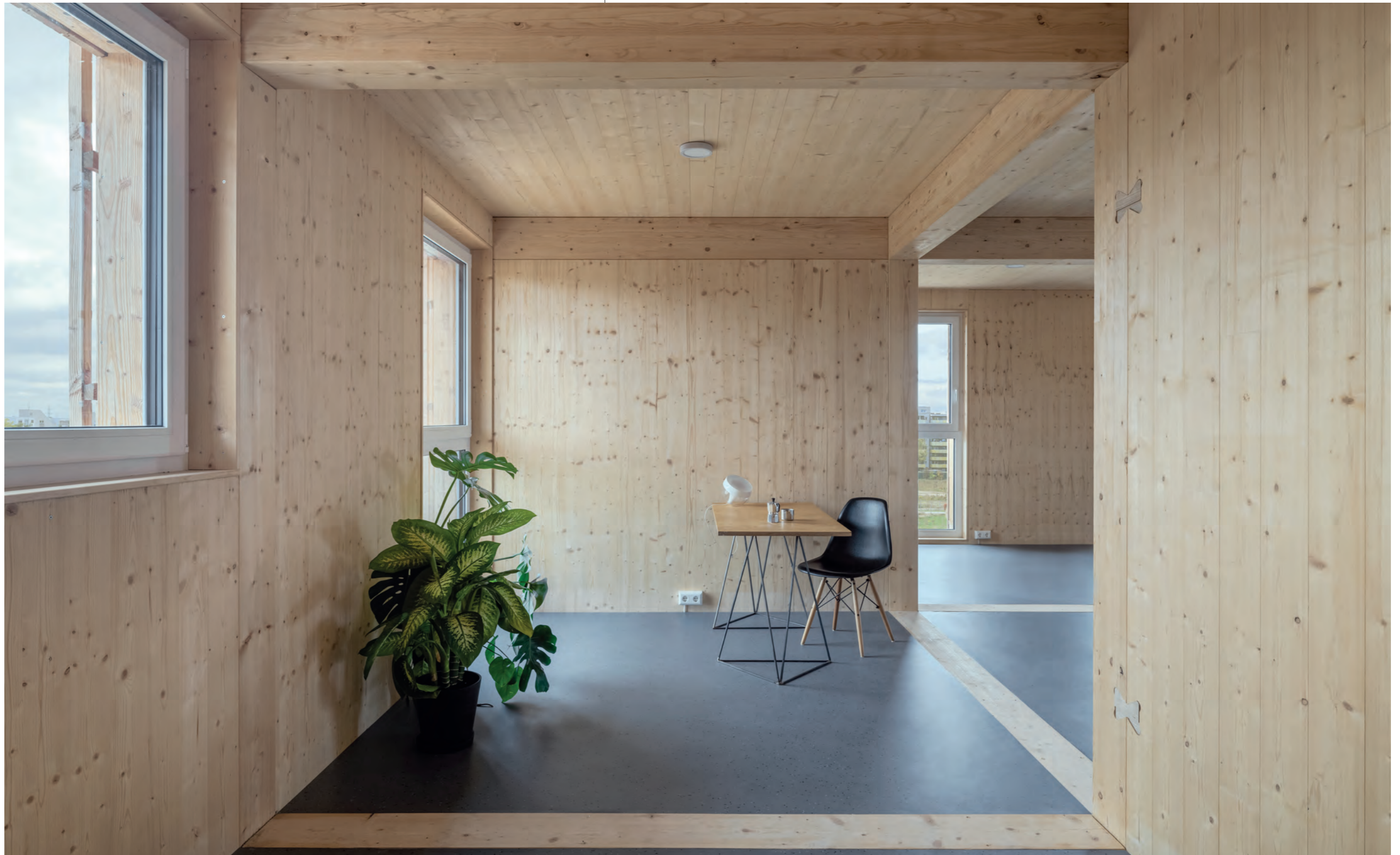
Abbildung 94: Innenraum mit Holzwänden. Auf dem Boden sind die Holzschwellen sichtbar, die die Grundrisse für die versetzbaren Innenwände markieren. Nehmen die Schwellen eine Trennwand auf, werden die hier sichtbaren, flachen Schwellen durch Führungsschienen mit entsprechenden Rillen ersetzt. Foto: Urheberrecht Thilo Ross Urh. Nr. 4026999, Quelle: DGJ Architektur GmbH.
