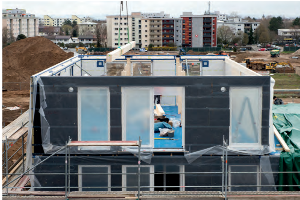
Abbildung 66: Montageprozess Unterzüge beim Modellvorhaben Fotos: DGJ Architektur,
