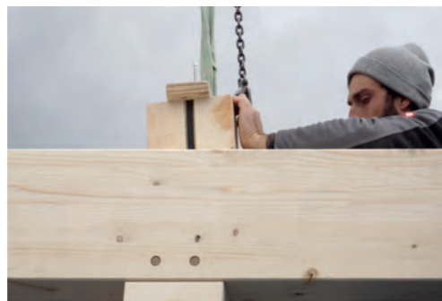
Abbildung 75: Montageprozess Deckenträger beim Modellvorhaben Fotos: DGJ Architektur.
