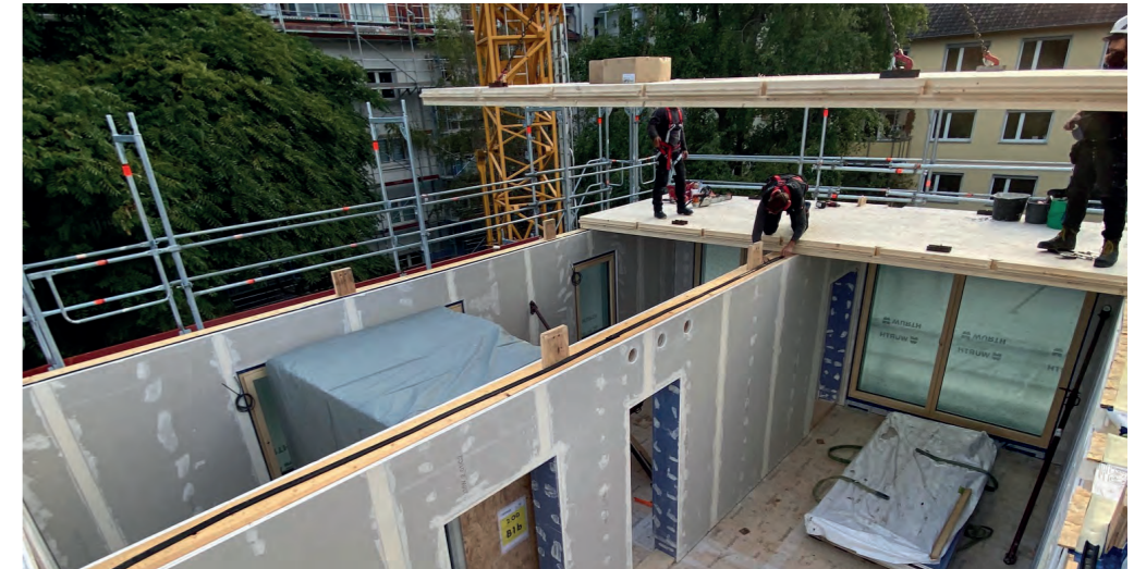
Abbildung 112: Montage der Decken, dgj228.
