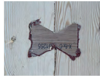
Abbildung 111: X-Fix Verbinder, Fugen ausgestopft mit Mineralwolle.
