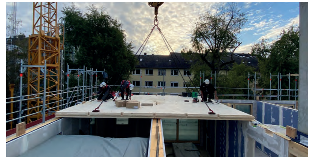
Abbildung 113: Montage der Decken, dgj228.
