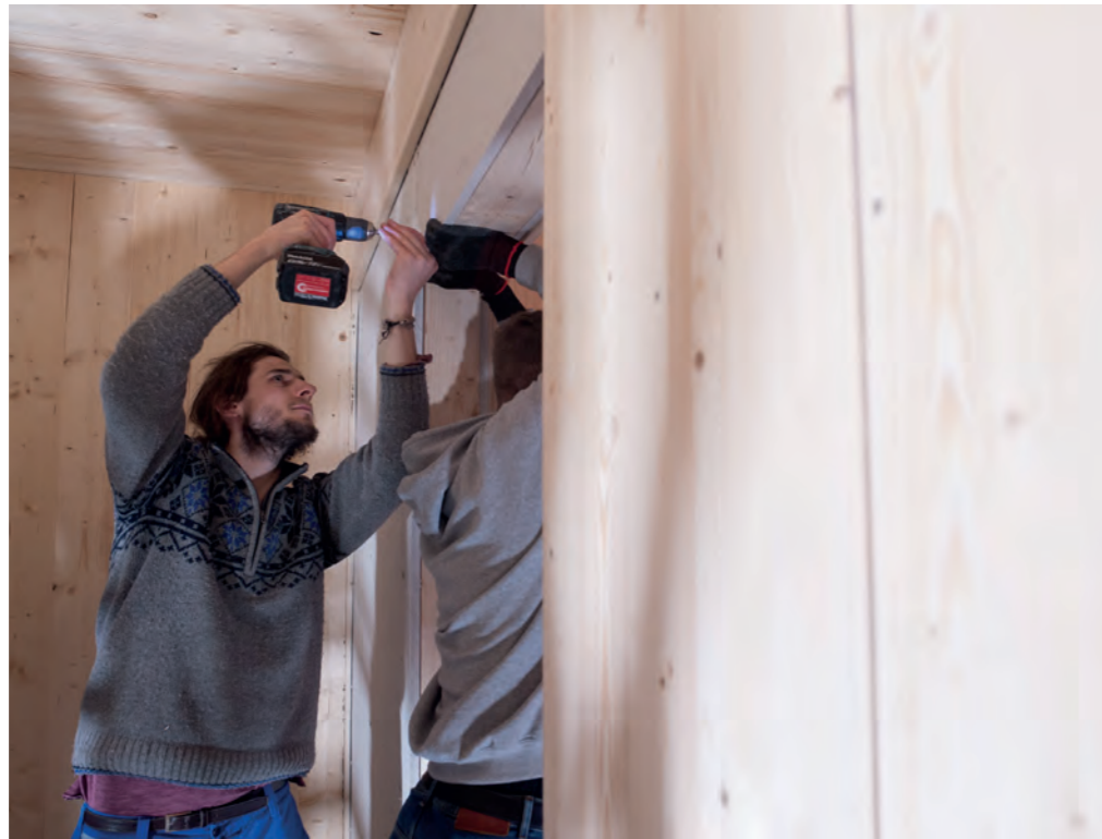
Abbildung 35: Montage der Beplankung an Ständerwänden. Foto: Carina Bauer.
