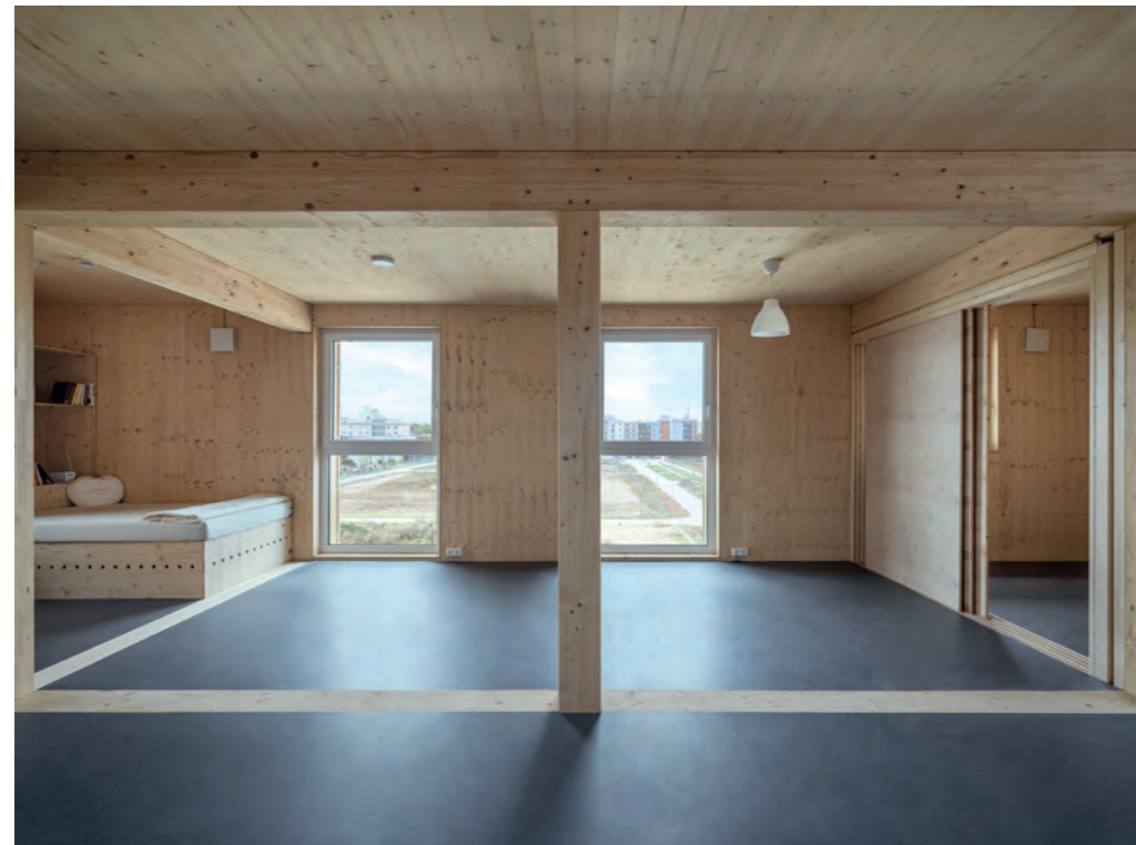
Abbildung 96: Blick in den Innenraum mit versetzbarer Trennwand rechts im Bild und austauschbarer Führungsschiene mit Rillen im Boden. Foto: Urheberrecht Thilo Ross Urh. Nr. 4026999, Quelle: DGJ Architektur GmbH.
