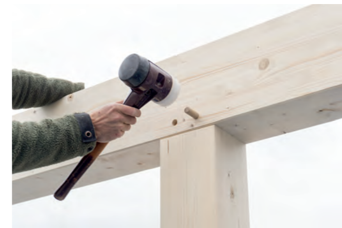
Abbildung 69: Montageprozess Unterzüge beim Modellvorhaben Fotos: DGJ Architektur.
