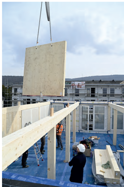
Abbildung 71: Montageprozess aussteifende Innenwände beim Modellvorhaben Fotos: DGJ Architektur.
