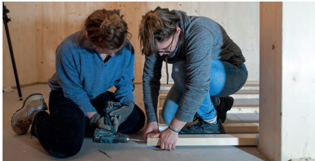
Abbildung 33: Herstellung des Ständerwerks für die zweischalige Innenwand TW05 Foto: Carina Bauer.
