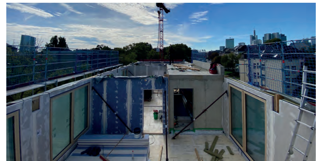
Abbildung 114: Montage der Decken, dgj228.
