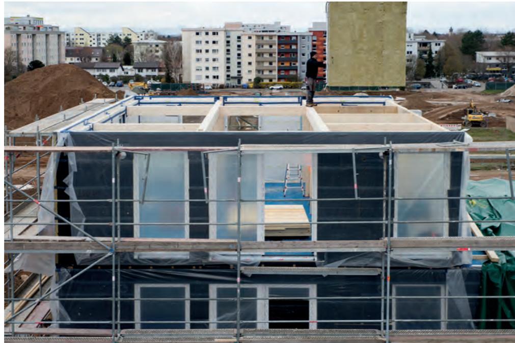
Abbildung 79: Montageprozess Nasszellen beim Modellvorhaben Fotos: DGJ Architektur.
