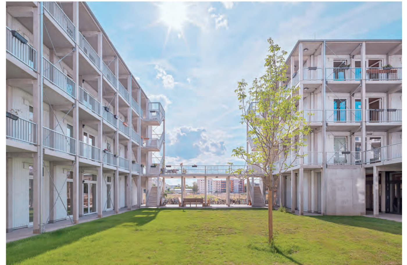
Abbildung 93: Blick in den Innenhof mit Laubengängen in westlicher Richtung, 2023. Foto: Urheberrecht Thilo Ross Urh. Nr. 4026999, Quelle: DGJ Architektur GmbH.
