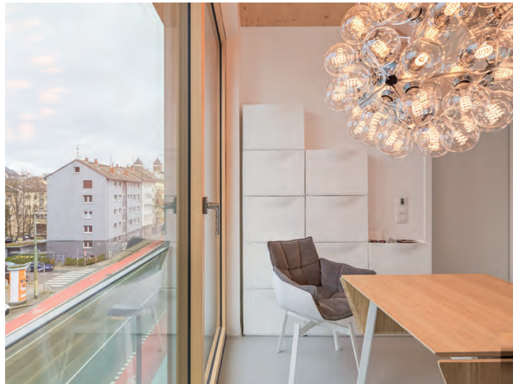
Abbildung 107: Die Friedberger Landstraße gehört zu den Hauptverkehrsadern von Frankfurt am Main. Entsprechend hoch waren die Ansprüche an den Schallschutz. Die Fassade ist eine einschalige Fensterkonstruktion, die sowohl den Wärme- als auch den Schallschutzanforderungen entspricht und die im Holzbau anspruchsvollen Einbaudetails zur Verhinderung der Flankenschallübertragung technisch umsetzt. Der Einsatz der Profigläser als schallentkoppelte Schicht vor der vergleichsweise leichten Holz-Außenwand verbessert den Schallschutz wesentlich. Foto: Urheberrecht Thilo Ross Urh. Nr. 4026999, Quelle: DGJ Architektur GmbH.
