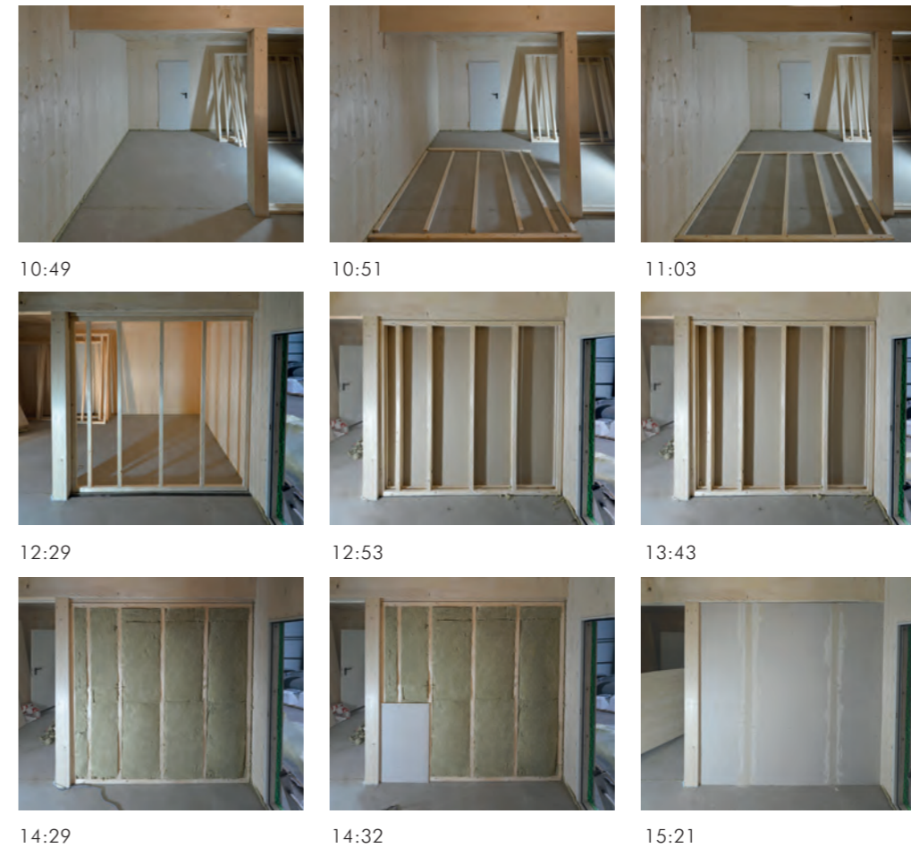
Abbildung 34: Aufbauschritte zweischalige Ständerwand TW05. Fotos: DGJ Architektur, 04.04.2019.
