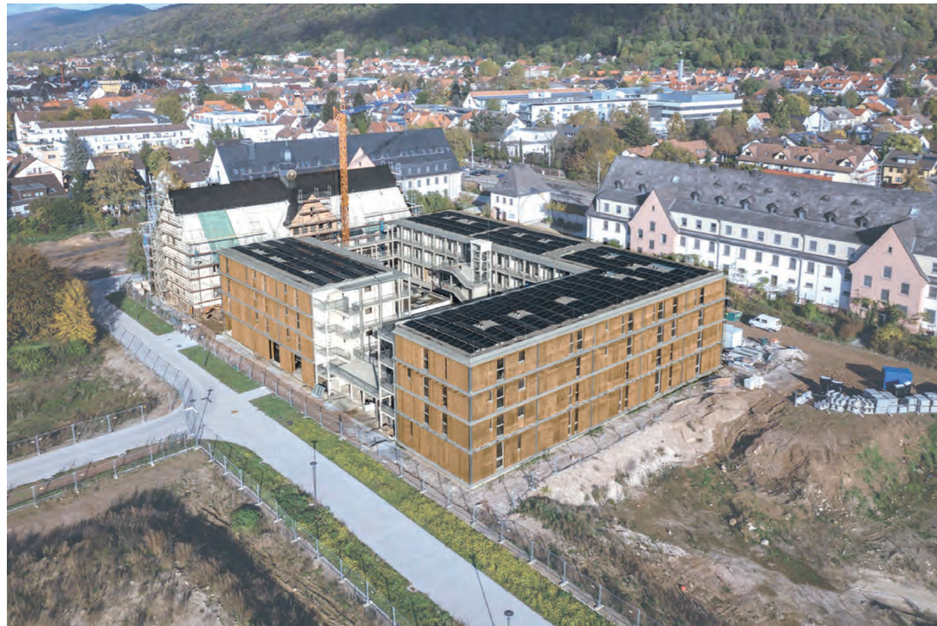
Abbildung 92: Luftaufnahme während der Bauphase, 2022. Foto: Urheberrecht Thilo Ross Urh. Nr. 4026999, Quelle: DGJ Architektur GmbH.
