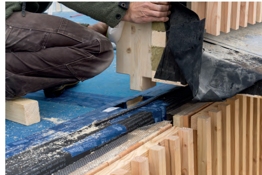
Abbildung 61: Fügung der Fassadenteile.
