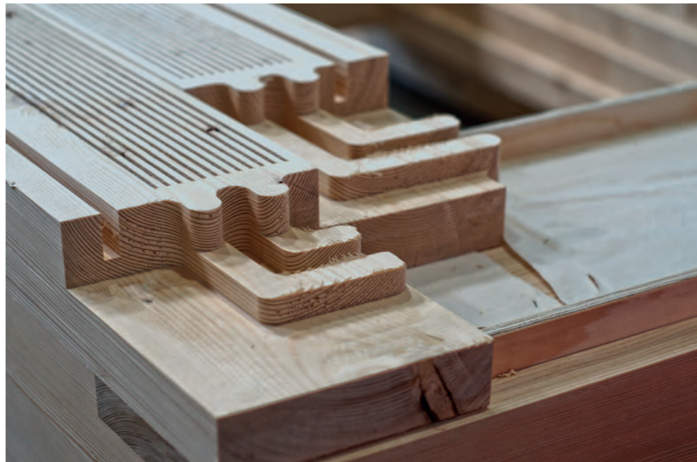
Abbildung 13: Timber Prototype House, IBA Thüringen, Verbindung Rahmenecke, Foto: Hans Drexler und Studierende der JHS.
