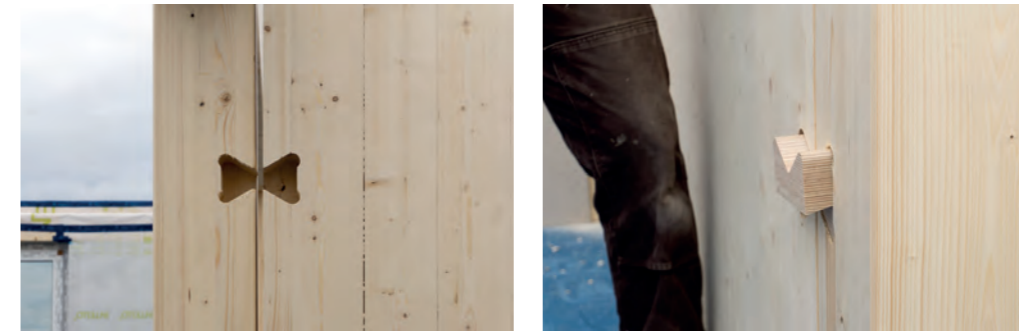
Abbildung 72: Montageprozess aussteifende Innenwände beim Modellvorhaben Fotos: DGJ Architektur.
