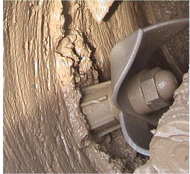
Abb. 102: Inhomogene Mischzone hinter dem Wirbler
