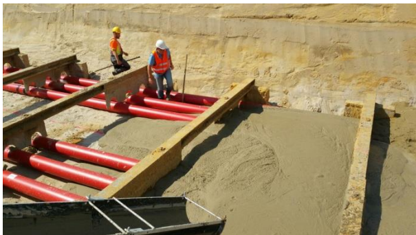
Abb. 1: Kabelschächte mit verlegten Erdkabeln und Abstandhaltern während der Verfüllung mit Flüssigboden
