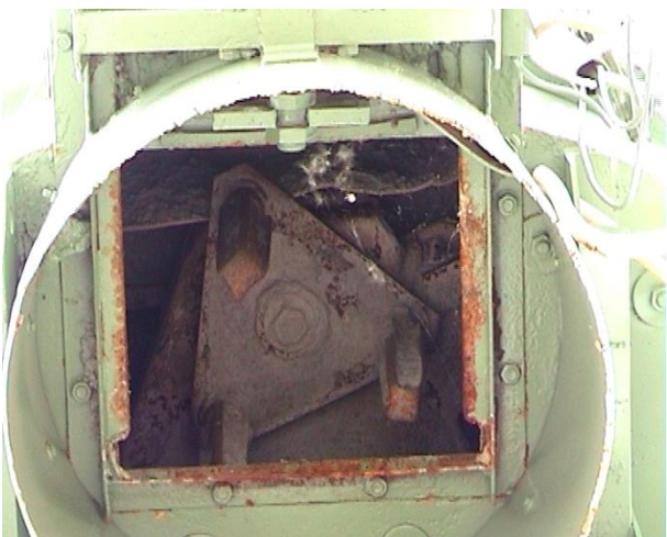
Abb. 98: Detailaufnahme des Wirblers
