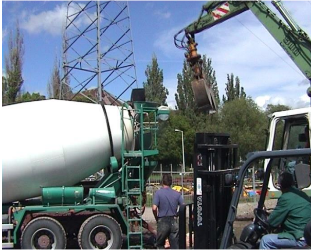
Abb. 96: Befüllung des Fahrmischers
