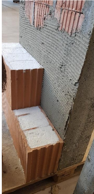
Bild 13: Vorsatzschale verklebt auf Ziegelfertigteil
