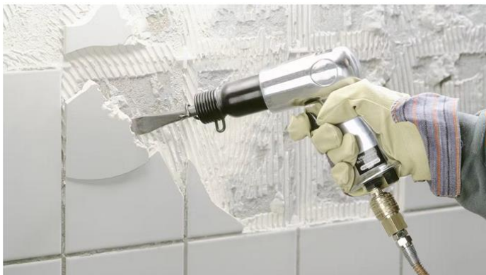
Bild 47: Fliesenabtrennung mittels Stemmhämmer [2] bzw. thermischer Behandlung [3]
