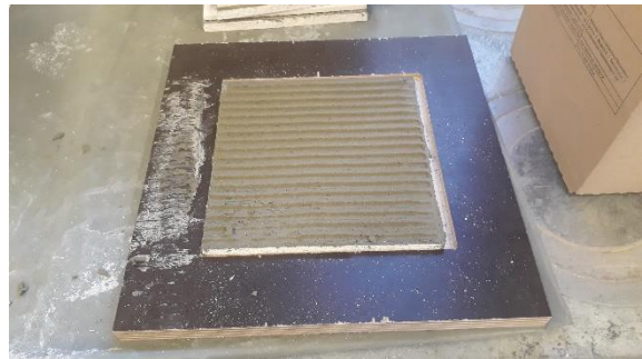
Bild 18: Abgezogener Fliesenkleber auf Gipskartonplatte
