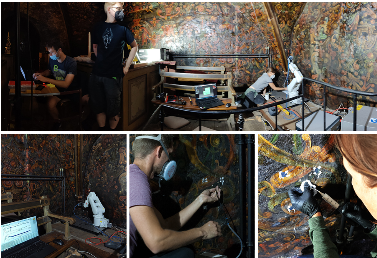
Abb. 143: Oben: Übersicht über den Arbeitsbereich Schlosskapelle Bückeberg, links unten: THz-Messung an Fläche B, Mitte unten: Ozonbehandlung in Fläche E, rechts unten: Hinterfüllung in Fläche E
