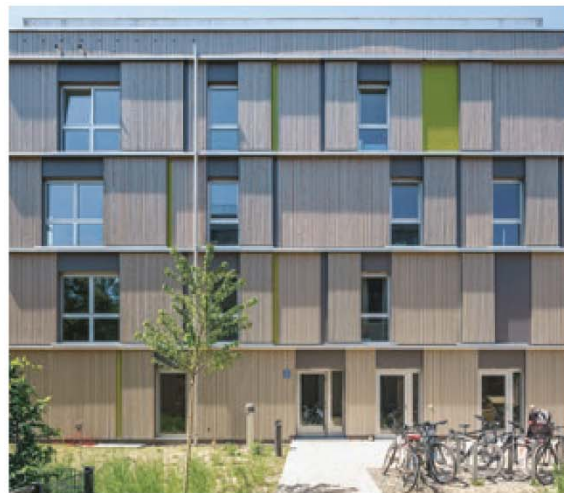
WA 16 Ost Seite 106 Bauherr Baugemeinschaft Der kleine Prinz GbR, München Architektur dressler mayerhofer rössler, architekten und stadtplaner gmbh, München BGF oberirdisch 5.662 m 2 ; Anzahl Wohnungseinheiten 39 Gemeinschaftseinrichtungen Gemeinschaftsraum, Gästeapartment, Dachterrassen, Eiscafé, Musikprobenraum, Fahrradwerkstatt EnEV KfW55
