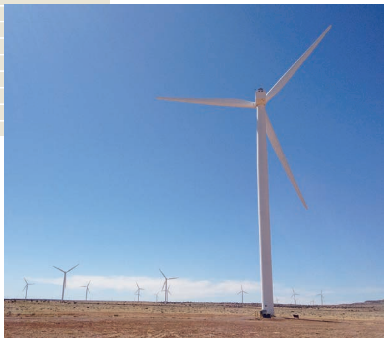
Windkraftwerk „Dry Lake Wind 2“ von Iberdrola, hier in Arizona, USA, Foto: Stephen Mellentine/Flickr.com
