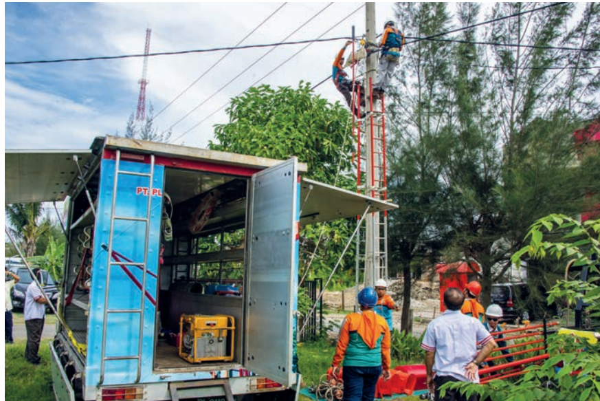
Stromversorgungsanlagen im ländlichen Aceh, Indonesien, finanziert durch die Asiatische Entwicklungsbank, Foto: Asian Development Bank/Flickr.com
