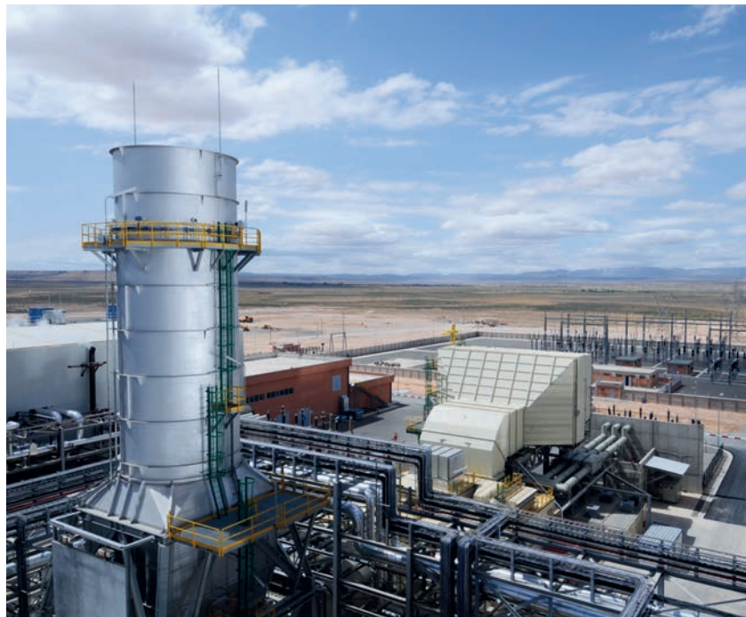
Solarthermisches Kraftwerk in Marokko, Foto: Dana Smillie/World Bank/Flickr.com
