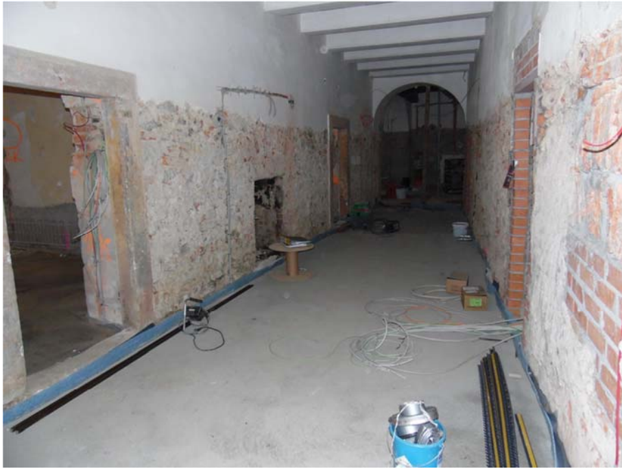
Abb. 20 Fertiggestellter Zement-Estrich
