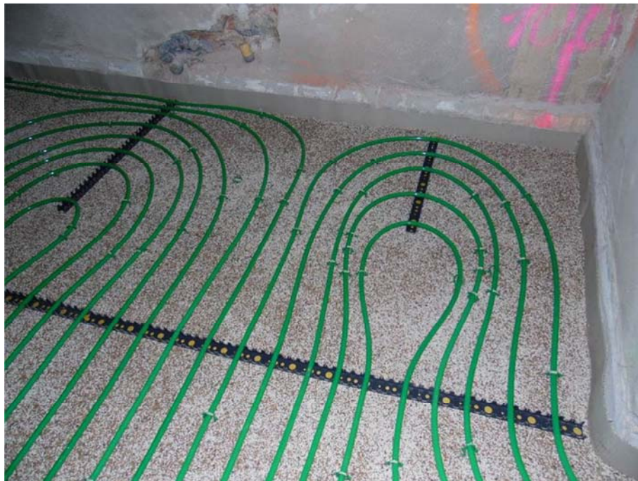
Abb. 11 Installation der Fußbodenheizung
