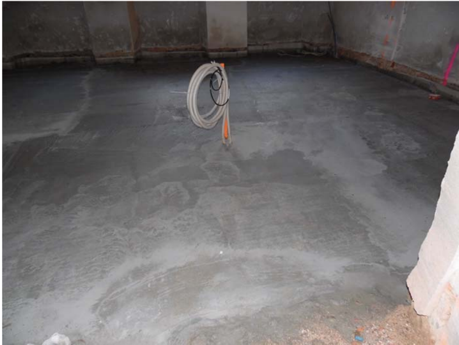
Abb. 26 Einbau des Rohfußbodens zur anschließenden Installation von Leitungen
