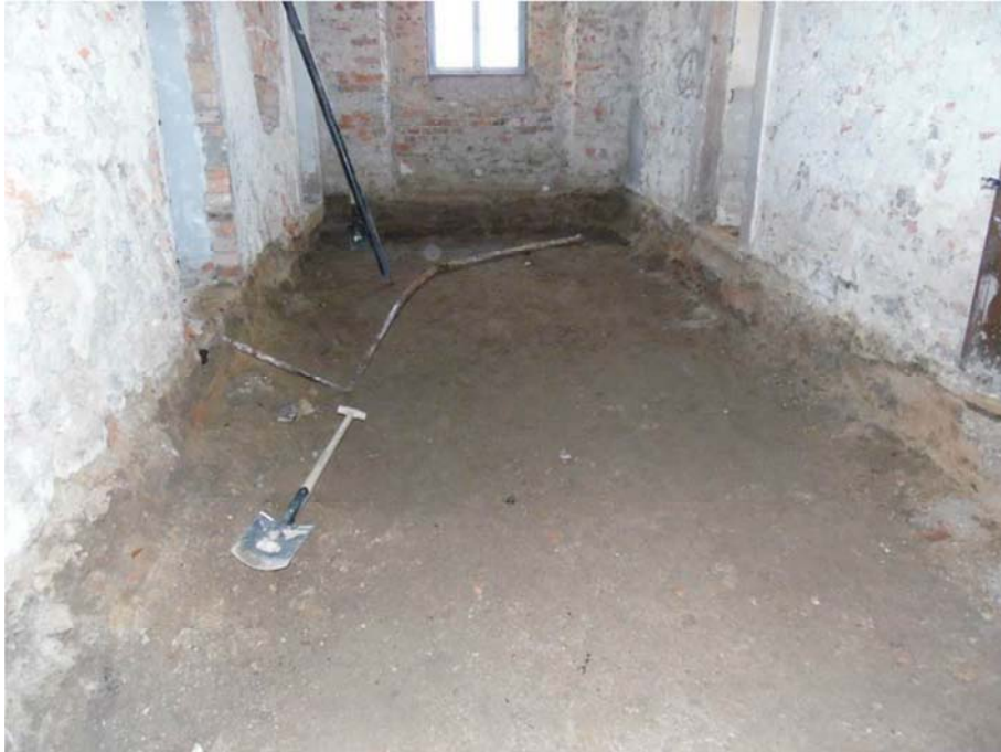
Abb. 16 Abbruch der geschädigten Bestandsfußböden
