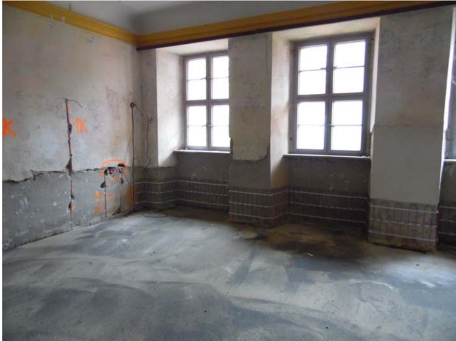
Abb. 30 Fertiggestellter Estrich
