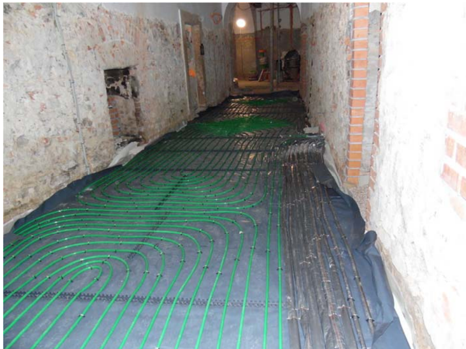
Abb. 19 Installation der Fußbodenheizung
