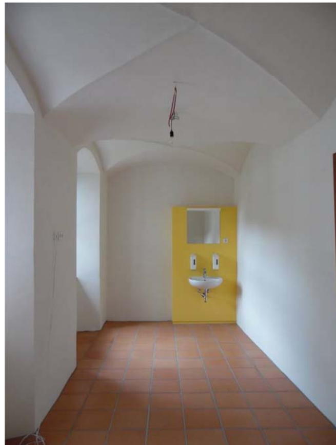
Abb. 12 Fertiggestellter Drainage-Estrich
