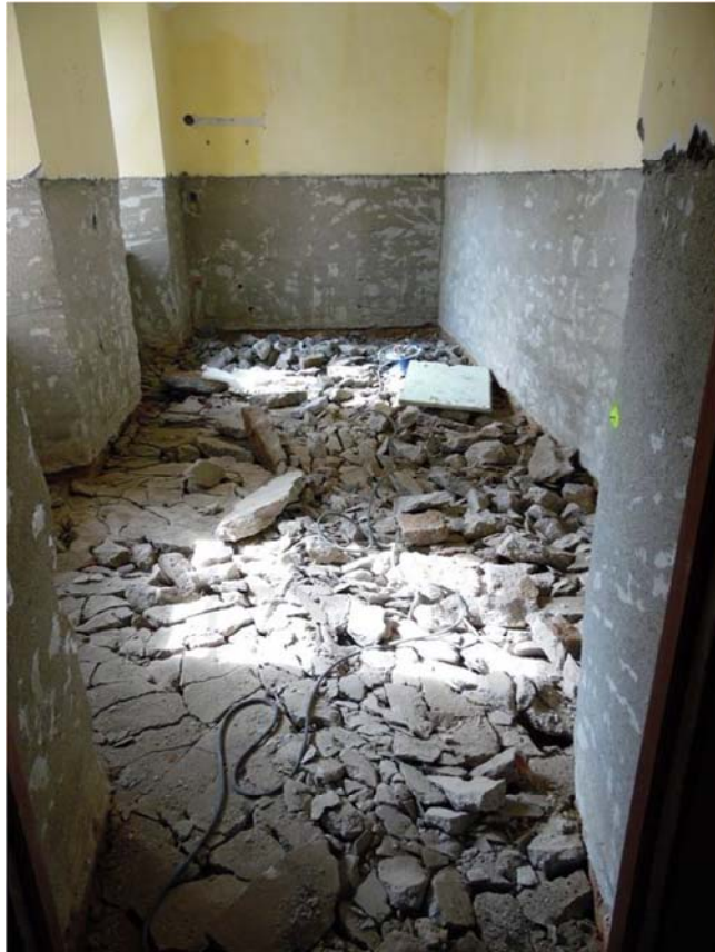
Abb. 8 Abbruch der geschädigten Bestandsfußböden
