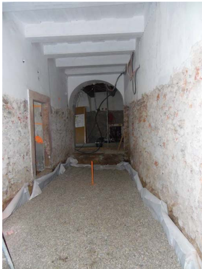
Abb. 17 Einbau der Sensoren unterhalb des Fußbodenaufbaus (im Bild an markierter Stelle)
