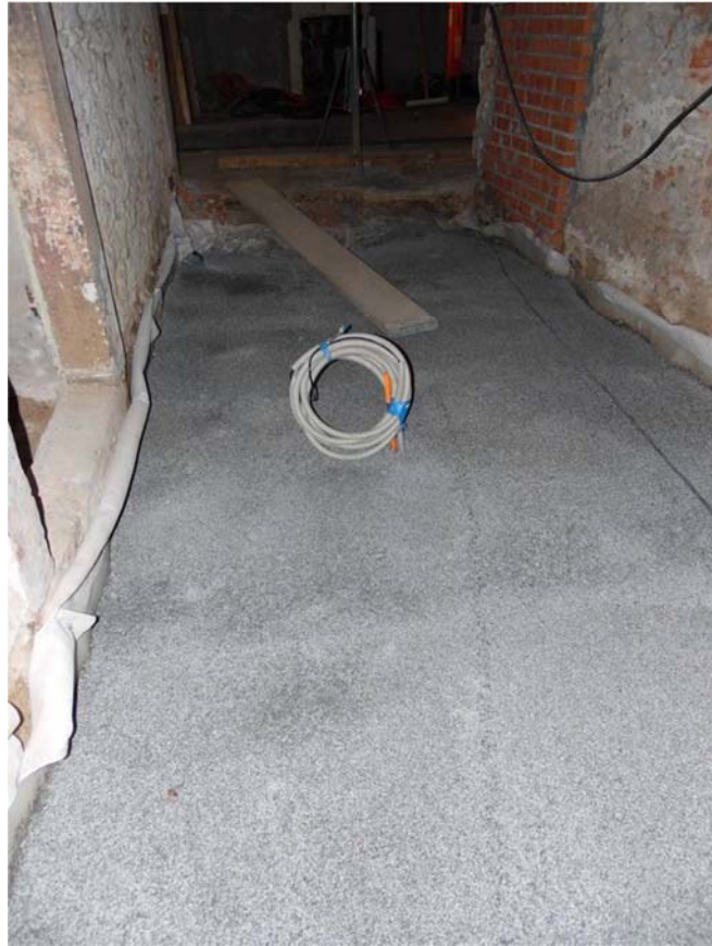
Abb. 18 Einbau des Rohfußbodens aus Porenbeton zur anschließenden Installation von Leitungen
