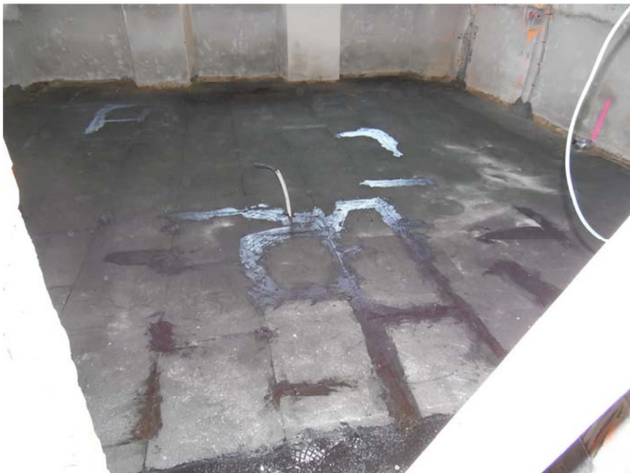
Abb. 27 Eingebaute und verklebte FOAMglas-Platten
