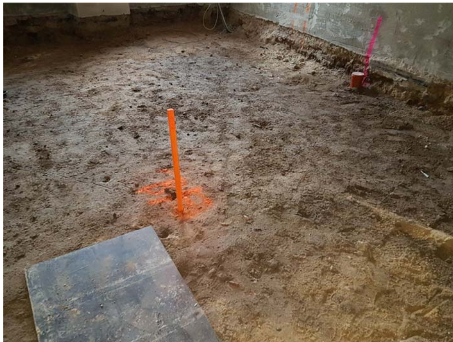
Abb. 25 Einbau der Sensoren unterhalb des Fußbodenaufbaus (im Bild an markierter Stelle)
