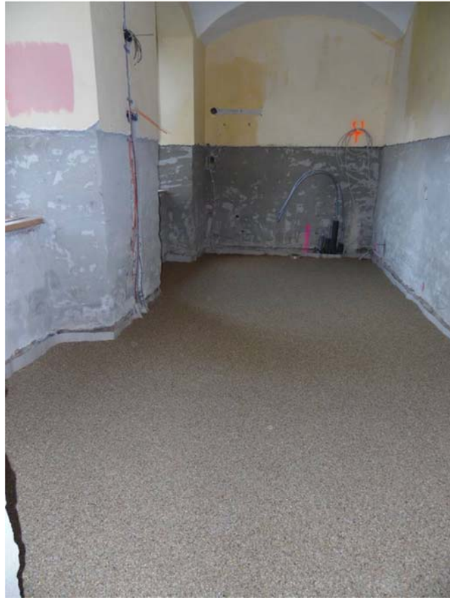
Abb. 12 Fertiggestellter Drainage-Estrich
