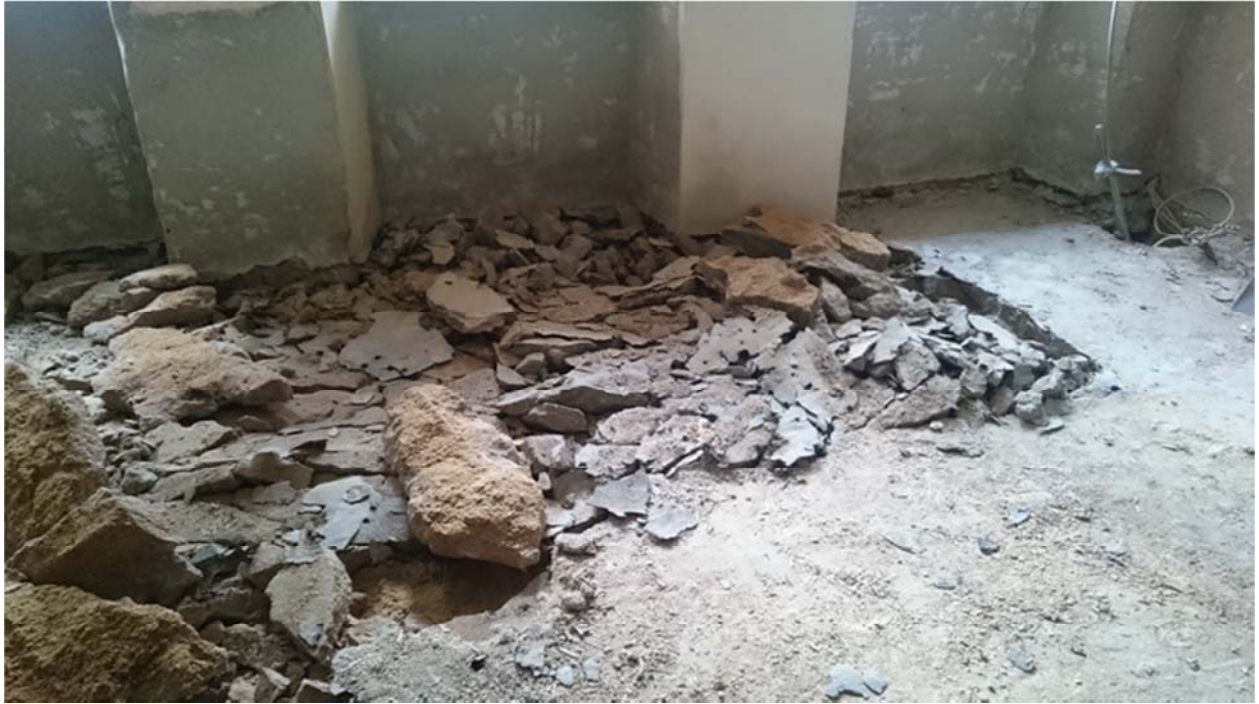
Abb. 24 Abbruch der geschädigten Bestandsfußböden
