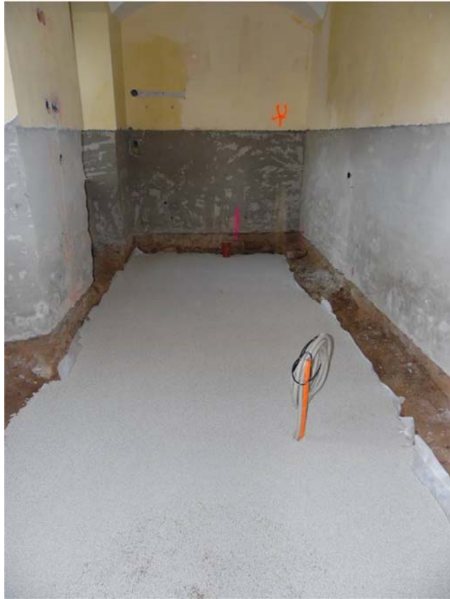
Abb. 10 Einbau des Rohfußbodens zur anschließenden Installation von Leitungen
