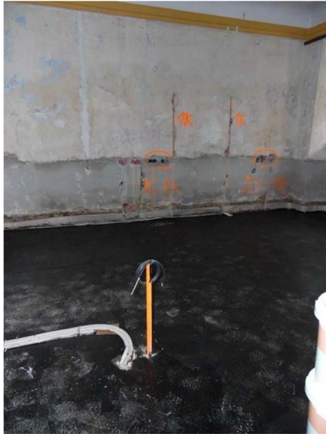
Abb. 28 Eingebauter Sensor im Fußbodenaufbau
