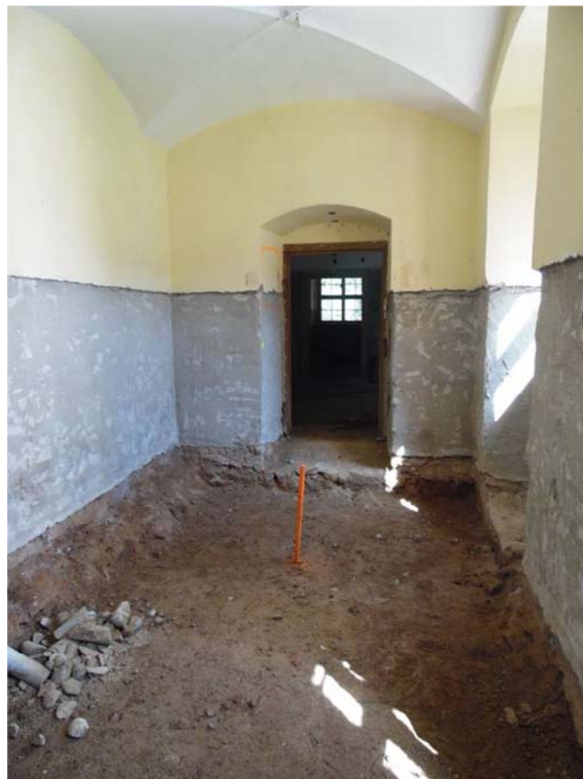
Abb. 9 Einbau der Sensoren unterhalb des Fußbodenaufbaus (im Bild an markierter Stelle)
