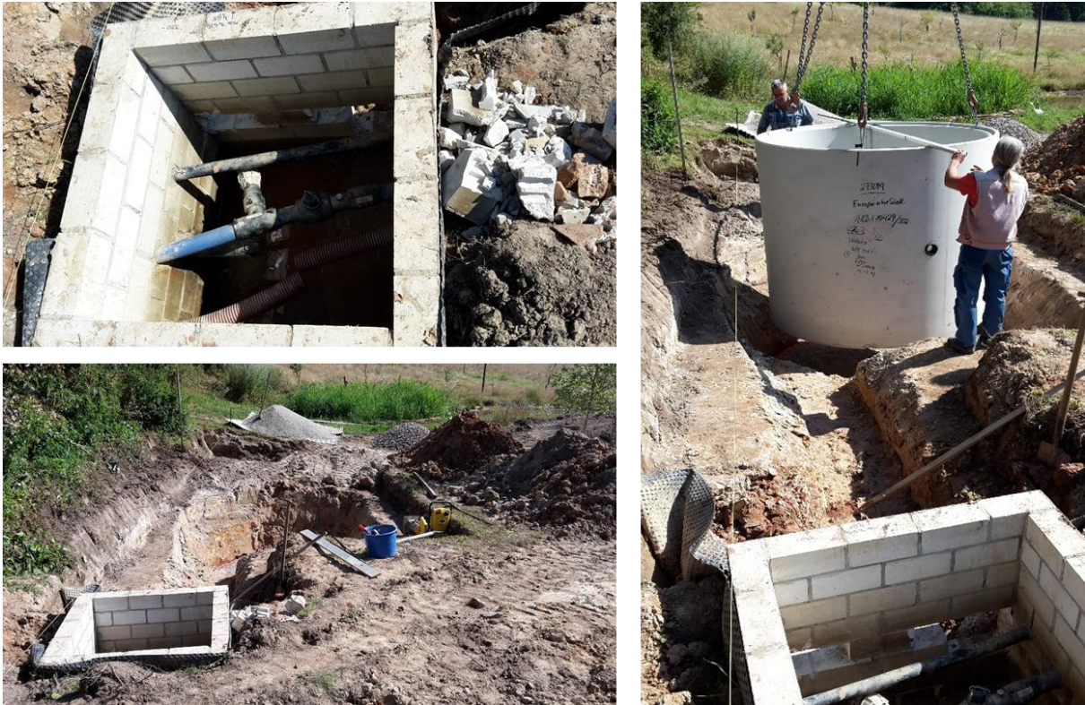
Abbildung A 4.29: linksoben: Schacht für Urinleitung und Trinkwasserleitung neben dem Forschungshaus; linksunten: Aushub für den Beton-Schacht unter dem Forschungshaus; rechts: Einbringen des Beton-Schachtes
