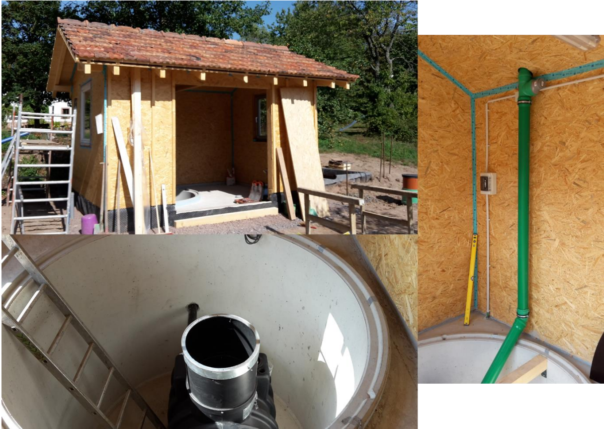
Abbildung A4.31: linksoben: Forschungshaus im Bau; linksunten: Urinlagertank im Betonschacht; rechts: Abluftleitung vom Urinlagertank über das Dach des Forschungshauses
