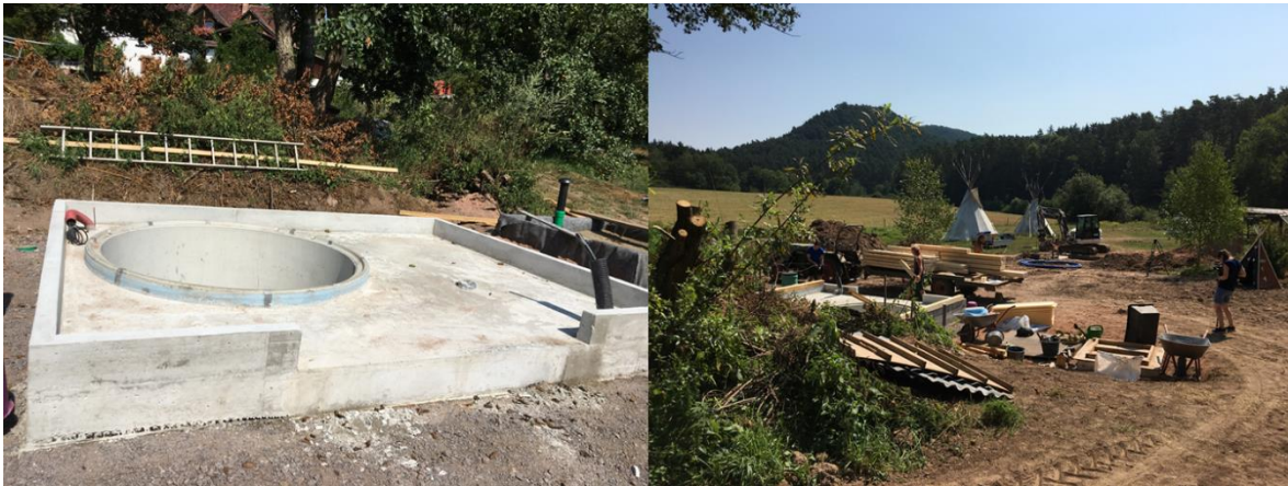
Abbildung A4.30: links: Fundament für das Forschungshaus; rechts: Baustelle Forschungshaus
