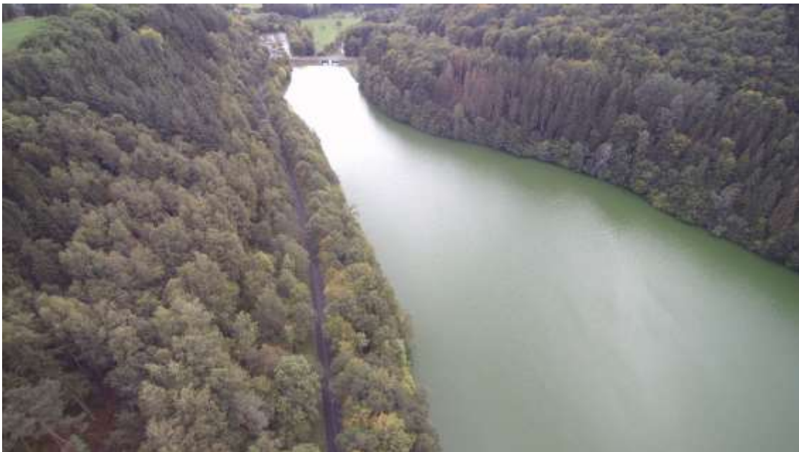
Luftaufnahme des Untersuchungsgebietes Stausee Bitburg mit Blick auf die Staumauer
