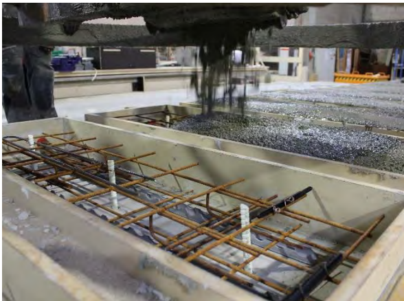
Abbildung 74: Betonage der Tragschicht mit Betonierkübel.
