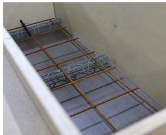
Abbildung 65: Bewehrung der Vorsatzschicht.
