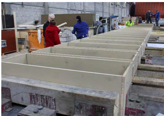
Abbildung 64: Schalungen auf dem Rütteltisch.
