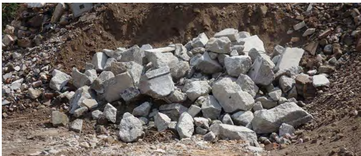
Abbildung 16: Abbruch der Brückenkappe.
