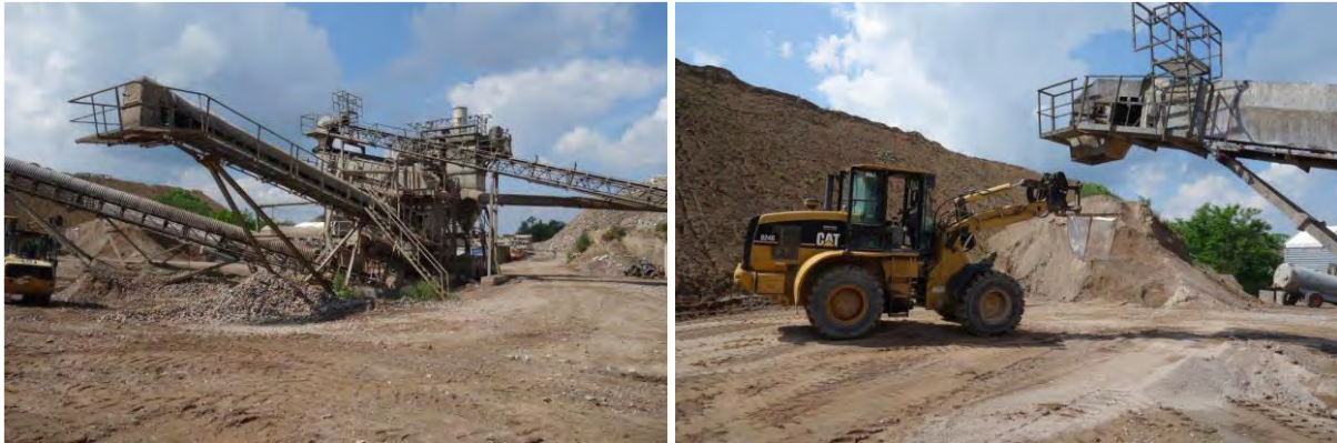
Abbildung 17: Anlage SHW Messel.
