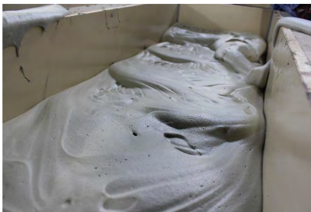
Abbildung 68: Eingebrachter mineralisierter Dämmschaum.
