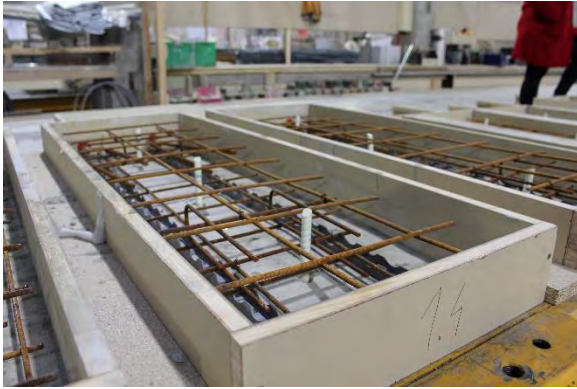
Abbildung 72: Bewehrung der Tragschicht.
