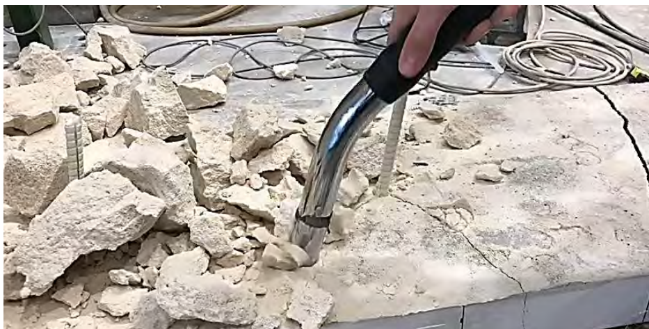
Abbildung 87: Kombination aus Trennen und Absaugen.
