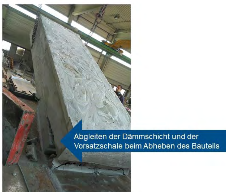
Abbildung 57: Abgleiten von Schichten bei fehlender Verbindungstechnik.
