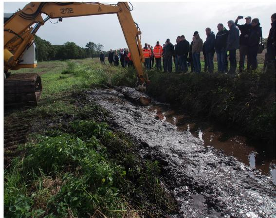
*Für eine durchgängige Abflussrinne erfordert das seitliche Einschwenken wesentlich mehr Konzentration, als die jetzt mögliche Korbführung im Längsprofil.*
