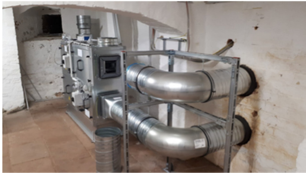
Abb. 2.1-04: Neue Lüftungsanlage mit klimasensorischer Steuerung im Keller unter der Schlosskapelle, 2019 (Foto SBLH)
