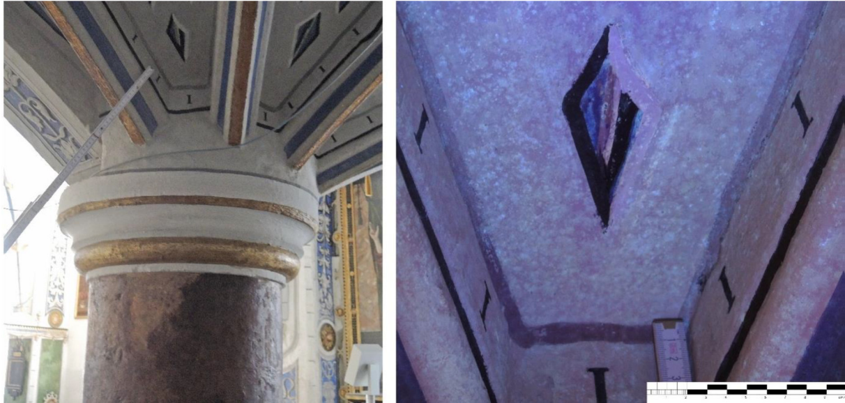
Abb. 2.6-02: Fotocollage: Schlosskapelle Celle, Prieche 12 im 1. OG, Referenzfläche 1.Empore1; links: Probeentnahmestelle im Zwickel; rechts: hell fluoreszierende Schimmelpilzkolonien bei UV-Anregung
