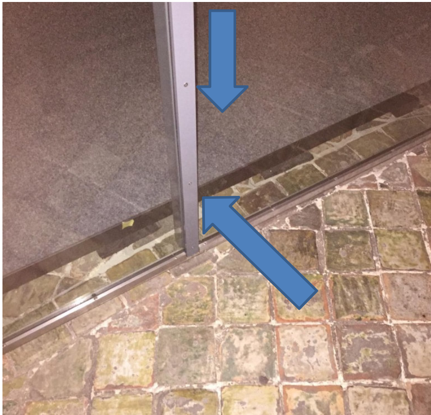
Abb. 2.8-06: Unterer Abschluss der Glaswand
