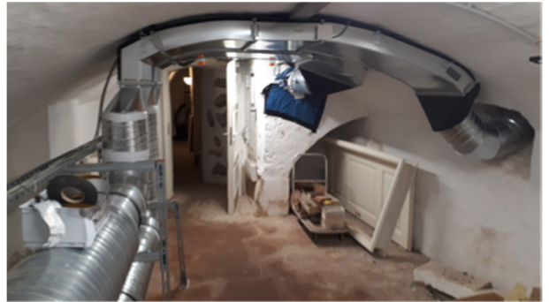
Abb. 2.1-04: Neue Lüftungsanlage mit klimasensorischer Steuerung im Keller unter der Schlosskapelle, 2019 (Foto SBLH)
