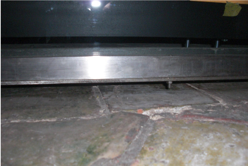
Abb. 2.8-07: Schlitz unterhalb der Glaswand zwischen Kapelle und Besucherraum
