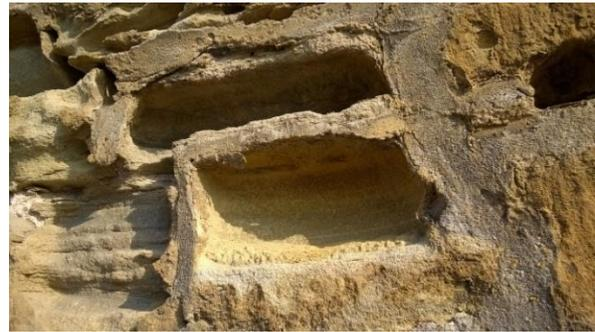
Abb. 133: Herauswittern von Steinbereichen mit geringerer Festigkeit (Alveolarverwitterung). Das im Vergleich zum Stein witterungsresistentere (zu feste und dichte) Fugenmaterial bleibt bestehen.
