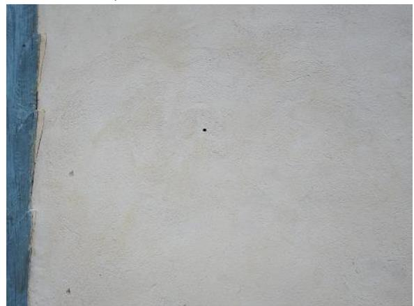
Abb. 146: Glattputz-Oberfläche nach dem Kalkanstrich mit Ausbildung des Anschlusses zu den Palmetten (aus BUBNICK 2017)
