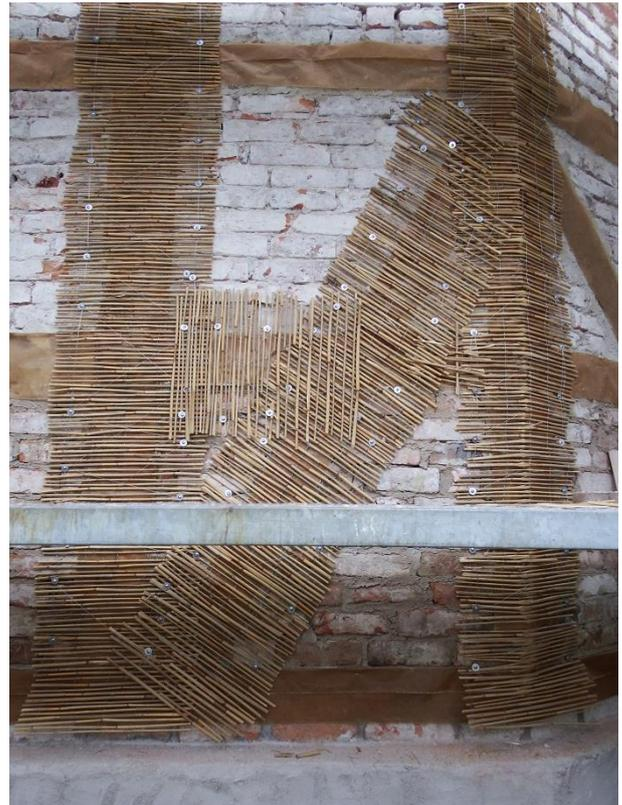
Abb. 138: Ansatz des Schilfrohrputzträgers zur Abkoppelung des Fachwerks vom Putz (aus BUBNICK, 2017)
