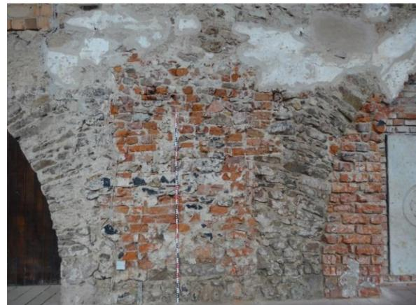
Abb. 86: Nordseite, zwischen den Bögen, Ziegel/Bruchstein, Sockel, Übersicht des Bereichs der Probenahmepunkte in Profil TP2: TP2\_1 ca. 30 cm und TP2\_2 100 cm über FOK
