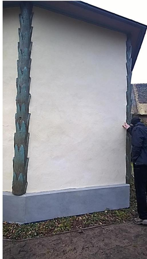
Abb. 148: Sehr gut stehende Putzoberfläche nach einer Standzeit von 2 Jahren. Risse werden auf die auf Bewegungen der frischen Palmettenhölzer zurückgeführt.
