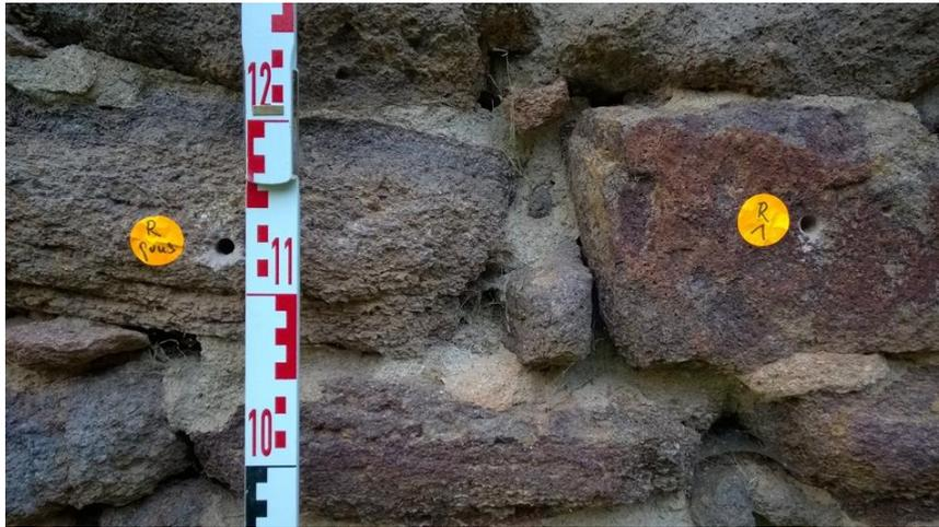
Abb. 46: Kloster Buch, Langhausmauer, Südseite, Probenahmepunkte für Voruntersuchungen in einem stark verwitterten (mit vergruster Oberfläche, R\_Grus) und einem weniger verwitterten Porphyr-Gestein (h=110 cm)
