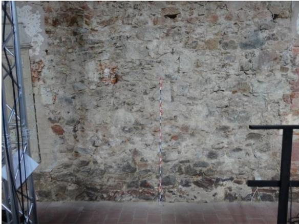
Abb. 87: Nordseite, neben Bühne, Sockel, Übersicht des Bereichs der Probenahmepunkte in Profil TP3: TP3\_1 ca. 40 cm und TP3\_2 100 cm über FOK
