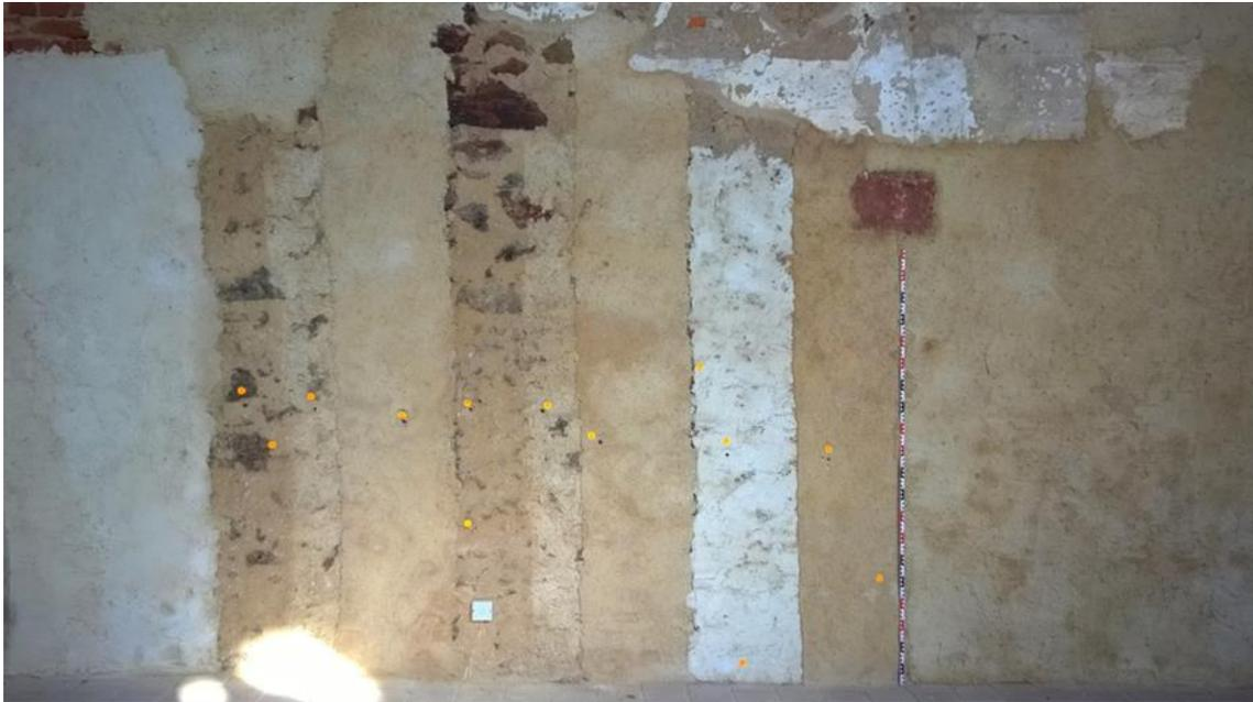
Abb. 118: Nachuntersuchungen der Salzbelastung an Musterflächen in der Klosterkirche Grimma, Probenahmepunkte TP1 bis TP9, Probenahme nach ca. 3 Jahren Standzeit
