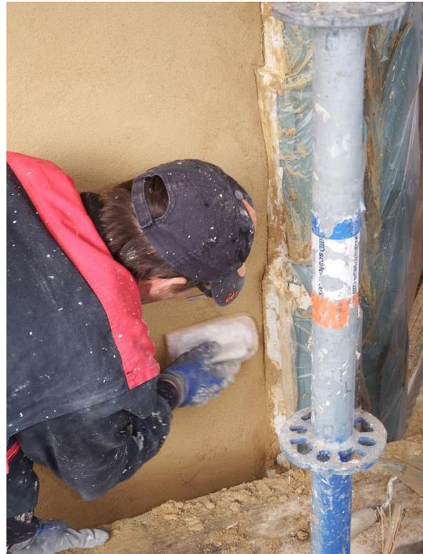
Abb. 144: Ausreiben des Oberputzes mittels abgerundetem Reibebrett (aus BUBNICK 2017)
