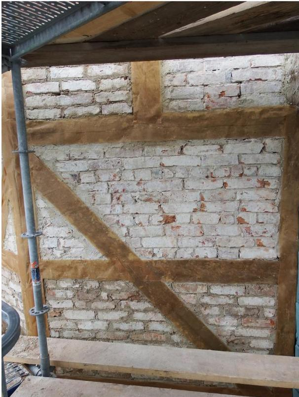
Abb. 137: Fachwerkwand mit Ölpapierabdeckung zur Abkoppelung des Fachwerks vom Putz (aus BUBNICK, 2017)
