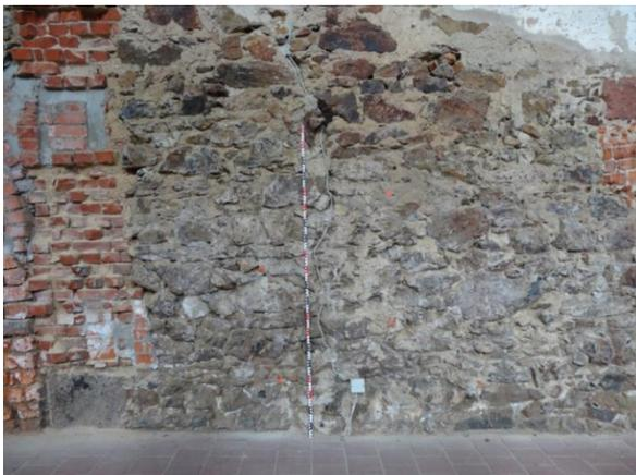
Abb. 85: Nordseite, östlich des Bogens, Bruchstein, Sockel, Übersicht des Bereichs der Probenahmepunkte in Profil TP1: TP1\_1 (ca. 35 cm über FOK), TP1\_2 (ca. 105 cm über FOK) und TP1\_3 (ca. 160 cm über FOK). TP1\_1A befindet sich rechts neben dem Profil TP1\_1
