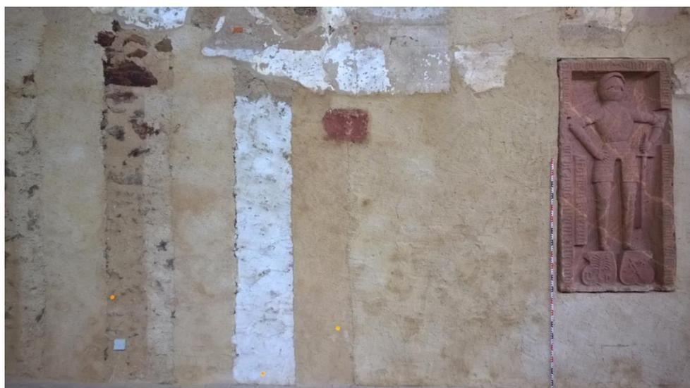
Abb. 117: Ausblühsalze im Bereich der Musterflächen, Probenahmepunkte ES1 bis ES3
