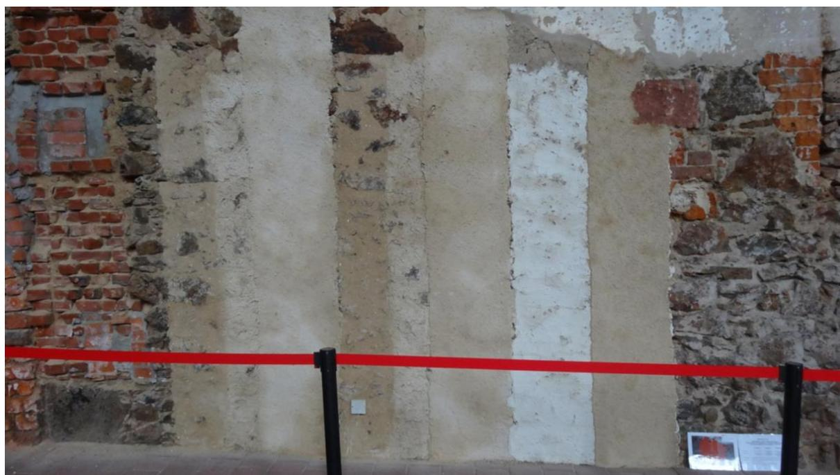
Abb.95: Im Mai 2015 angelegte Putzmusterflächen an der Nordwand der Klosterkirche in Grimma, auf der linken Seite die mit Heißkalkmörtel ausgeführten Flächen (Probefläche 1 in Abb. 96).
