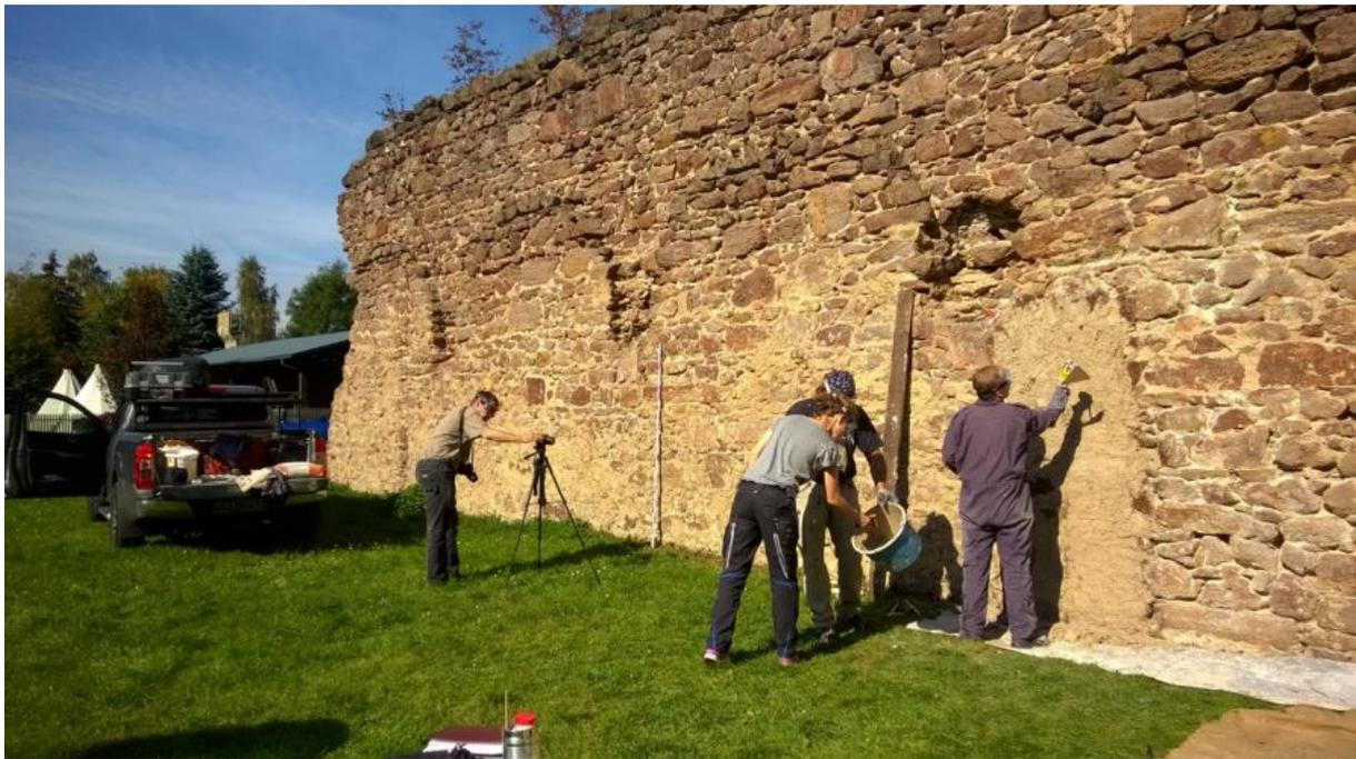
Abb. 56: Kloster Buch, Anlage und Dokumentation der Musterflächen zum Vergleich Heißkalkmörtel (HK) und trocken gelöschter Kalkmörtel (TK) am 30.09.2017 im Rahmen des 1. Heißkalkworkshops an der Südwand des ehemaligen Langhauses (Langhausmauer)
