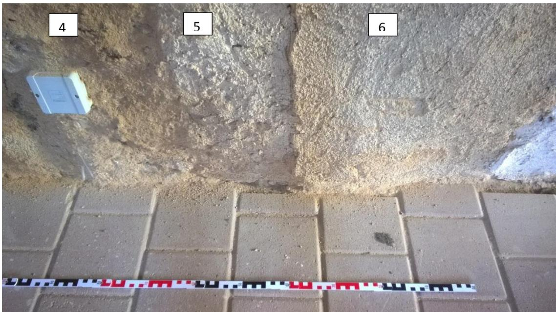
Abb. 98: Dokumentation der Oberflächenmaterialverluste
