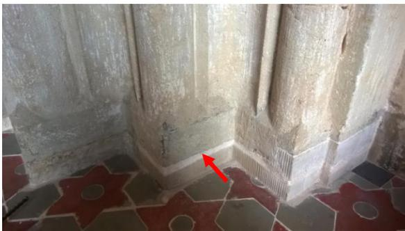
Abb. 150: Einsatz einer Vierung im Bereich der Basis des südlichen Pfeilers der Südarkade
