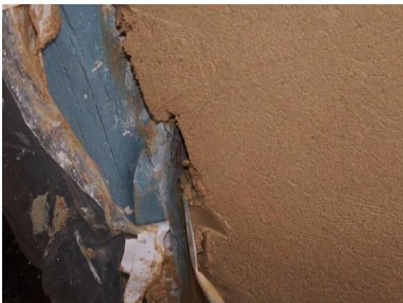
Abb. 145: Glattputz-Oberfläche nach dem Reiben und vor Ausbildung des Anschlusses zu den Palmetten (aus BUBNICK 2017)
