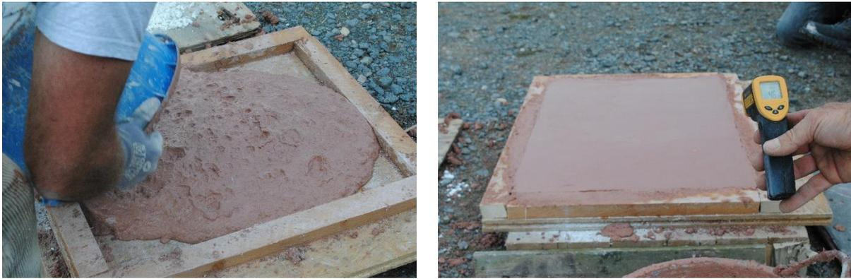
Abb. 2: Herstellung eines Estrichmörtels aus Heißkalk. a) Ausgießen des Mörtels in die Form, b) Mörtel nach Abziehen der Oberfläche (die Temperaturmessung nach Abschluss der Verarbeitung zeigt noch 46 °C Oberflächentemperatur)
