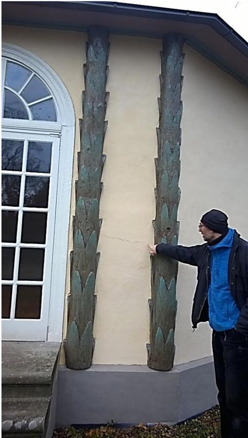
Abb. 147: Sehr gut stehende Putzoberfläche nach einer Standzeit von 2 Jahren. Risse werden auf die auf Bewegungen der frischen Palmettenhölzer zurückgeführt.
