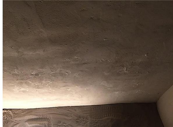
Abb. 129: Krypta, Südwand, Putz mit Effloreszenzen im Sockelbereich. Salze können leicht von der Oberfläche abgesaugt werden. Aufnahme am 27.03.2019
