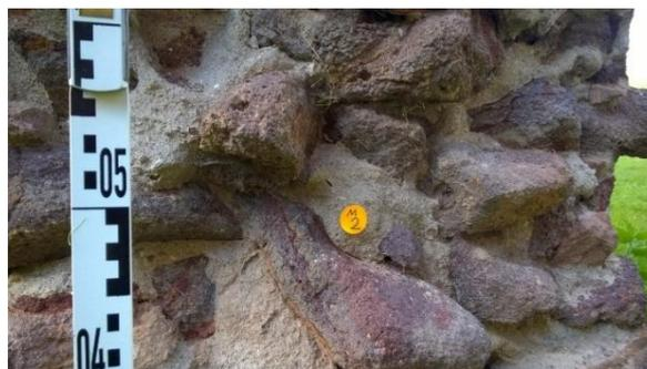
Abb. 50: Kloster Buch, südliche Langhauswand, Durchbruch an der Ostseite: Probenahmepunkt M1 (historischen Putz- und Fugenmörtel)
