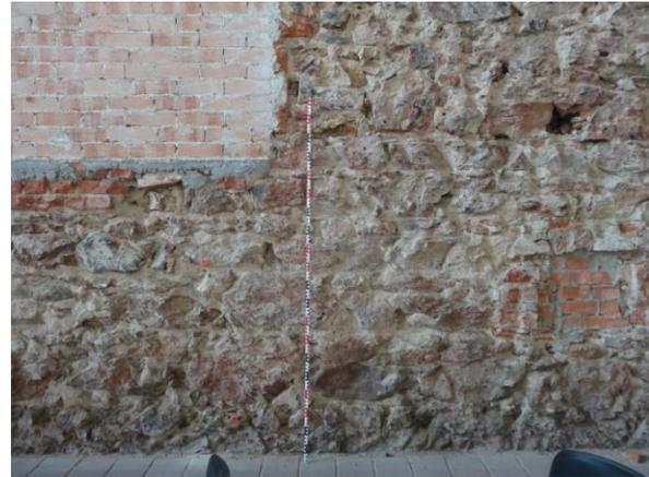
Abb. 88: Südseite, Sockel, Probenahmepunkte ca. 25 cm und 105 cm über FOK
