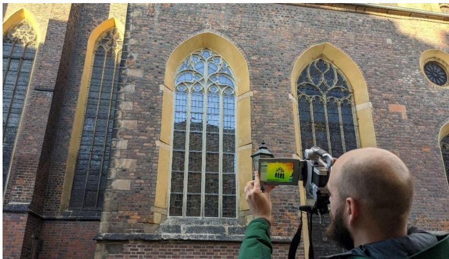
Abb. 14: Thermografische Untersuchungen an der Südfassade der Liebfrauenkirche in Liegnitz.
