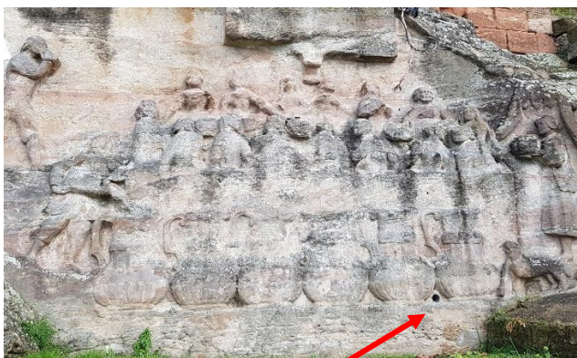
Abb. 117: Verortung des Bohrkerns im Relief Hochzeit zu Kana (Pfeil) im unteren Bereich, hellgraue, mittelkörnige Varietät und in der Maßnahmenkartierung (Pfeil), unweit von zwei durch blau Punkte markierte Injektionslöcher bzw. unterhalb zweier Bohrlöcher und damit ungefähr auf Höhe derer tiefsten Stellen.
