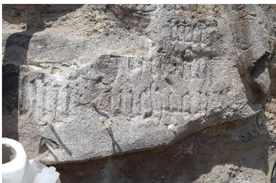
Abb. 150: Mit Heißkleber eingesetzte und fixierte Schläuche zur Injektion bzw. zur Entlüftung
