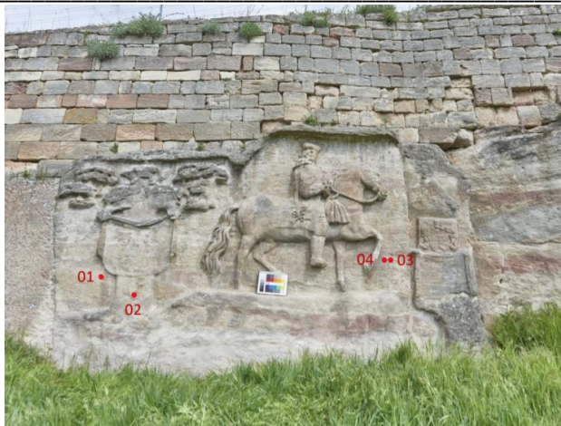
Abb. 109: Relief Herzog Christian (MP 01). Ebenfalls typisches Kurvenprofil für zähe feste Oberflächen: erhöhte Festigkeit zwischen 1 - 3,5 mm (Höchstwert 13,3 N; ca. 3x so hoch wie Mittelwert „normal“), keine Mürbzone, „normal“ ab 4 mm (Werte zwischen 3,4 - 5 N)
