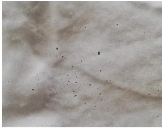
Abb. 165: Kleine Löcher im Mörtel als Folge von Lufteinschlüssen an der Silikonform.
