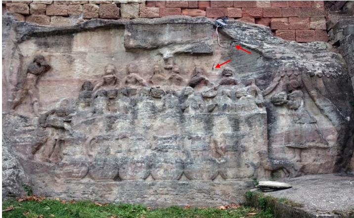
Abb. 35: Relief Hochzeit zu Kana . Impedanz- und Bohrlochklimasensoren (10 cm Tiefe) sind im Bereich der beiden Pfeile installiert worden. 87
