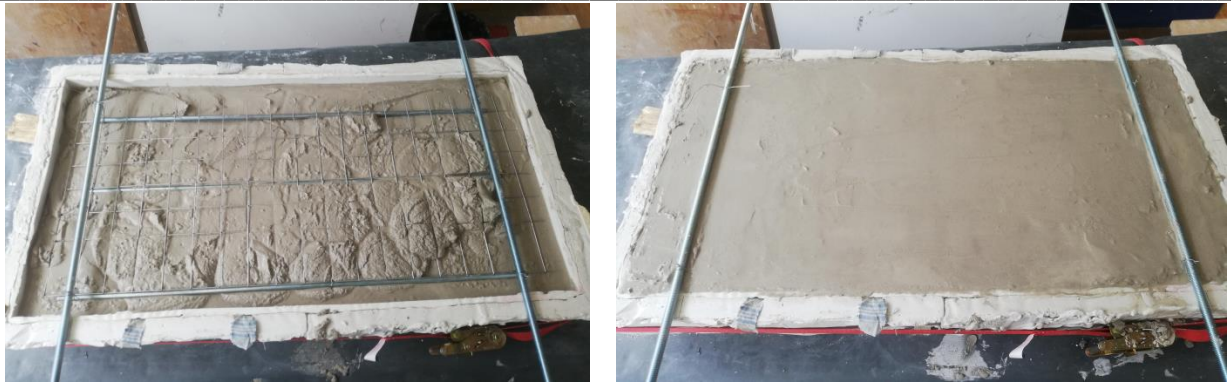
Abb. 163: Die vorbereitete Armierung wird in die Gussform eingelegt und vorsichtig in den Mörtel gedrückt (links). Anschließend wird komplett mit Mörtel aufgefüllt (rechts).
