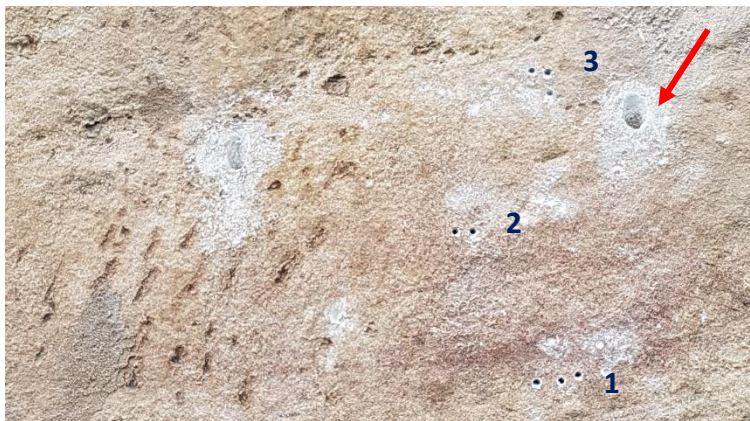
Abb.: 139: Anordnung der Bohrlöcher der Bohrwiderstandsmessungen, in Bezug auf das Bohrloch für die Injektion (Pfeil)
