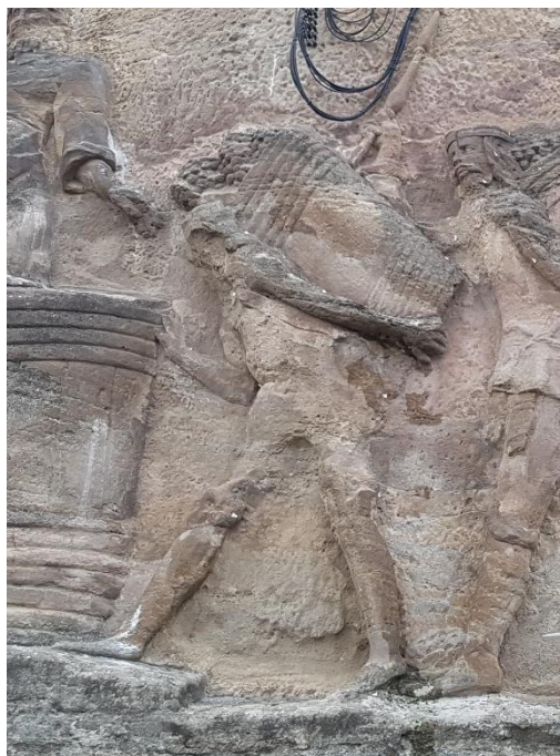
Abb. 34: Erste Figur rechts der Kelter im Relief Christus in der Kelter mit massiven Fehlstellen u.a. im Oberschenkelbereich und Oberkörper sowie einem relativ hohen Anteil an Ergänzungen. Die Fehlstellen scheinen mürbe und sind damit auch aktiv.
