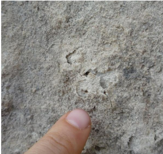
Abb. 121: Zäh, spannungsreiche Oberfläche mit Pusteln, darunter sandend – Überfestigung oder Interaktion mit Gips, Relief Herzog Christian , linker Bereich
