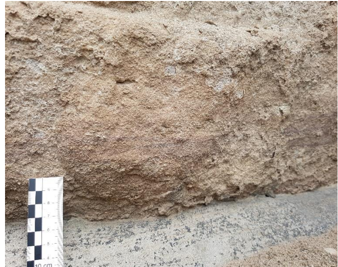
Abb. 122: Relief Hochzeit zu Kana: schuppiger und körniger Materialverlust. Auch hier sind helle Ränder und Flächen zu erkennen, bei denen es sich ebenfalls vermutlich um kristallisierte Salze handelt.
