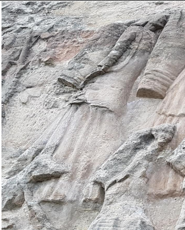
Abb. 30: Linke Figur im Relief Christus in der Kelter mit einem relativ hohen Anteil an Ergänzungen bzw. Verlusten von Originalmaterial. Starke Rückwitterung auch im unteren Gewandbereich.
