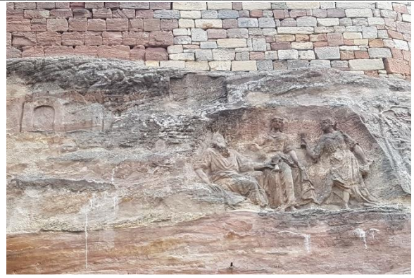
Abb. 149: Umfeld des Reliefs Lots Berauschung mit Ablaufspuren des nicht geeigneten Injektionsmörtels (Anwendung P. Fiedler) unter dem Relief und weiter zum linken Bildrand.
