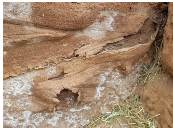
Abb. 96: Großflächige schalige Ablösungen, deren Bindemittel zumindest teilweise aus Gips besteht (plastisch verformt). Auch andere Salze sind in der Umgebung auskristallisiert (Nitrate). Das dargestellte Phänomen liegt im bodennahen, umgestalteten Bereich, westlich des Reliefs Lots Berausung .
