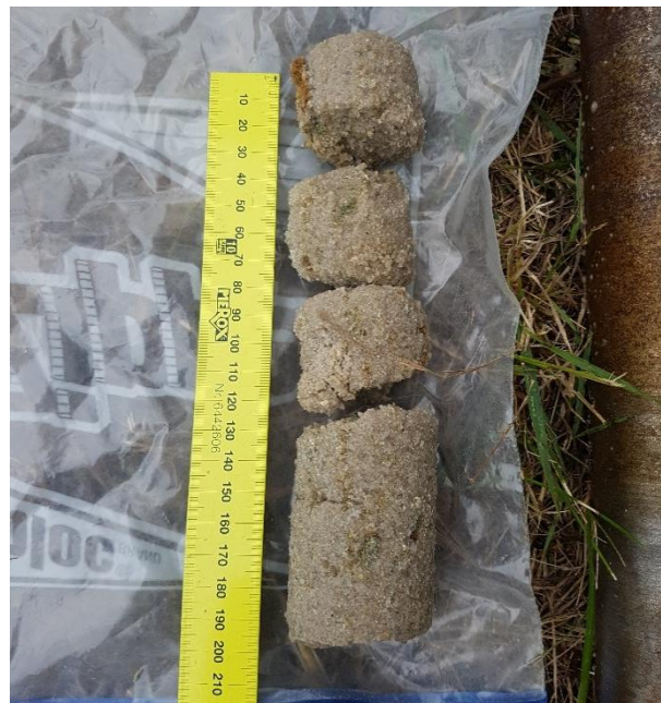
Abb. 125: Gewonnener Bohrkern, der einen relativ bröseliges, instabiles Material repräsentiert.
