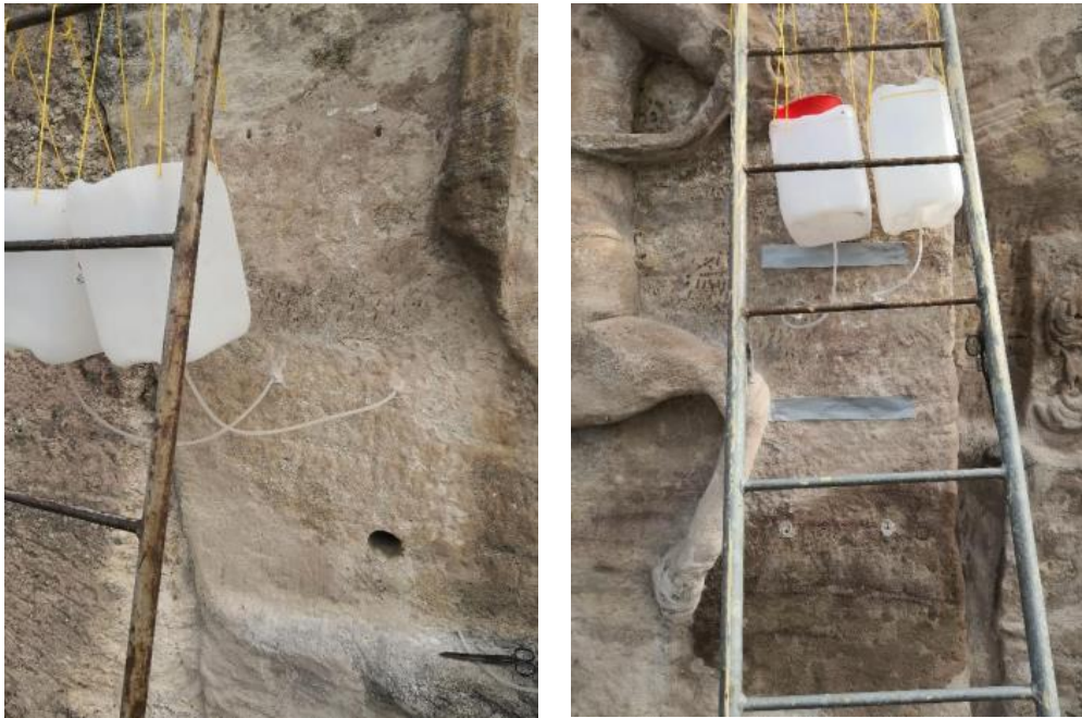
Abb. 133: Aufhängung der Behälter mit dem KSE, für einen möglichst knickfreien Verlauf der Schläuche
