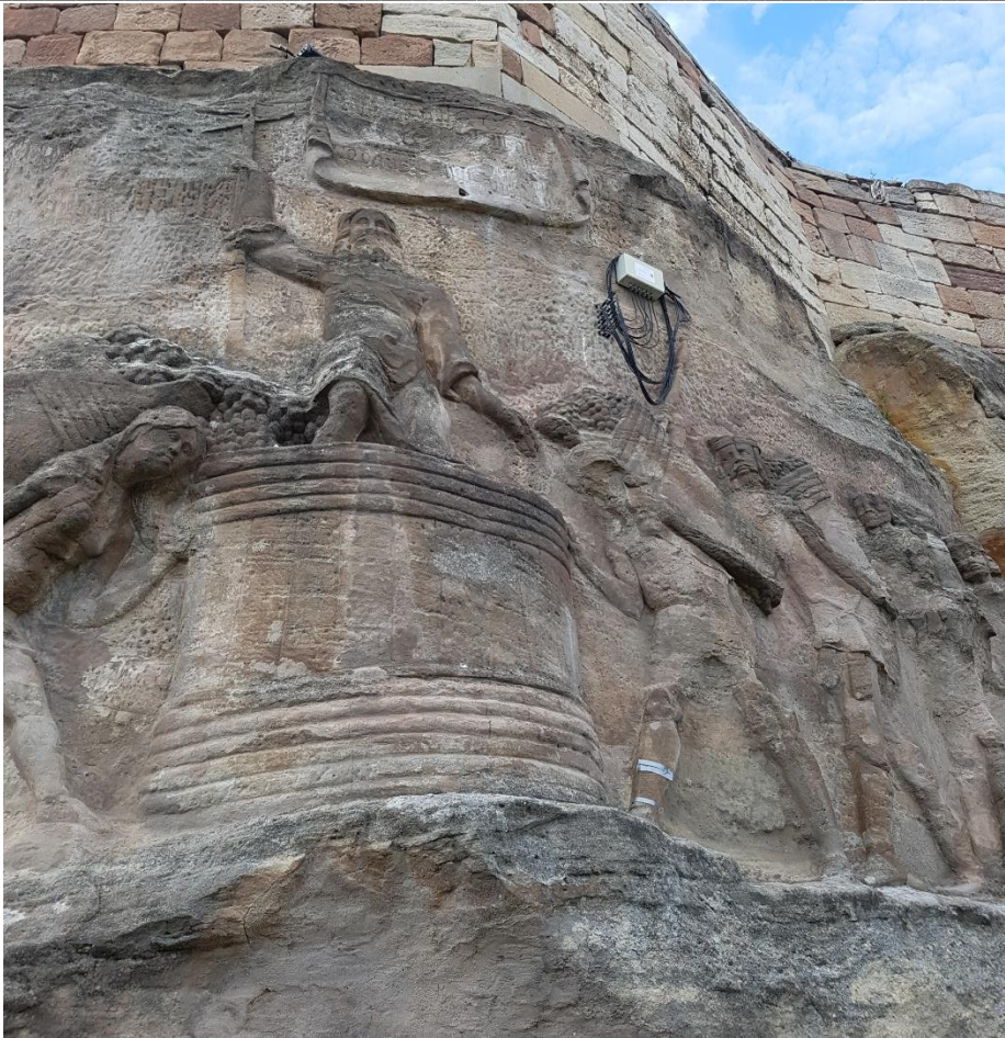
Abb. 9: Relief Christus in der Kelter (zentraler Bereich), Juli 2020
