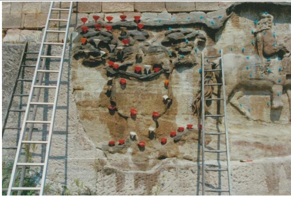
Abb. 113: Situation der Injektionsfestigung über auf Bohrlöcher aufgesetzte Trichter im Zuge der umfassenden Restaurierungskampagne 1998/99 am Bereich des Reliefs Herzog Christian
