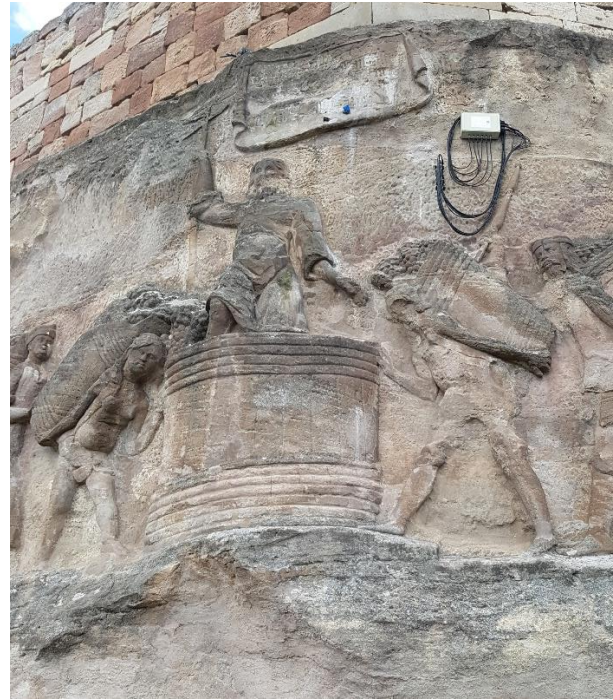
Abb. 15: Zustand 2021, Relief Christus in der Kelter . Die Rückwitterungen im Beinbereich der Person rechts der Kelter sind deutlich vorangeschritten.
