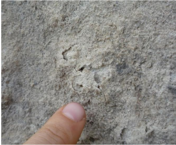
Abb. 94: Zähle, spannungsreiche Oberfläche mit Pusteln, darunter sandend – Überfestigung oder Interaktion mit Gips, Relief Herzog Christian , linker Bereich
