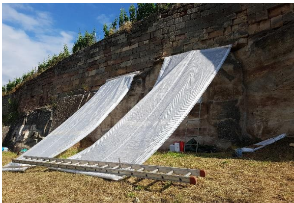
Abb. 129: Abplanung der Musterflächen. Wiederholung der Injektionsfestigung am Relief Herzog Christian
