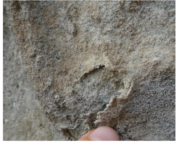
Abb. 95: Detail, spannungsreiche Pustel, darunter sandend, Relief Herzog Christian , linker Bereich
