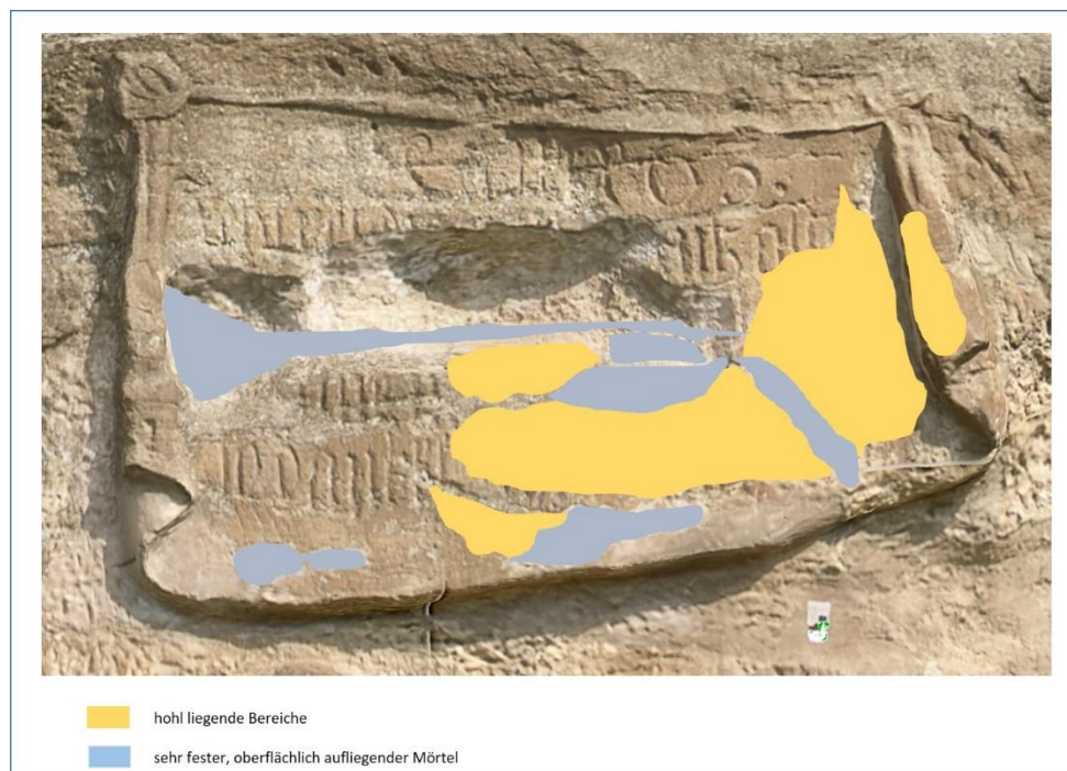
Abb. 147: Kartierung der Hohlstellen und Altergänzungen, die mittels sehr fester und nur oberflächlich aufliegender Mörtel in jüngerer Vergangenheit ausgeführt worden sind. Sie waren eigentlich zur Injektion gedacht, sind allerdings offensichtlich nicht in den Hohlraum eingedrungen, sondern hafteten auf der aufstehenden Flanke der Schale.
