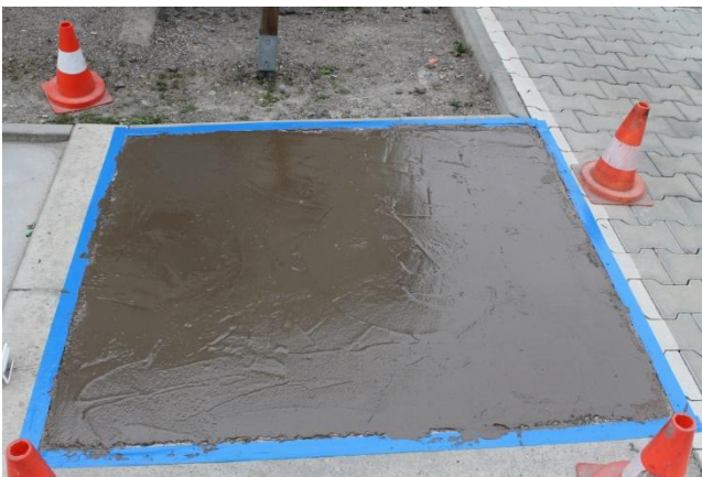
direkt nach dem Aufbringen des Spachtels
