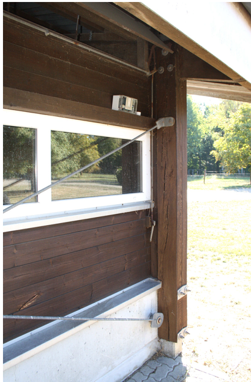
Abb. 65.: Messposition für Lufttemperatur und -feuchte sowie CO_2 -Konzentration im Außenbereich des Stalles
