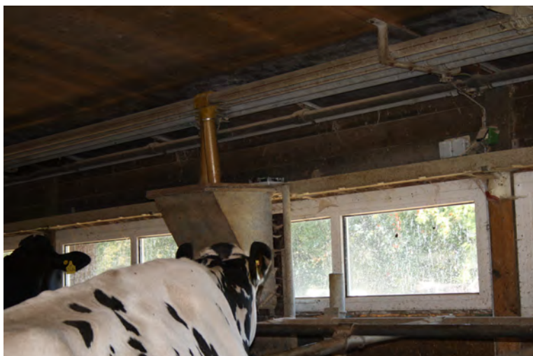
Abb. 64.: Messposition der CO_2 -Konzentration in der Luft im Bereich des Kraftfutterautomaten
