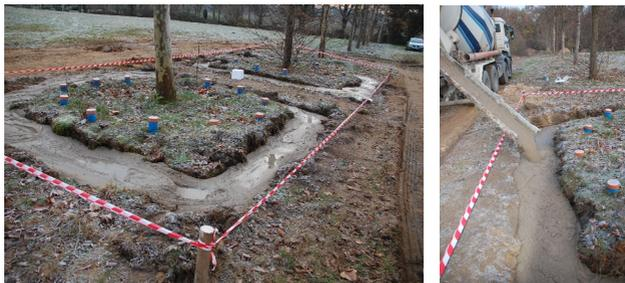
Abbildung 79: ZFSV kurz nach Einbau um die Versuchsbäume (links), Einfüllen des ZFSV in die Baugrube mit Fahrmischern (rechts)
