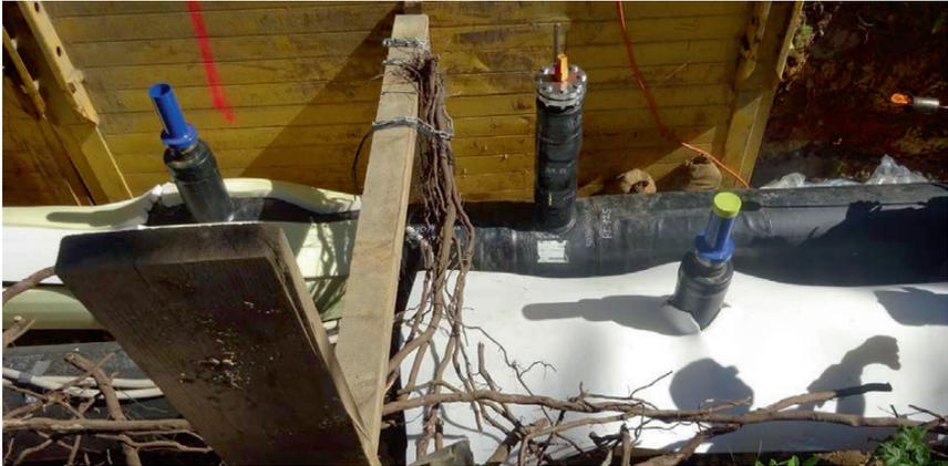
Abbildung 6: Armatur mit Dehnpolster (links) und mit Fließ umwickelten Dehnpolster (rechts)
