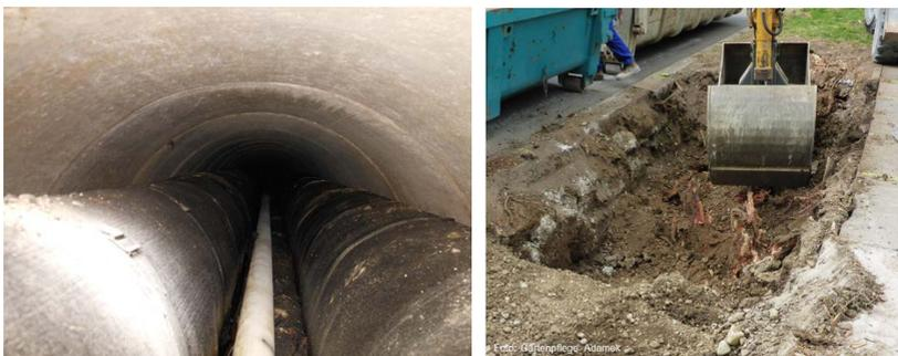
Abbildung 9: Blick in Haubenkanal, kein Wurzeleinwuchs sichtbar (links), Wurzel in Oberflächennähe (rechts, Bildquelle Gartenpflege Adamek)
