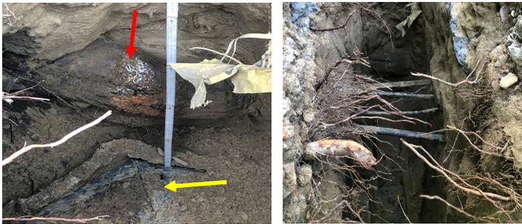
Abbildung 7: Starkwurzel (19 Zentimeter) neben der Fernwärmeleitung (links; roter Pfeil Wurzel, gelber Pfeil Fernwärmeleitung) und Wurzelwachstum oberhalb der Fernwärmeleitung (rechts)
