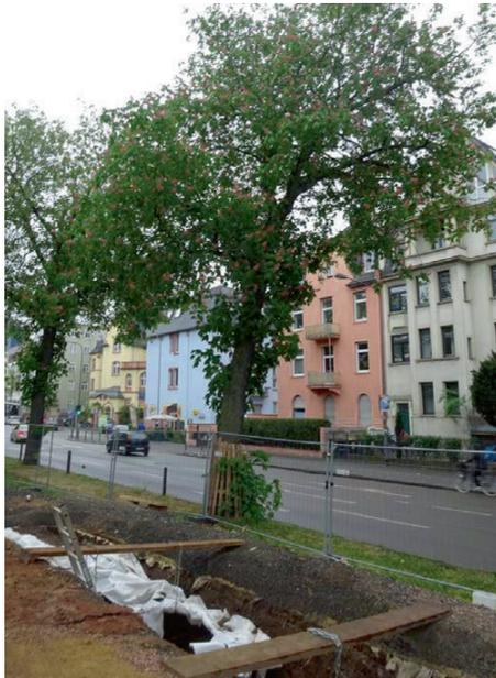
*Abbildung 4: Blick in den Rohrgraben mit geschützten Wurzeln; zentral im Bild Baum Nr. 2
