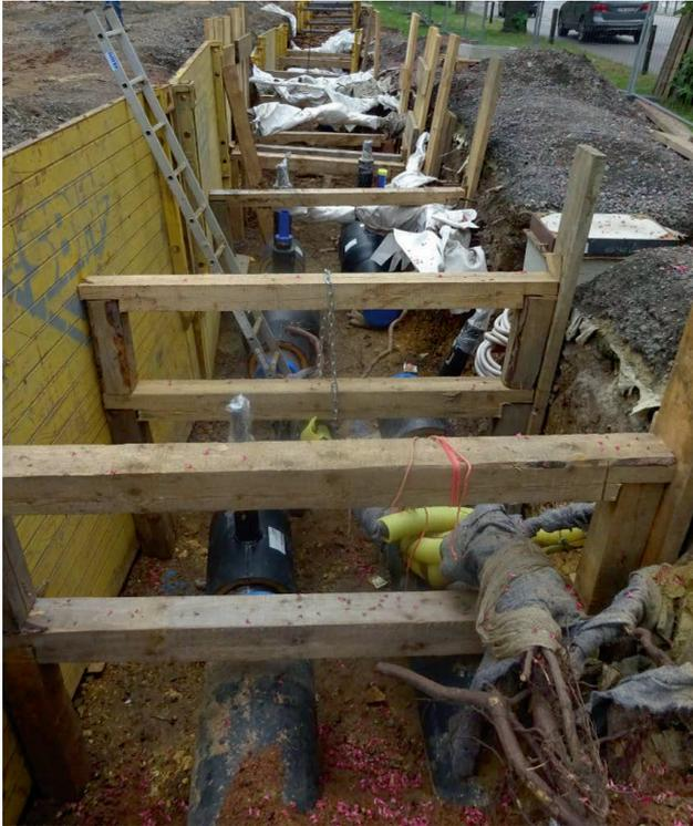
*Abbildung 5: Blick in den Rohrleitungsgraben mit installiertem Messschacht und ersten Armaturen*
