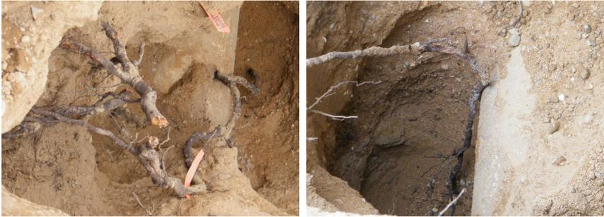
*Abbildung 1: Interaktion zwischen Wurzeln und Fernwärmerohrleitung, Vorlauf (links) und Rücklauf (rechts)*
