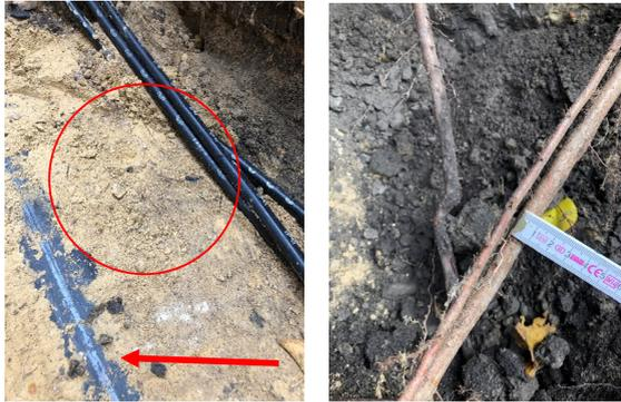
Abbildung 6: Feinwurzeln in Bettung der Fernwärmeleitung (links; roter Pfeil zeigt zur Fernwärmeleitung, eingekreist sind die Feinwurzeln, rechts im Bild das Telekommunikationskabel und Wurzeln, die an dem Telekommunikationskabel axial entlang wuchsen (rechts; ohne Telekommunikationskabel))
