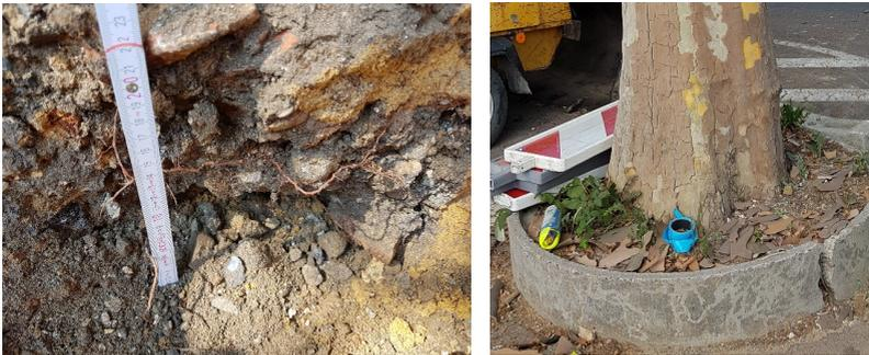
Abbildung 10: Vereinzelte Feinwurzeln an Grabenwand (links), hochgesetzte Baumscheibe (rechts)
