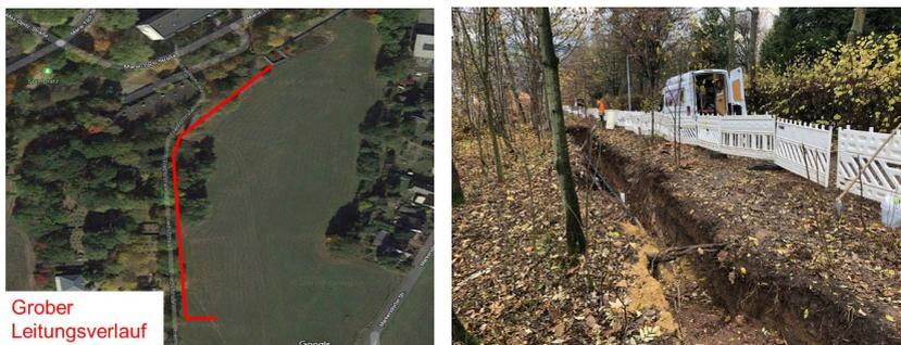
Abbildung 14: Darstellung der Situation (links: Trassenverlauf, rechts: Leitungsgraben mit querenden Wurzeln und Gehölzbestand)
