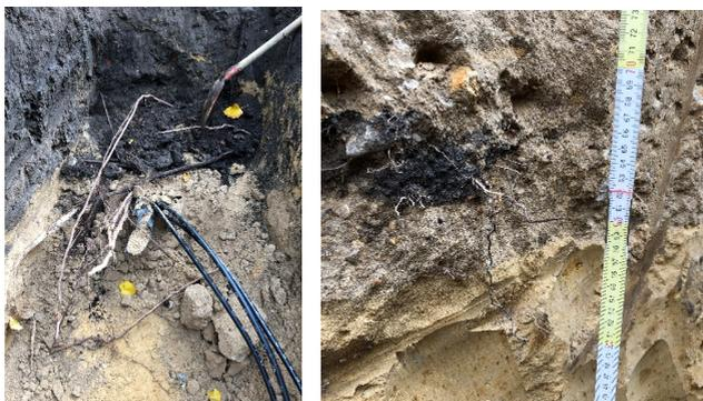
*Abbildung 13: Wurzelwuchs in Trennfläche zwischen Telekommunikationskabel und Bettung (links) und zwischen Sandbettung und Tragschicht (rechts) bei Aufgrabung Nr. 6*
