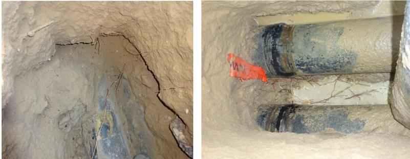
*Abbildung 3: Feinwurzeln in der Bettung bei Kopfloch 1 (links) und Feinwurzeln an und zwischen Vor- und Rücklauf bei Kopfloch 2 (rechts)*
