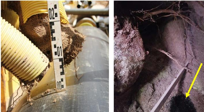
*Abbildung 4: Gekappte Starkwurzel nah an der Rohroberfläche während der Neubaumaßnahmen der Fernwärmetrasse 2013 (links; Bildquelle: ZORN Sachverständigen Büro Gartenbau) und an der Rohroberfläche während der anlassbezogenen Aufgrabung 2020 (rechts, gelber Pfeil zeigt die Rohroberfläche)*
