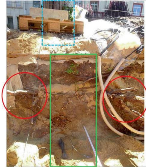
Abbildung 9: Blick auf die südliche Rohrgrabenwand; Bereich zur Anordnung der Messsensoren (grünes Rechteck), Wurzelbündel (rote Kreise) und Baum Nr. 2 (gestricheltes, blaues Rechteck)
