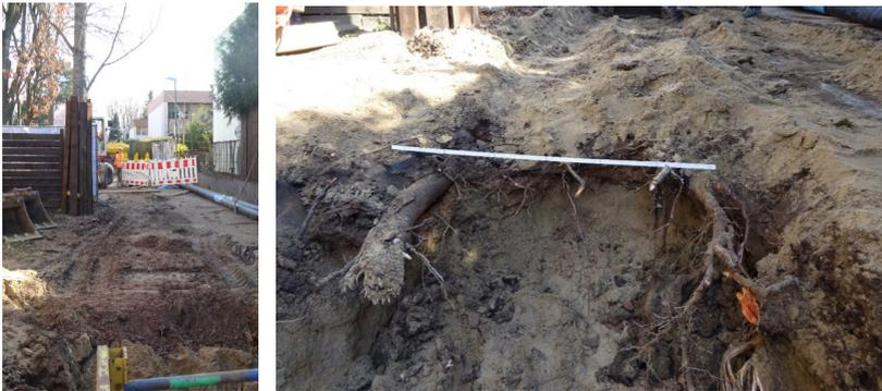
*Abbildung 11: Baum 1 direkt an Fernwärmetrasse (links), Wurzeln in 0,2 Metern Tiefe unter GOK oberhalb der Fernwärmetrasse in ca. zwei Metern Abstand von Baum 1 und fünf Metern Abstand von Baum 2 (rechts)*
