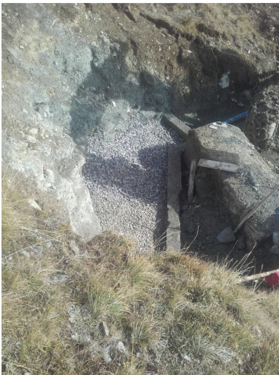
Einbringen des Drainagekieses
