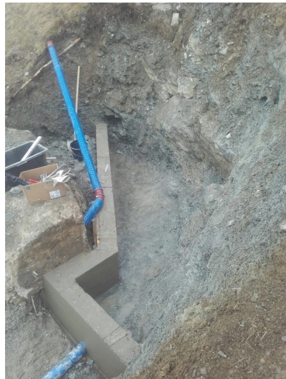
Betonriegel ausgeschalt
