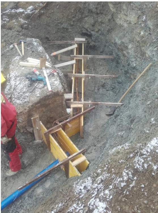
Schalen des Betonriegels
