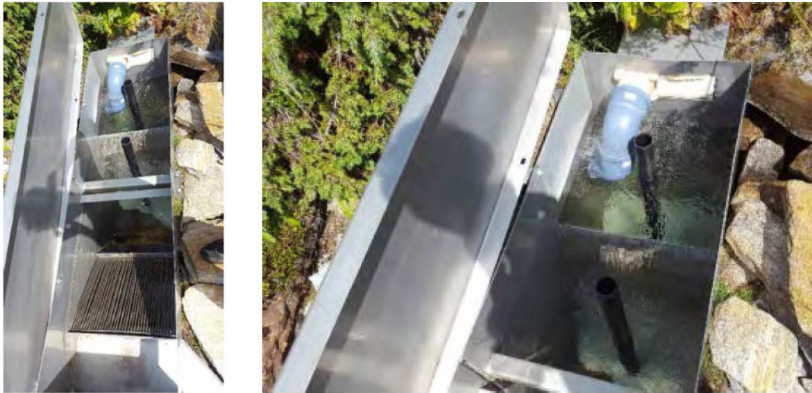
Abbildung 3-12: Sandfang bei Entnahme von Oberflächenwasser. Quelle Kostrouch
