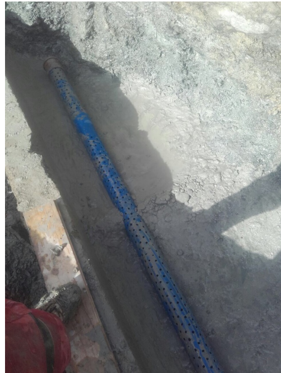
Verlegen des Sickerrohes
