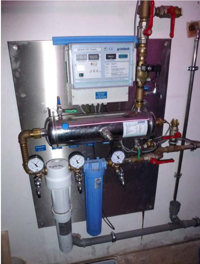
Abbildung 3-20: Zweistufige Partikelentfernung vor UV-Anlage. Quelle: DAV
