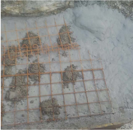
Stahleinlage für Betondeckel
