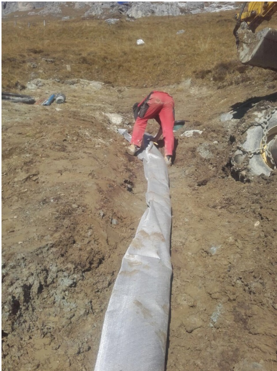
Verlegen der Ableitung zum Quellschacht
