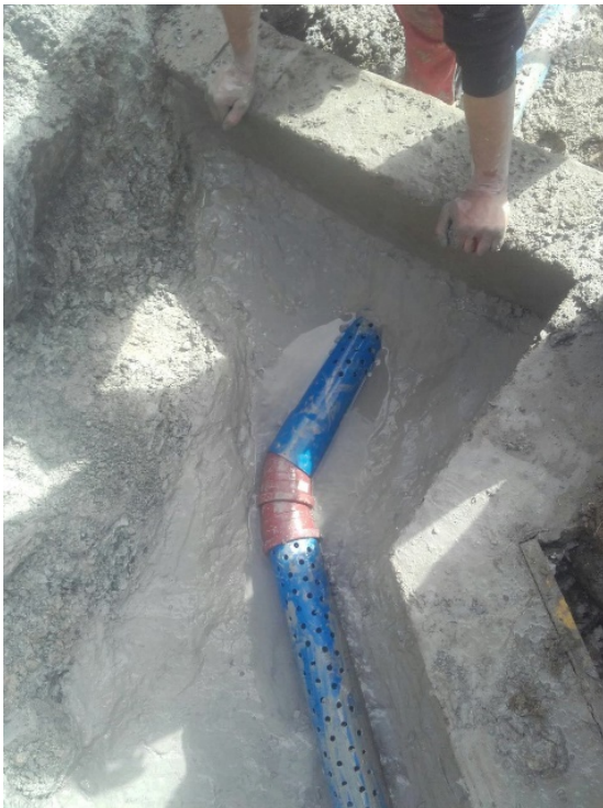
Untere Abdichtung mit Lehm
