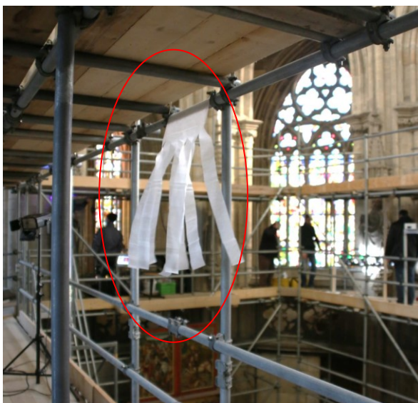
Abbildung 28: Seidenpapier- Installation zur Verdeutlichung von Luftbewegungen auf dem Gerüst.
