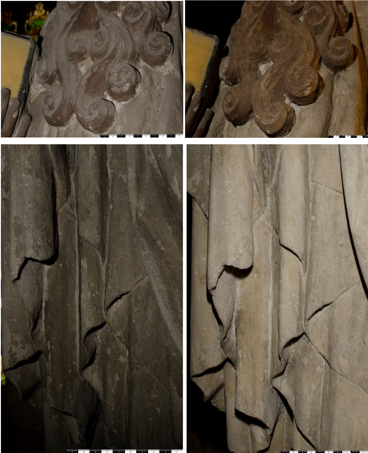
Abbildung 73 a-d: Oben (a-b) Bart des Hl. Paulus, vor der Reinigung mit eingebundener Auflage stark vergraut (links). Nach der Laserreinigung des Bartes (rechts). Die Konturen des Bartes sind wieder sichtbar. Unten (c-d) Gewandfalten der Skulptur des Paulus. Links (c) Vorzustand Rechts (d) Nach der Laserreinigung.
