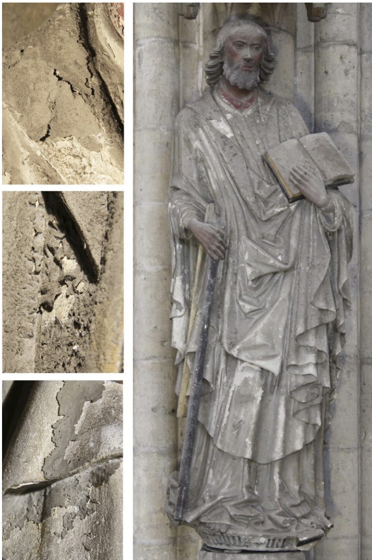
Abbildung 53: Heiliger Jakobus minor mit Fassungsschäden – Abstehende Malschicht, Aufplatzungen und einer fragilen porösen Malschicht.
