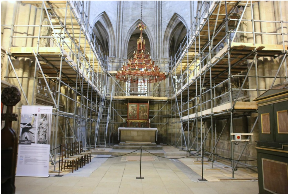
Abbildung 18: Blick in den Hohen Chor nach Osten mit erster Gerüststellung 2017.
