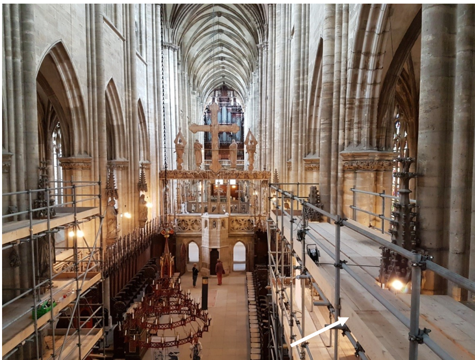
Abbildung 51: Aufzeichnung der Luftbewegung in Nord-Süd- und Ost-West-Richtung sowie in vertikaler Ausrichtung im nördlichen Bereich des Hohen Chores.
