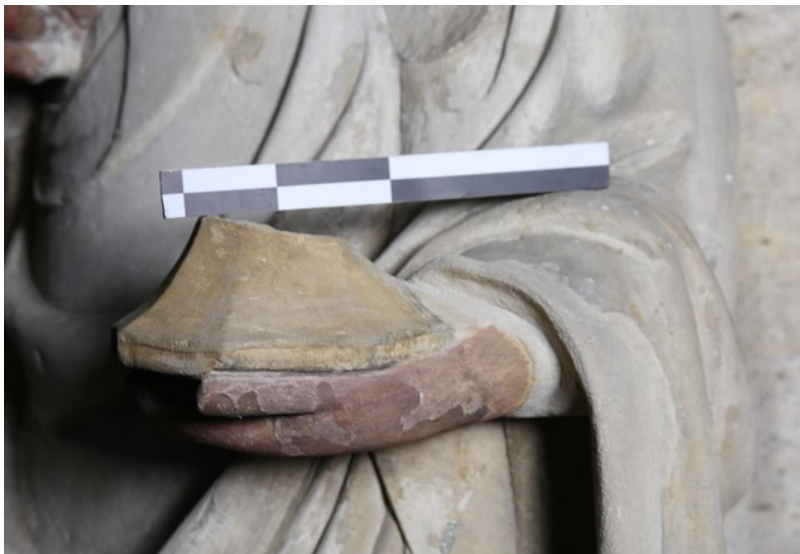
Abbildung 98, Abbildung 99, Abbildung 100: Vor, während und nach der Überarbeitung einer Altergänzung an der Skulptur des Apostels Johannes.
