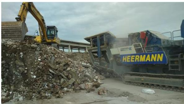
Bild 1: Aufgabe Ausgangsmaterial in Brecher
