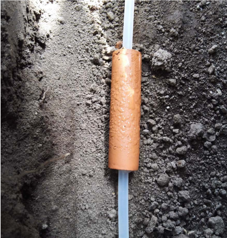
Abbildung 21: Tonkörper-Leitung in einer ausgehobenen Rinne (bereits mit Wasser gesättigt)
