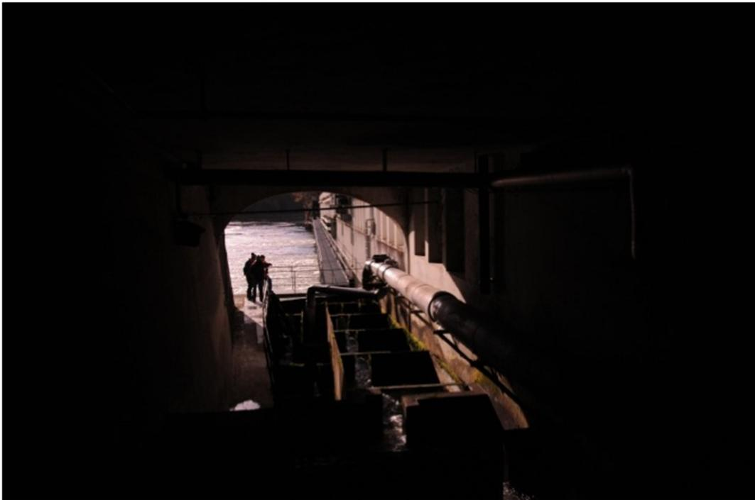
Abb. 1: Getunnelter Fischpass am Kraftwerk Augst am Hochrhein (Foto: IfÖ)
