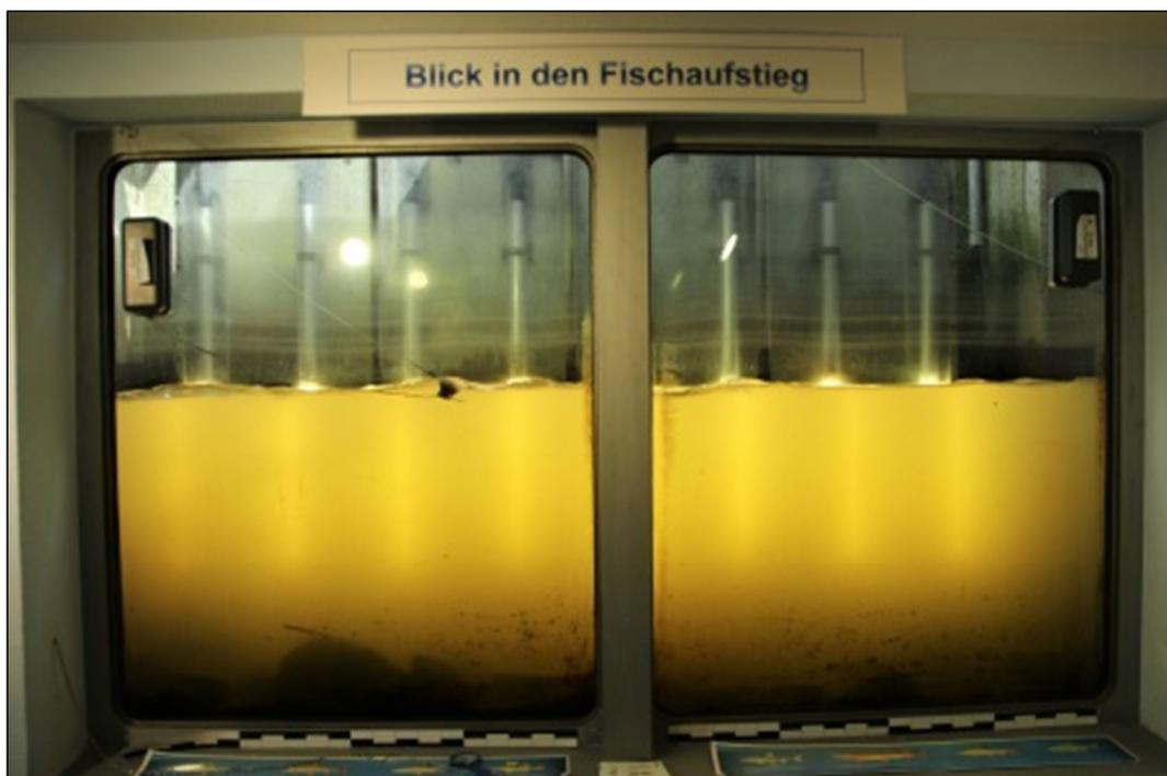
Abb. 2: Leuchtstoffröhren erhellen das Beobachtungsfenster in der Fischaufstiegsanlage am Wehr der Kinkel'schen Mühle an der Lahn in Gießen (Foto: IfÖ)
