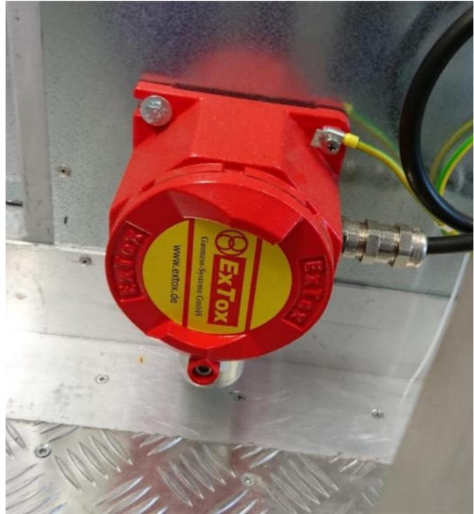
Abbildung 4: Kohlenstoffdioxidmessung am Containerboden
