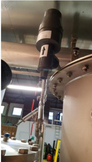
Abbildung 16: Über- bzw. Unterdrucksicherung V1.09
