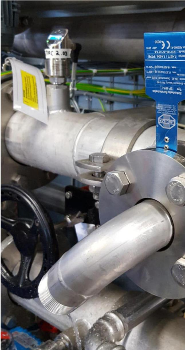
Abbildung 5: eingebaute Berstscheibe mit noch nicht angeschlossener Abführung
