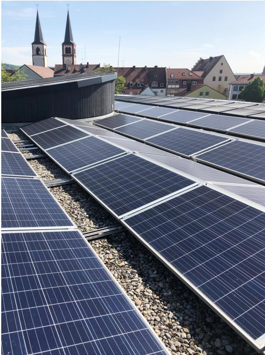
Abbildung 4: Dachansicht der Umweltstation mit der zentralen Dachbelichtungsverglasung, Solarabsorber für das Eisspeichersystem und PV-Anlage. Umweltstation © Michael Lauricella
