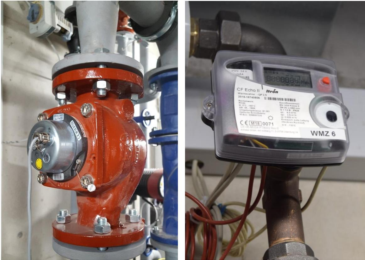
Abbildung 14: Wärmemengenzähler in der großen Ausführungsvariante (links) und der kleinen Ausführungsvariante (rechts).
