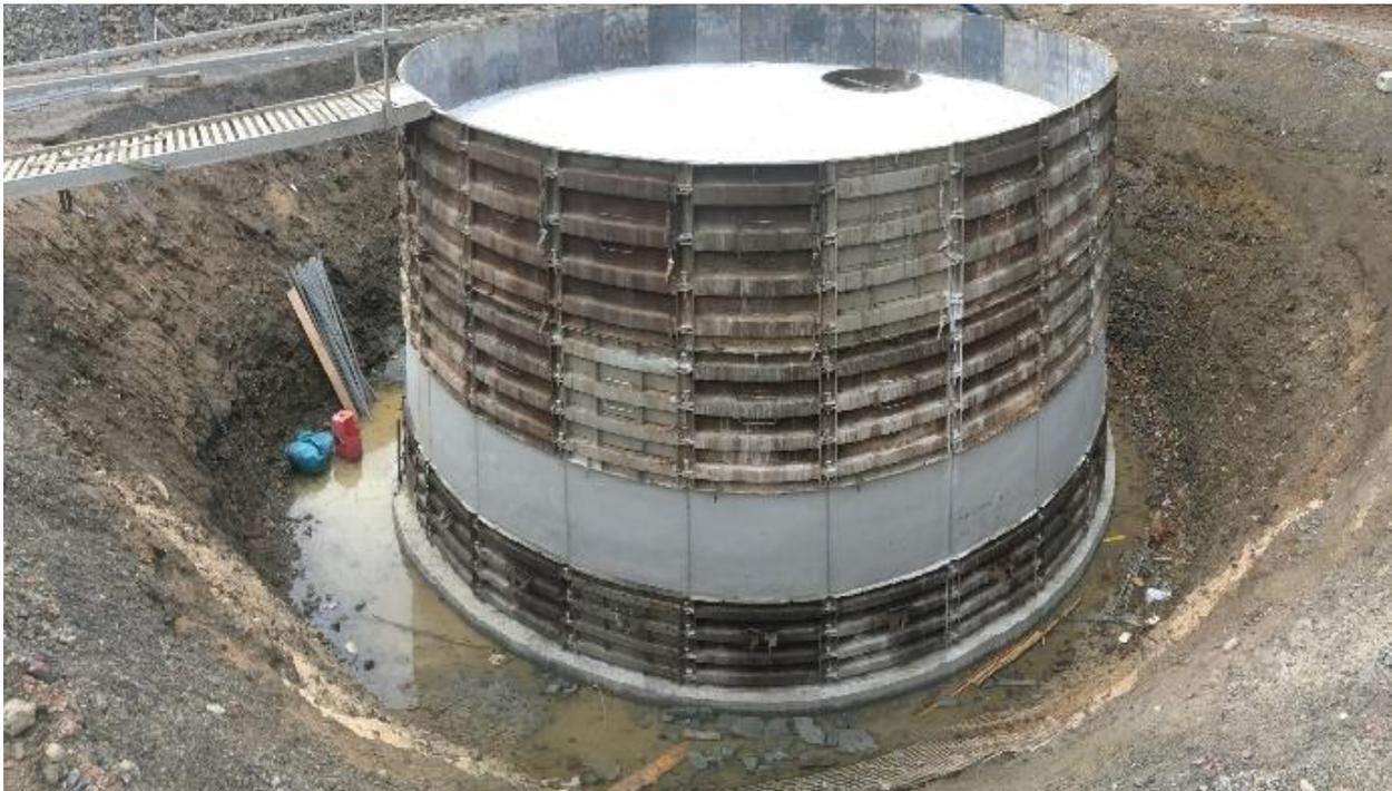
Abbildung 7: Eisspeichertank mit 132,5 m<sup>3</sup> Gesamttinnenvolumen und 107 m<sup>3</sup> Wasserfüllung.
