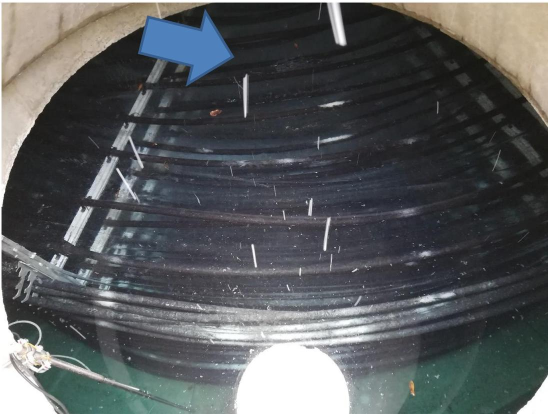
Abbildung 16: Visuelle Überprüfung des Eisspeichertanks.
