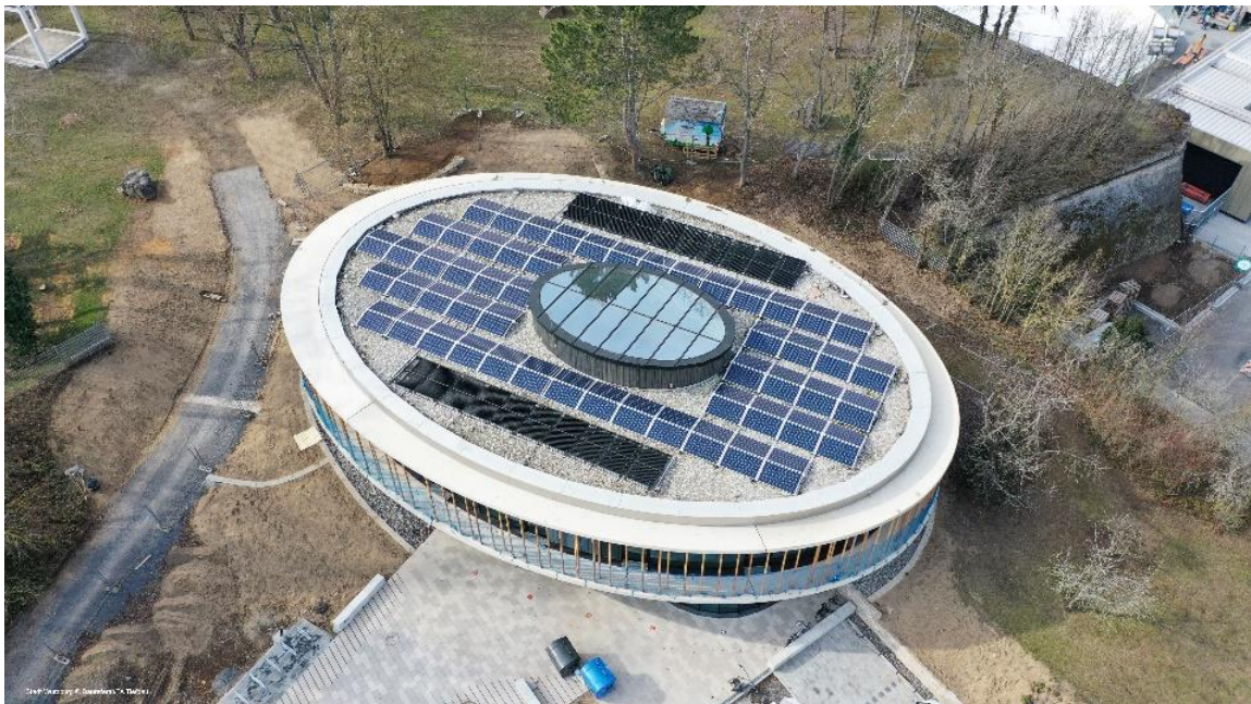
Abbildung 4: Vogelperspektive der Umweltstation mit PV-Anlage und Solarabsorber auf dem Dach. © Stadt Würzburg - Baureferat/FA Tiefbau
