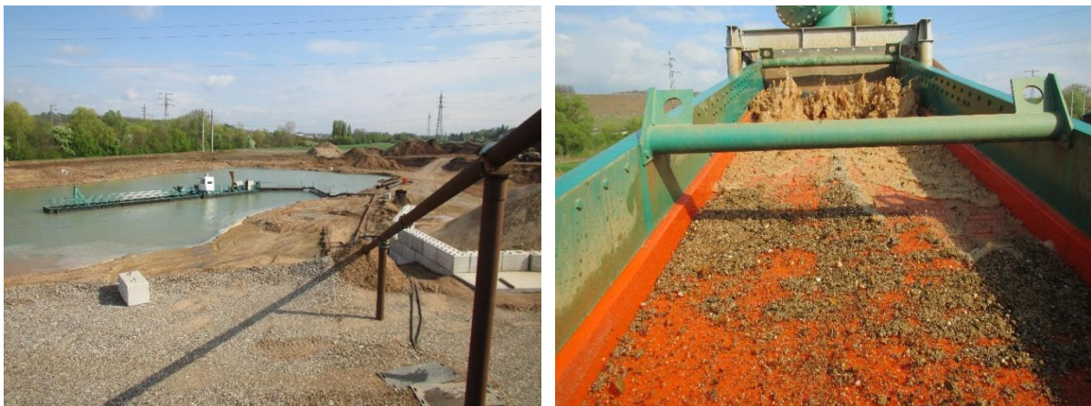
Abbildung 29: Saugbagger in der Kiesgrube und Siebstrecke zur Trennung von Sand und Kies
