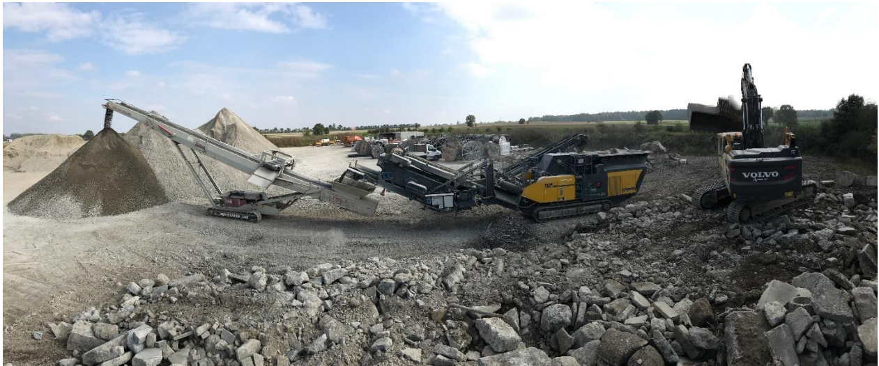
Abbildung 11: Prallbrecher (gelb) zur Aufbereitung des Betonbruchs [Steffen Beuerlein].
