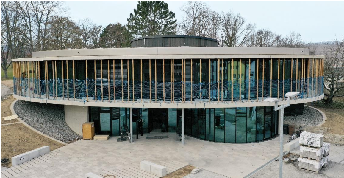
Abbildung 2: Ansicht der Umweltstation von außen. © Stadt Würzburg - Baureferat/FA Tiefbau
