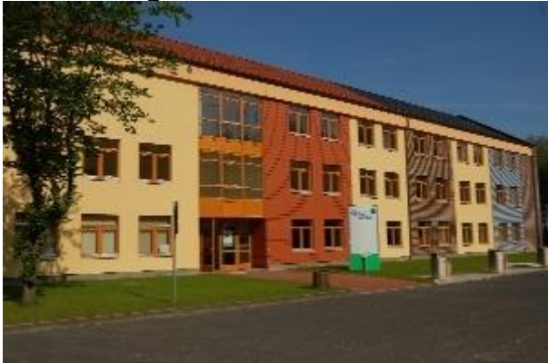
Fassadengestaltung mit nachwachsenden Rohstoffen
