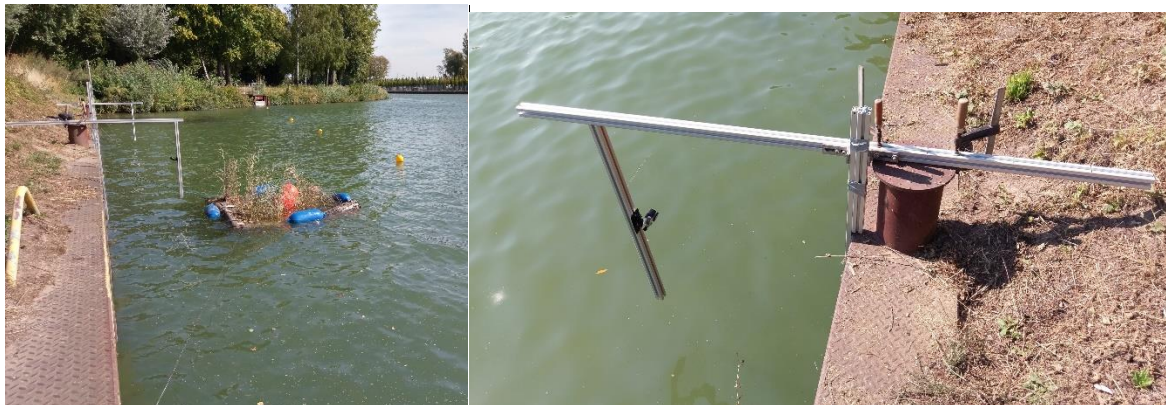
Abbildung 15: Messstelle 1 & 2 mit und ohne vorgelagerten Gabionen im Wendebecken bei Kanalkilometer 155 (links) und einzelne Messstelle mit Aluminiumprofil mit Messlatte und Kamerasystem
