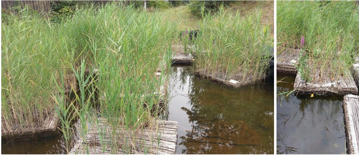
Abbildung 12: Schilfgabionen im eingelagerten, voll-bewachsenem Zustand im August 2019
