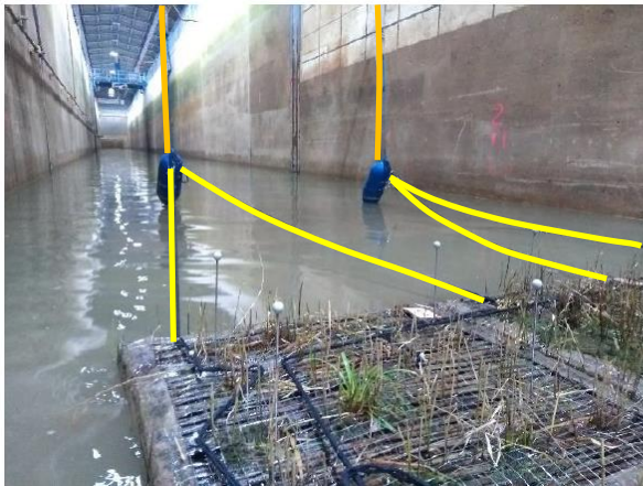
Abbildung 24: Reiterbojen die mit flexiblen Expanderseilen (gelb) mit der „schwimmenden Inseln“ verbunden sind sowie Halteseile (orange) (links); Ansicht eines Schwergewichtfundamentes mit Ankerseil aus Stahl und Kettengliedern bis zur Reiterboje (rechts).
