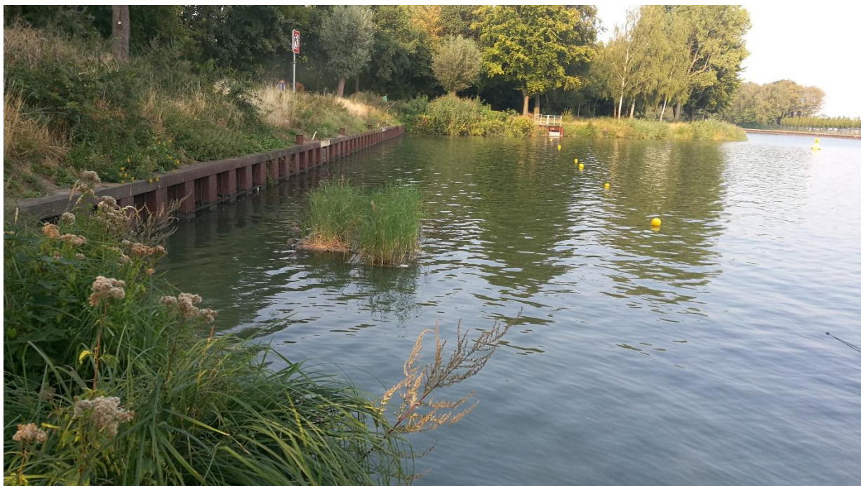
Abbildung 14: „Lebende Insel“ bestehend aus mehreren, verbundenen Gabionen während des Einbaus im Mittel-landkanal
