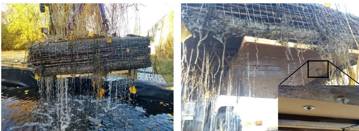
Abbildung 23: Gabione mit XPS-Platte (links) und Detailansicht der mit Kontermutter und Gewindestab gesicherten XPS-Platte (rechts). Die bis zur Oberfläche vorstehenden Gewindestangen dienen zur Montage von passiven Markierungen für das Motion-Tracking-System.
