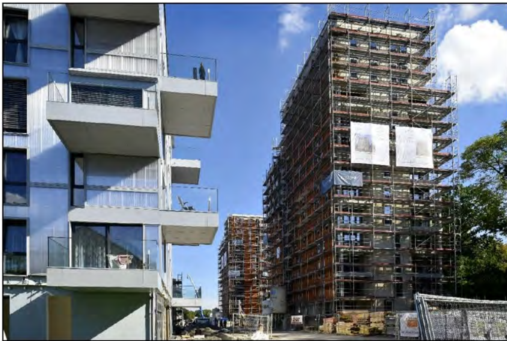
Bild 34 West-Ansicht der hohen Häuser – Baufelder L1 und M1 als Typologie „Apartmenthaus“ in der Bauphase im September 2020
