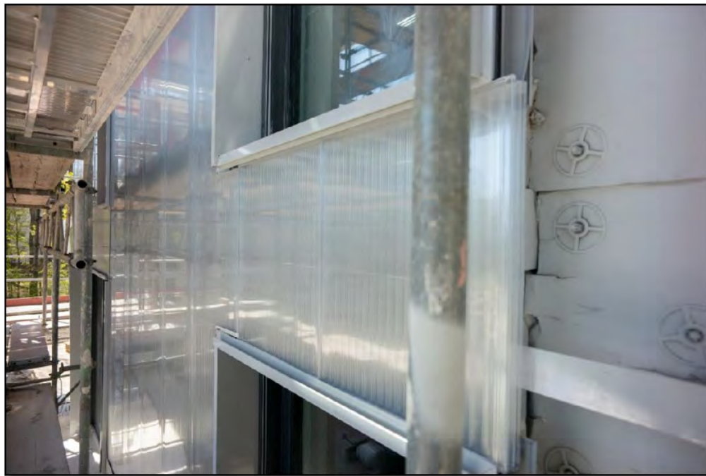
Bild 38 Montage der Polycarbonathülle in der Bauphase mit Umsetzung im Fensterbereich
