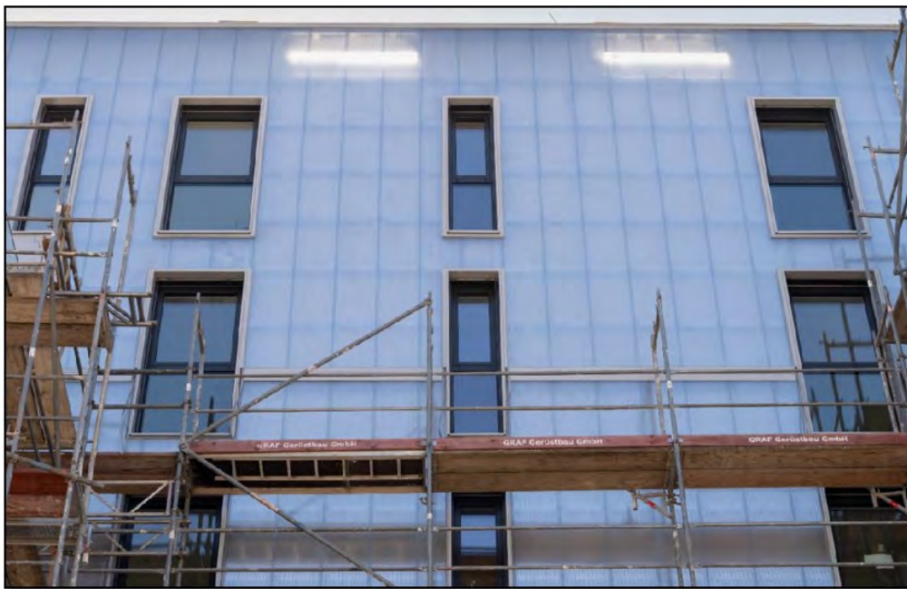
Bild 40 Fassadenansicht mit im oberen Bereich fertiggestellter Polycarbonathülle
