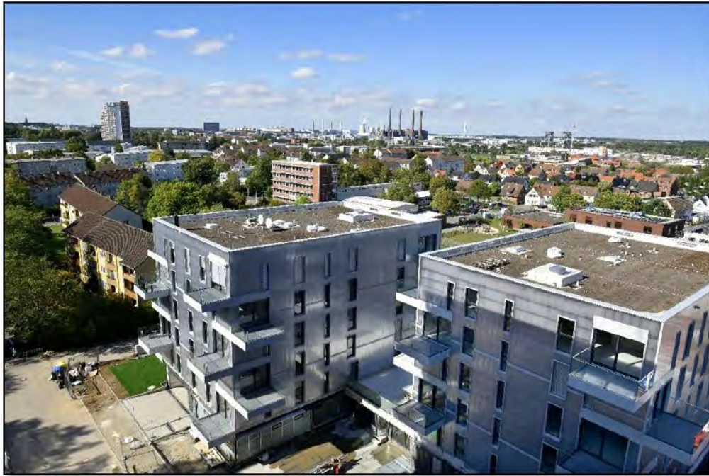
Bild 37 Süd-Ost-Ansicht der Gebäude im Baufeld H1 zum Zeitpunkt des Presserundgangs
