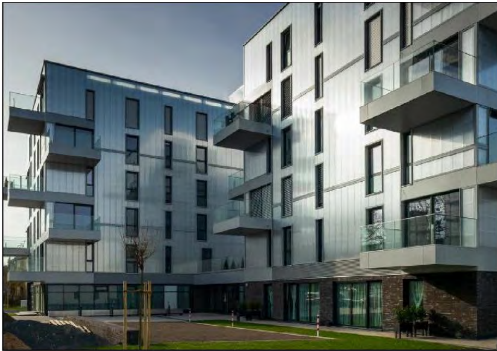
Bild 51 Südostansicht des Wohnzwillings mit Polycarbonatfassade und dynamischer Wärmedämmung, Baufeld H1
