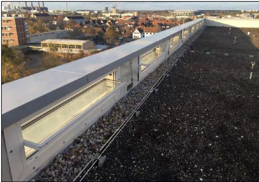
Bild 41 Zu öffnende und schließbare Klappen oberhalb der Fassaden-Luftschächte
