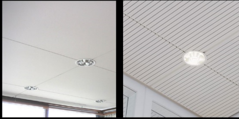
abgehängte Plattendecken (früher Gipskarton, jetzt microperforiertes Holz) abgehängte Schlitzdecken (früher Holz, jetzt Gipskarton)
