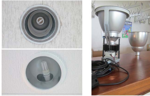
Umbau Foyer-Downlights mit LED in RGBw-Farben mit bauzeitlichem Einbauahmen
