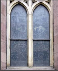
Luftöffnungen bei Außenschutzverglasung
