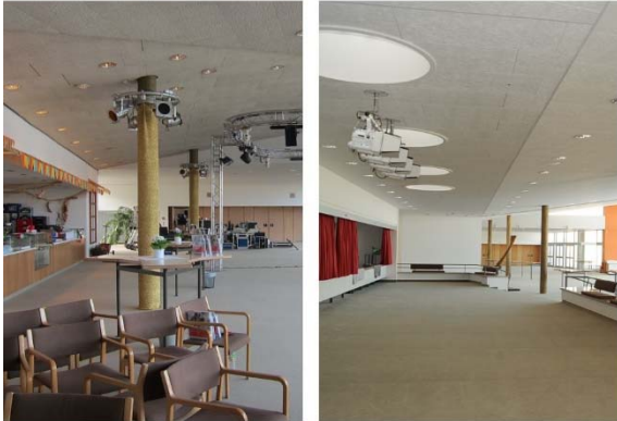
Umbau Foyer-Downlights mit LED in RGBw-Farben mit bauzeitlichem Einbauahmen
