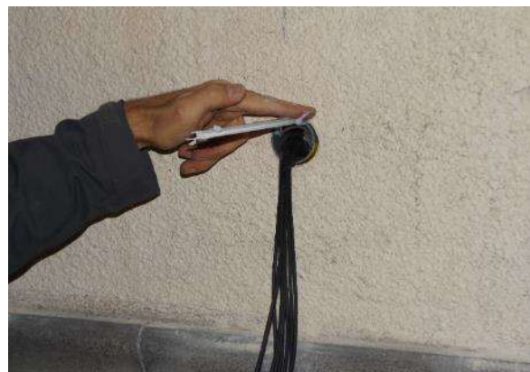
Bild 21: Auftragen von Gleitmittel auf das Spannprofil
