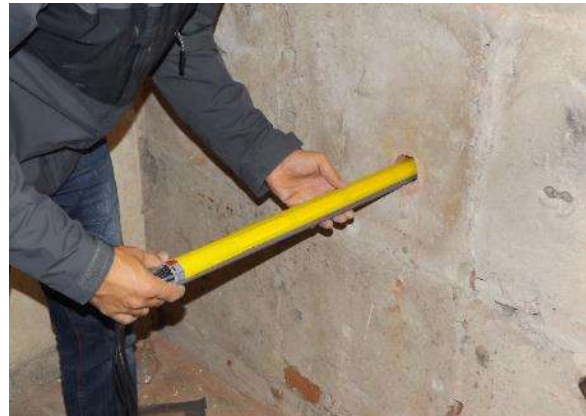
Bild 19: Einführung der Sonde in das Bohrloch
