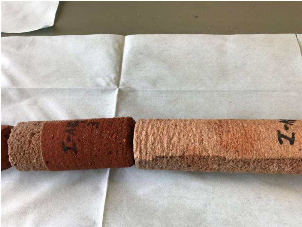
Bild 77: Bohrkerh I - Teilbereich 4
