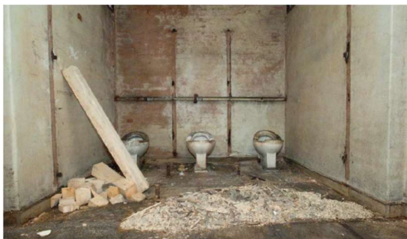
Bild 5: Blick in einen Teil Toilettenanlage der Zeppelintribüne 2013 (Presse- und Informationsamt Stadt Nürnberg)
