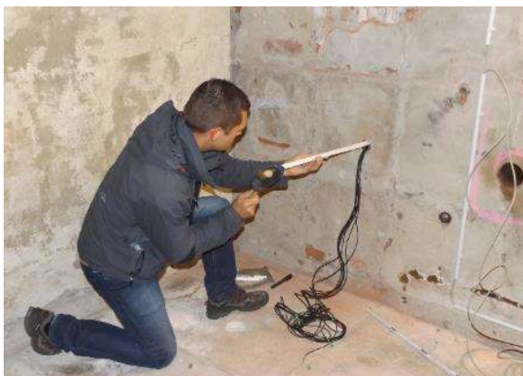
Bild 20: Einschlagen des Spannprofils
