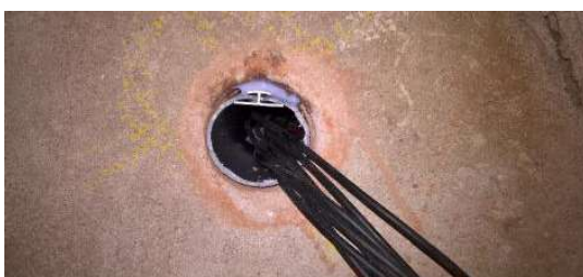
Bild 22: Einbauzustand nach der Verklebung
