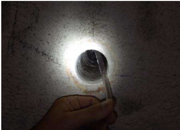
Bild 18: Eingeführter Druckluftschlauch
