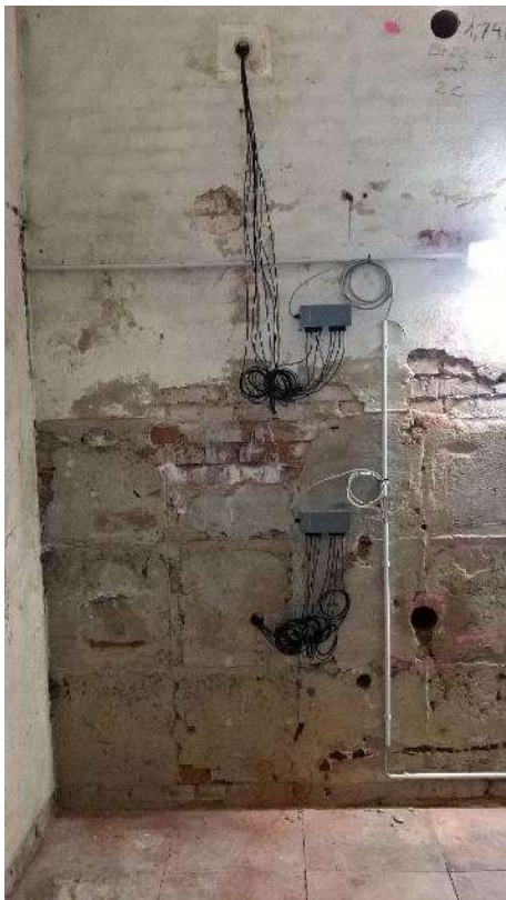
Bild 25: Ansicht Messsystem am Mauerwerk
