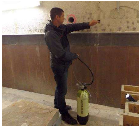
Bild 17: Ausblasen mit Druckluft
