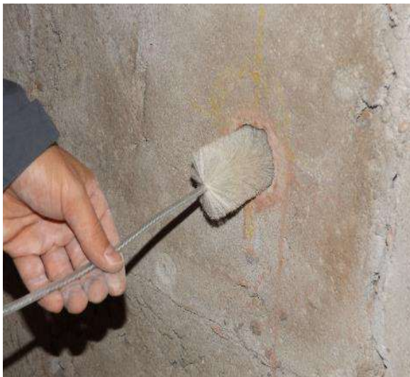
Bild 16: Ausputzen der Bohrlöcher
