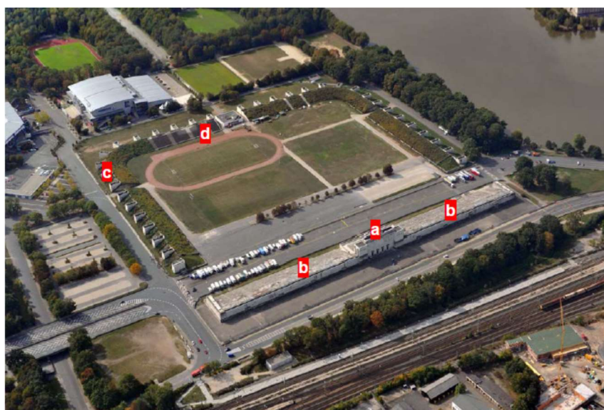
Bild 4: Zeppelfeld und -tribüne 2013 (Nürnberg Luftbild, Hajo Dietz Fotografie) - die Tribüne gliedert sich in den Mittelbau a und die beiden Seitenflügel b
