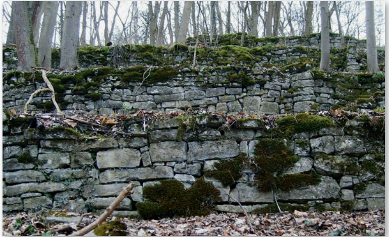
Abb. 16: Schön gearbeitete Trockenmauern mit Staffeln aus Muschelkalk. Etliche dieser Weinbergbrachen sind schon um die 200 Jahre alt, die Mauern entsprechend älter. Sie dokumentieren alte Baustile in unveränderter Form.
