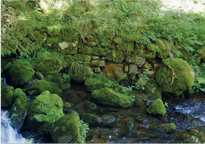
Abb. 9: Ufermauer in einem Schwarzwaldbach, in dem nachweislich Holz transportiert wurde. In sehr vielen Bächen kann man ähnlich Relikte finden.
