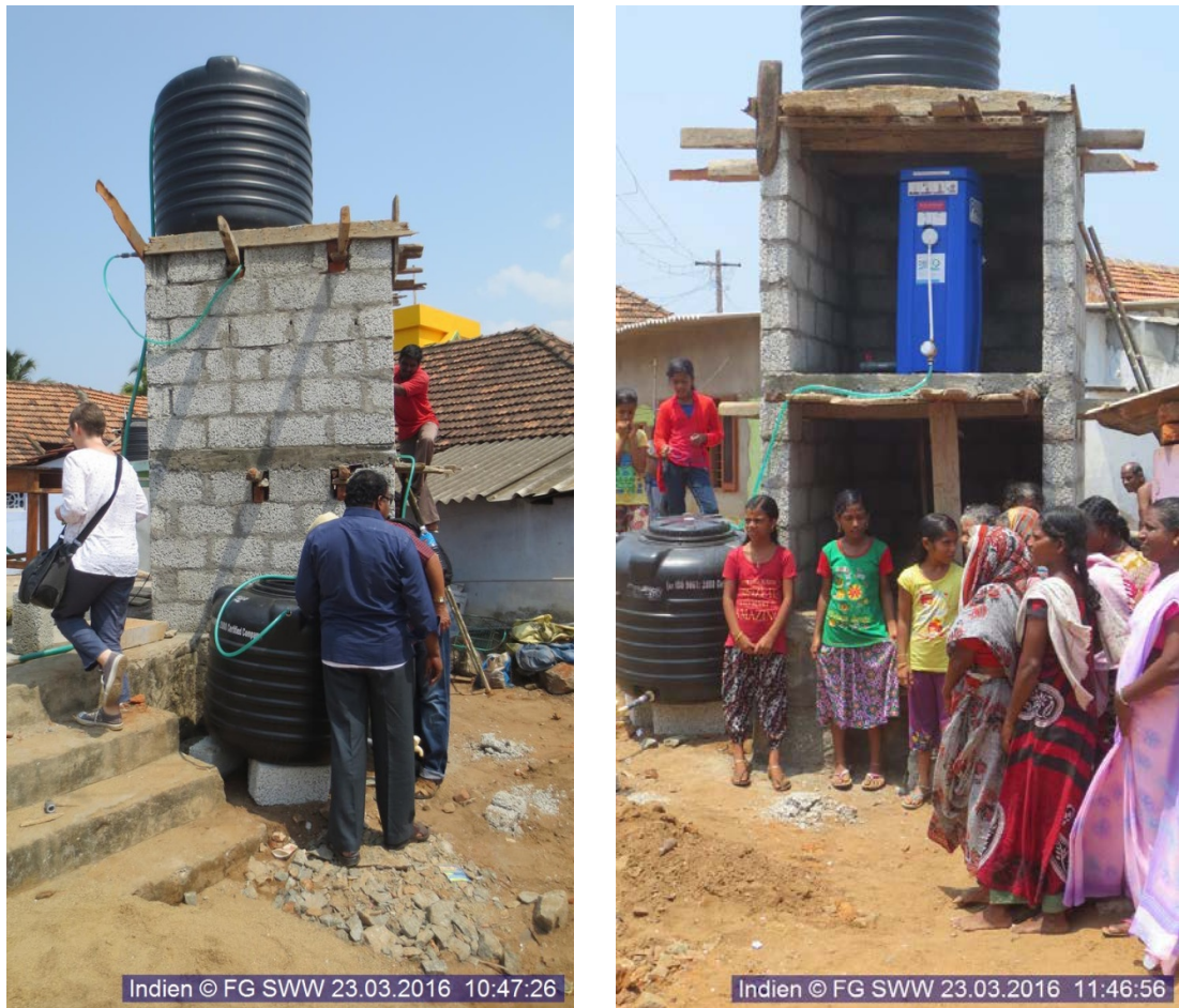
Bild 15: Enayam Puthenthurai – Stand der Bauarbeiten am 23.03.2016
