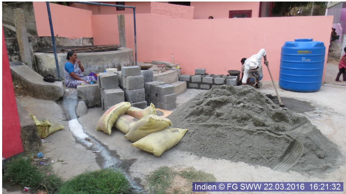
Bild 18: Keela Muttom – Stand der Arbeiten am 22.03.2016
