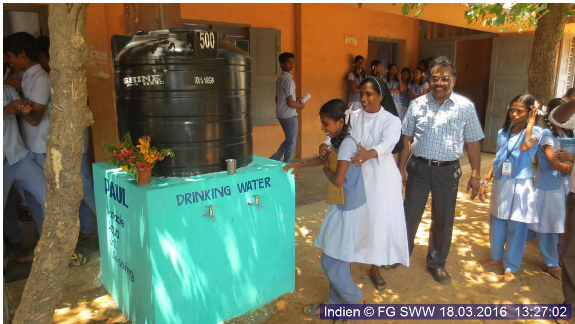
Bild 11: St. Jude School – Reinwassertank
