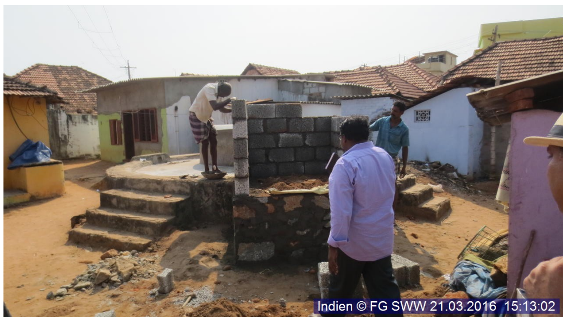
Bild 14: Enayam Puthenthurai – Stand der Bauarbeiten am 21.03.2016
