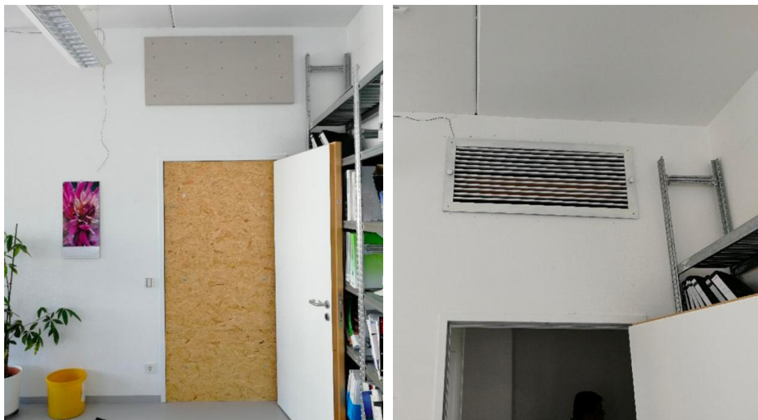
Abbildung 35: links abgedichteter Aufbau, rechts offen
