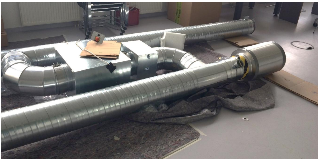
Abbildung 23: Auslegen des Mockups hinterer Teil
