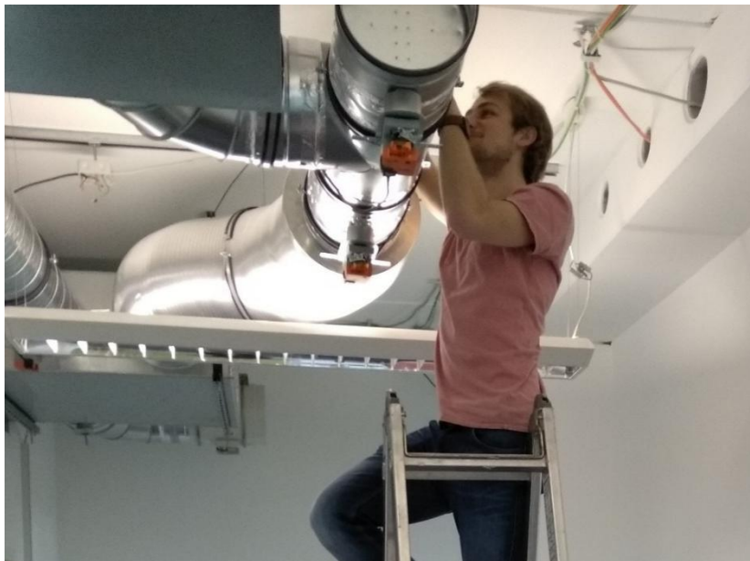
Abbildung 29: Verkabelung überprüfen
