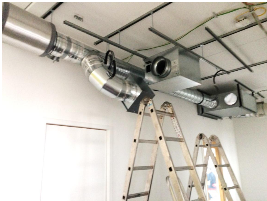
Abbildung 26: zweite Baugruppe befestigt
