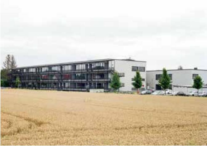
Die Planung hatte sich zum Ziel gesetzt, den Primärenergieverbrauch so niedrig wie möglich zu halten und einen Passivhausstandard zu erreichen. In der Realisierung wurde der maximale Heizwärmebedarf des Passivhausstandards von 15 kWh/m<sup>2</sup>a sogar noch unterschritten.
