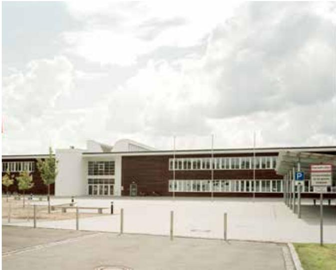
Eine tragende starre Struktur aus Stahlbeton bleibt innen sichtbar und wird von außen thermisch verkleidet. Um den Passivhausstandard zu erreichen, wird vor die tragende Konstruktion eine Dämmebene mit 28 cm Stärke gehängt, in der auch die Fenster sitzen. Den äußeren Abschluss bildet eine hinterlüftete Stülpschalung aus horizontalen Brettern.
