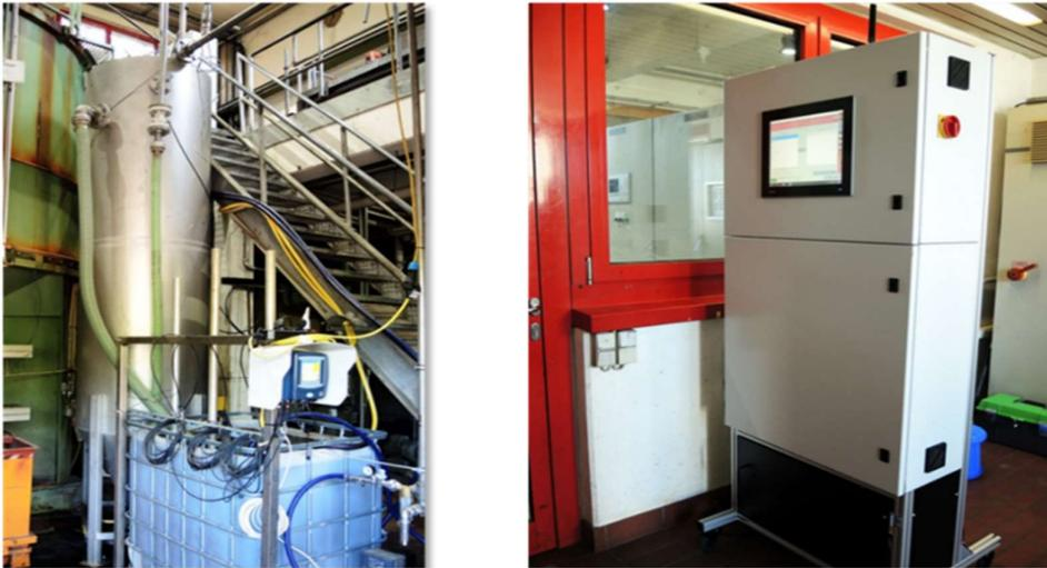
Abbildung 12: Foto des mit Aktivkohle befüllten DYNASAND-Filters (links) und des WATERTRACE-Systems (rechts) im Klärwerk Baden-Baden/Sinzheim
