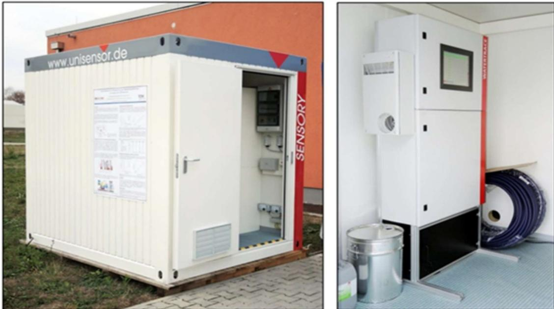
Abbildung 11: Sensorsystem in einem thermostatisierten Container im Außenbereich des Klärwerks Mannheim
