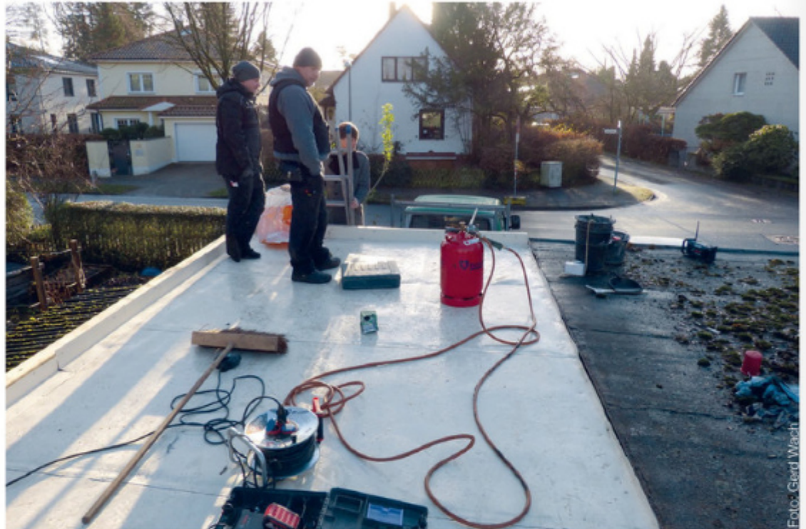
Mitarbeiter eines Bedachungsunternehmens verlegen die erste geförderte umweltfreundlichere Folie aus Flexiblen Polyolefinen (FPO)
