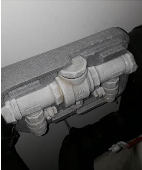
Abbildung 67: Links: Vereiste Spülgruppe (Zubehör des Wärmepumpenlieferanten) da nicht kondensatsicher wärmedämmend. Rechts: Vereisung an ungedämmtem Hebel eines Absperrhahns, ebenfalls beim Estrich-Aufheizen.
