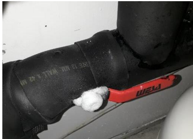
Abbildung 67: Links: Vereiste Spülgruppe (Zubehör des Wärmepumpenlieferanten) da nicht kondensatsicher wärmedämmend. Rechts: Vereisung an ungedämmtem Hebel eines Absperrhahns, ebenfalls beim Estrich-Aufheizen.
