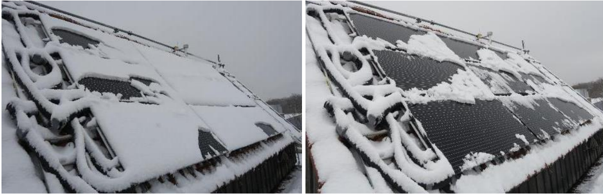
Abbildung 41: Schneeabrutschverhalten am PVT-Kollektorfeld ohne Lochbleche (Konfiguration B).
