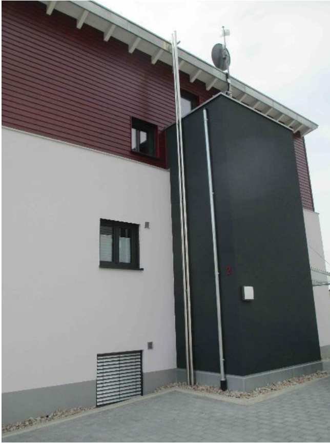
Abbildung 49: Zwei Edelstahl-Fallrohre, in denen die ungedämmten Leitungen verlaufen
