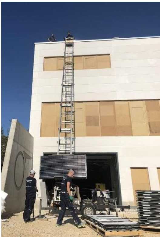
Abbildung 60: Transport der SOLINK-Kollektoren auf das Dach mit Lastenaufzug. Unten und oben sind jeweils zwei Personen nötig.
