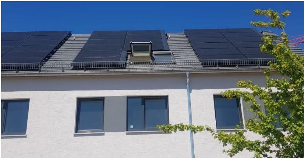
Abbildung 64: Drei Kollektorfelder, bei denen die Soleleitungen durch die seitlichen Abdeckblechen, verdeckt sind.
