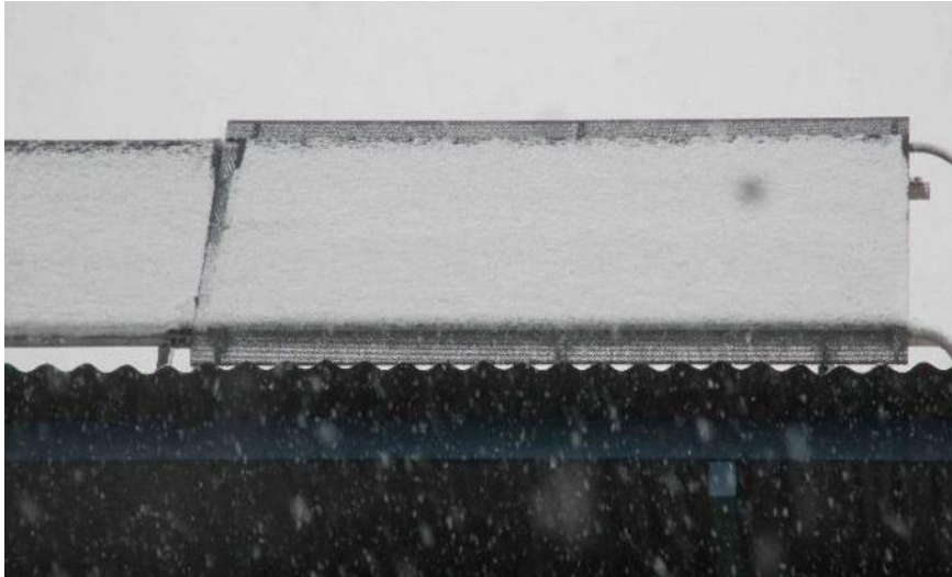
Abbildung 35: Schneefall auf 45°-aufgeständerten SOLINK-Kollektoren bei Temperaturen um den Gefrierpunkt: Schnee bleibt nur auf den gekühlten Kollektorflächen aber nicht auf den Blechen liegen.
