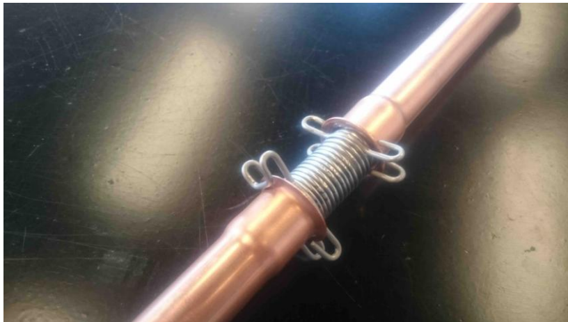
Abbildung 6: Kollektorverbinder mit Klammer zwischen zwei Sammlerrohren
