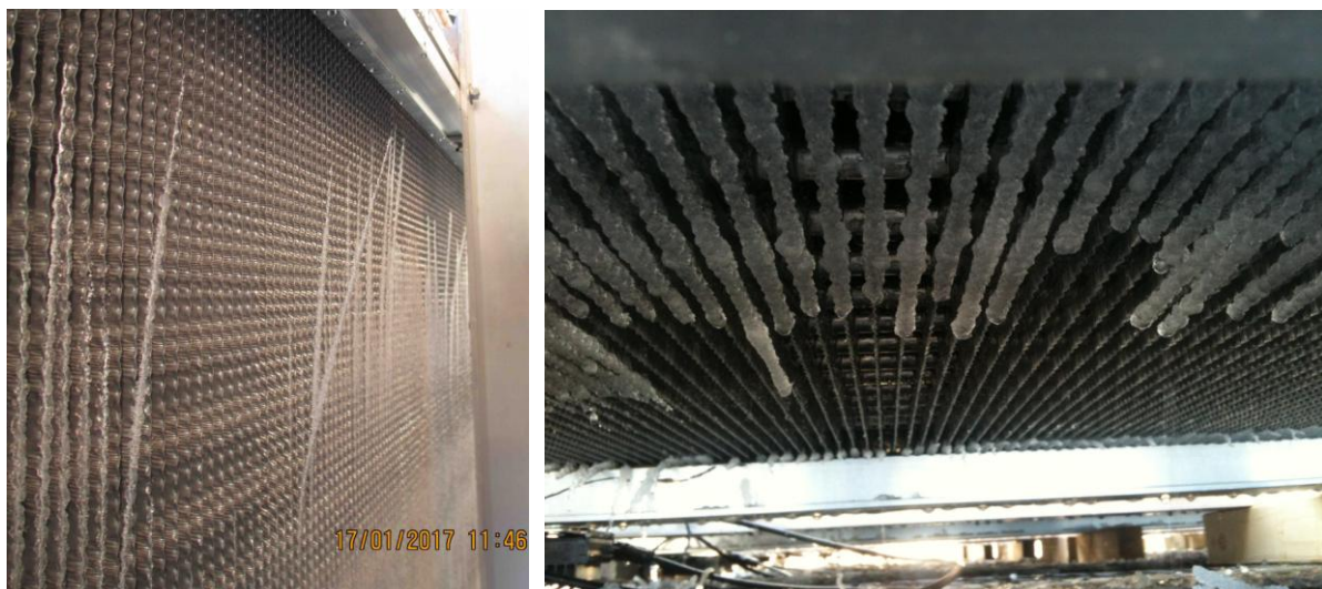
Abbildung 12: Eisstreifen, die sich vom Rand der Lamellen lösen
