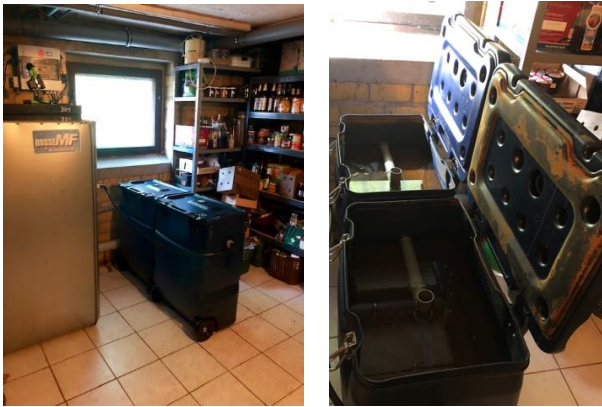
Abbildung 26: MFG-HKA 4 mit zwei in Reihe geschalteten PLim-170
