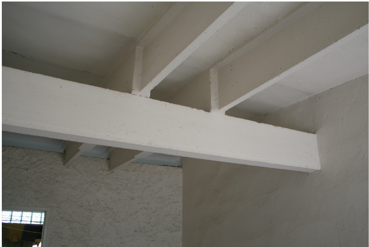
Abb. 4: Fotodokumentation der filigranen Dachbinder am Gerbergelenk
