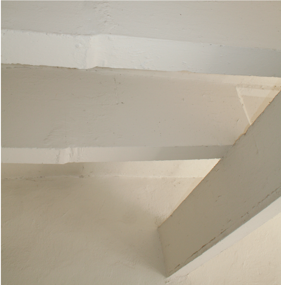
Abb. 5: Fotodokumentation der filigranen Dachbinder am Gerbergelenk
