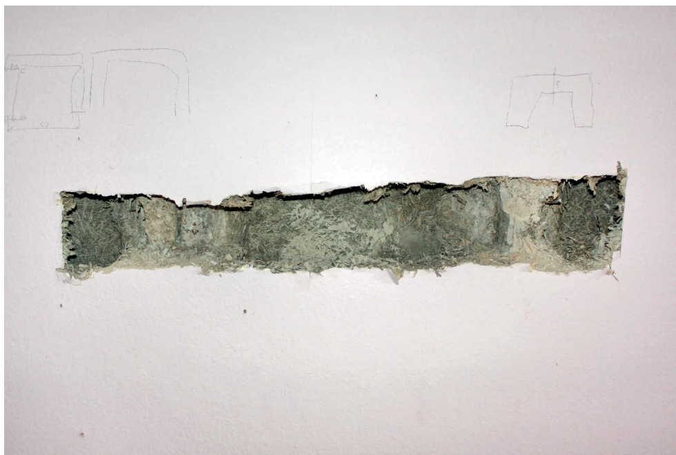
Foto 7: Innenwand, tragend (Wohnungstrennwand)
