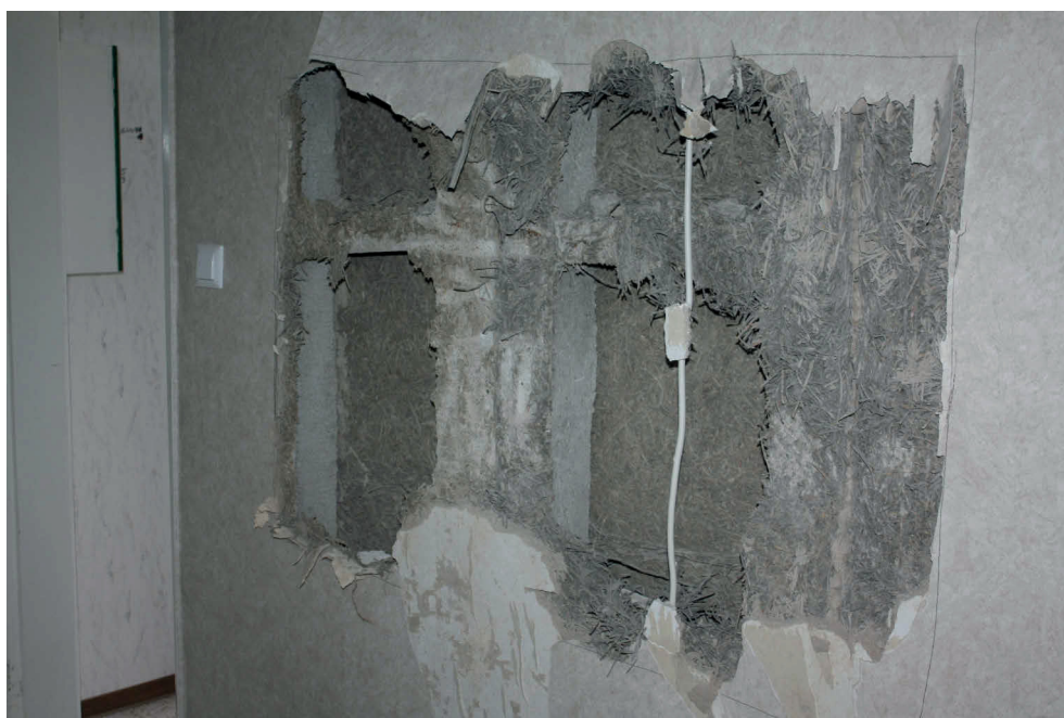
Foto 8: Innenwand, tragend (Mittelwand)
