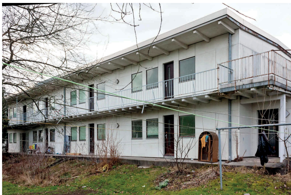
Foto 2: Außenansicht von Osten (Gartenseite), Fassadenverkleidung AZ-Platten
