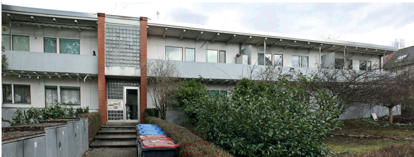
Foto 1: Außenansicht von Westen (Falkenweg), Fassadenverkleidung AZ-Platten
