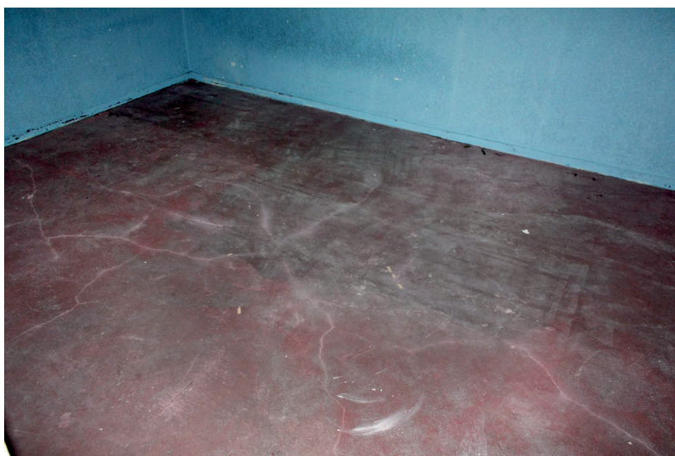
Foto 10: Zementestrich (Wohnung 1. OG, Nord)
