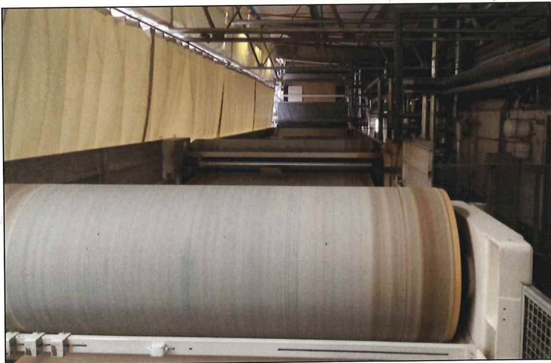
Abbildung 17: Ansicht der Heizpartie hinter dem Isolationsvorhang
