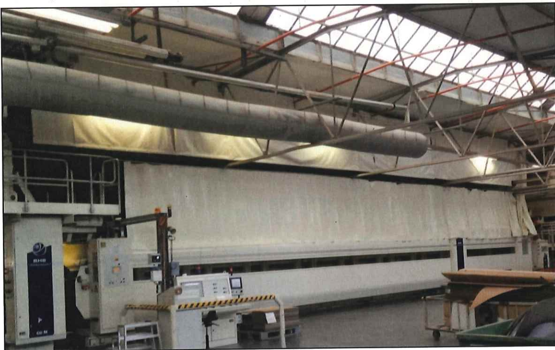
Abbildung 16: Zug- und Heizpartie mit Isolationsvorhang im Wellpappenwerk Delmenhorst
