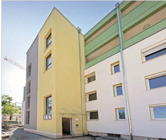
Abbildung 114 Aufstockung/Sanierung Housing Area – © GEWOBAU/HOCH5
