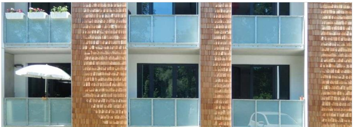
Abbildung 107 Fassadendetail der Holzbekleidung auf der Balkonseite
