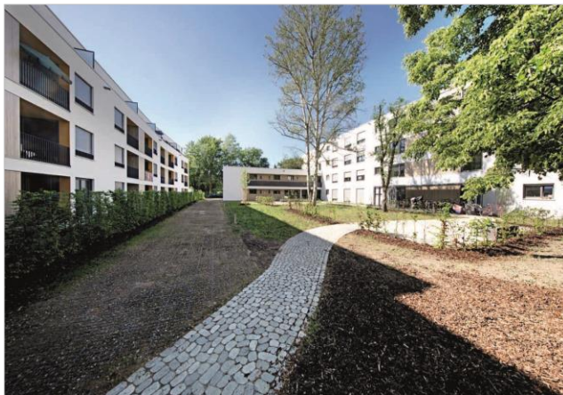
Abbildung 77 Gemeinschaftliche Freifläche Innenhof – © GEWOBAU/HOCH5
