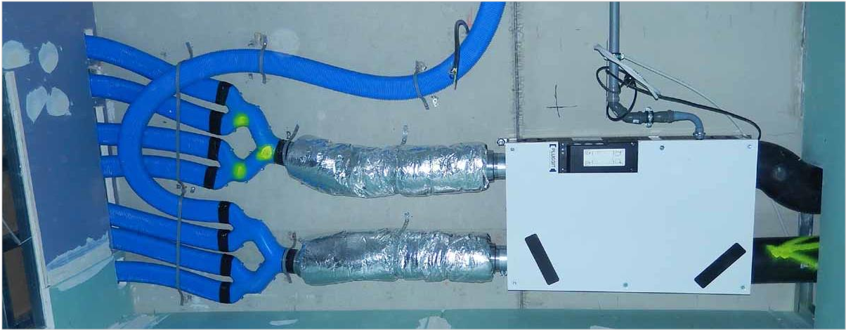
Abbildung 89 Lüftungsanlage mit Wärmerückgewinnung – Montage unter der Baddecke
