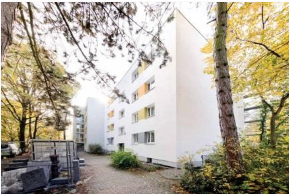
Abbildung 119 Sanierung Würzburger Ring – © GEWOBAU / HOCH5
