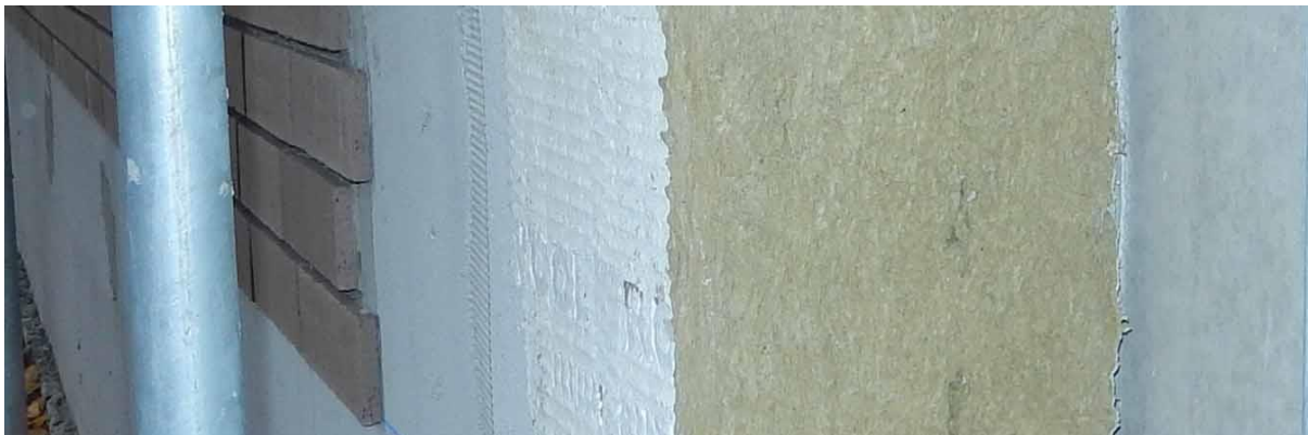
Abbildung 87 Aufbau des Wärmedämmverbundsystems mit Riemchenbekleidung
