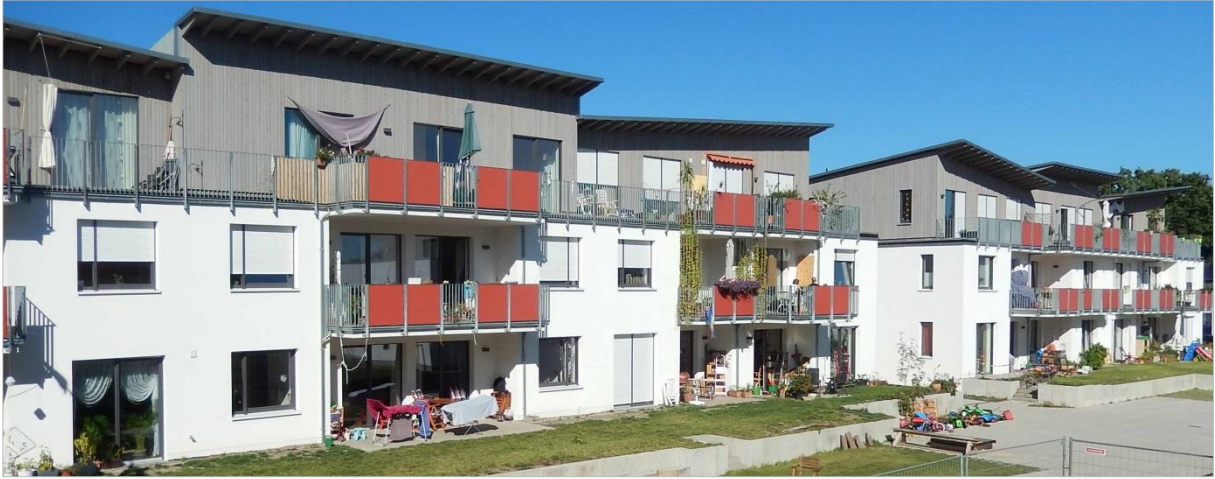
Abbildung 96 Südansicht der nördlichen Bebauung
