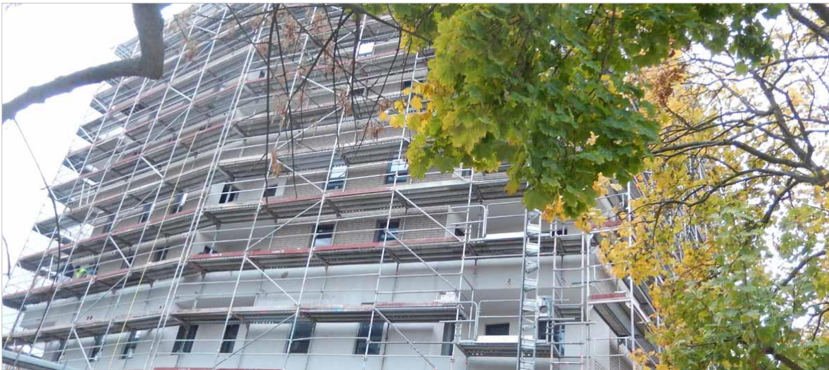
Abbildung 90 Ansicht am Tag der Besichtigung
