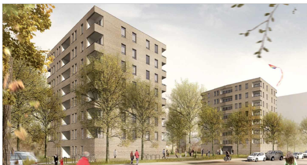
Achtgeschossige Nachverdichtung Sewanstraße, Berlin Städtebaulich kompakte Bauweise: 99 Wohnungen im Standard KfW EH 40 PLUS mit minimiertem Heizwärmebedarf und optimierter PV- & Batterietechnik HOWOGE Berlin (5.3)
