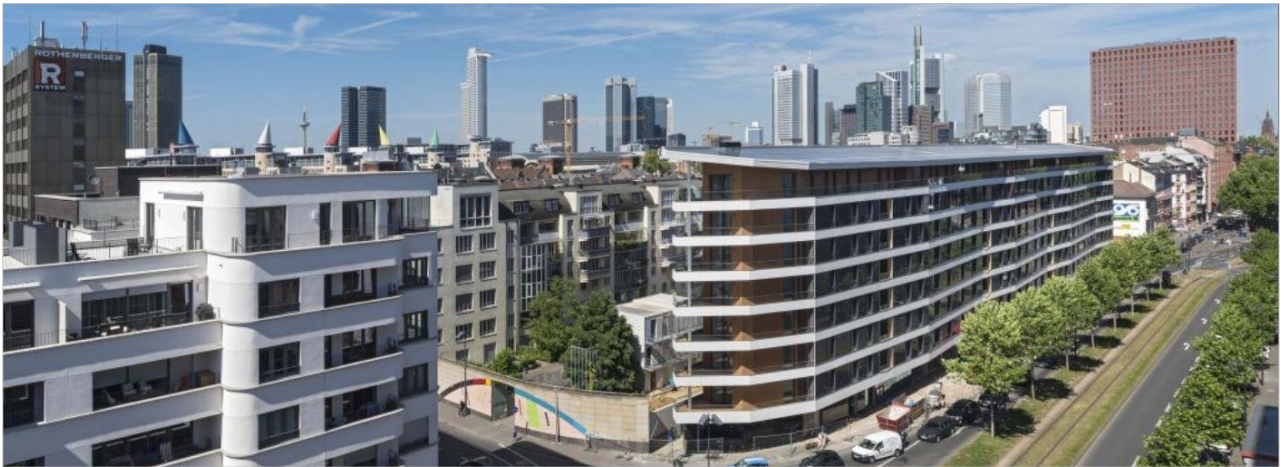
Abbildung 97 Südansicht des Aktivhauses zur Speicherstraße
