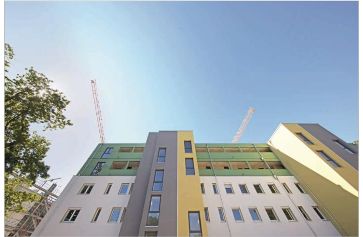
Abbildung 115 Ansicht von der Erschließungsseite Housing Area – © GEWOBAU/HOCH5
