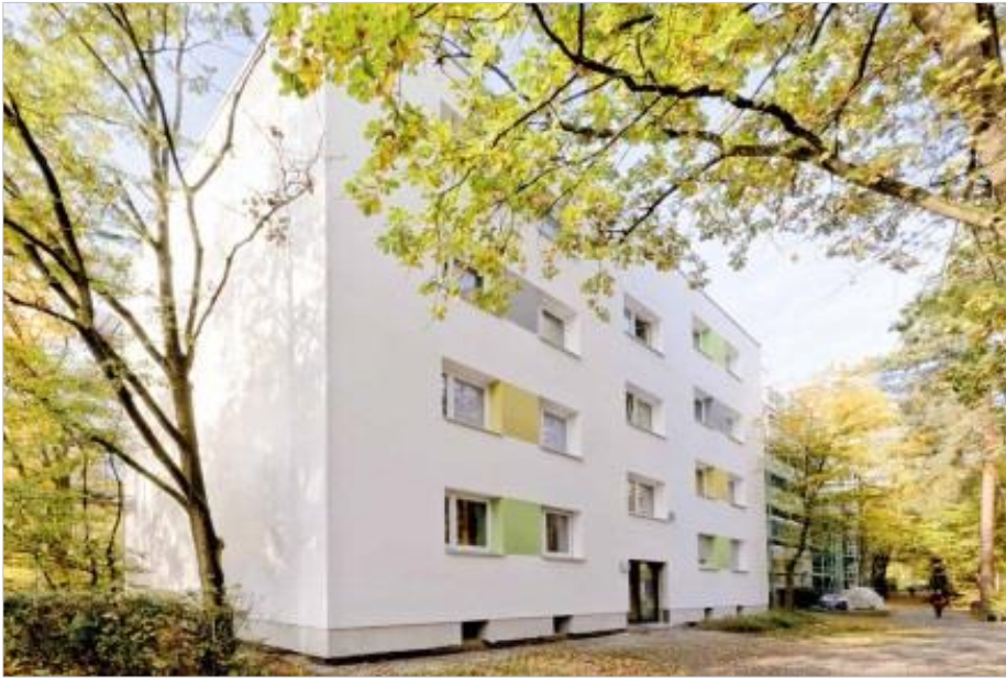
Abbildung 118 Sanierung Würzburger Ring – © GEWOBAU / HOCH5
