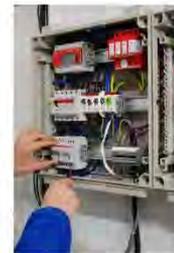
Elektrische Komponenten im Generatoranschlusskasten (Foto: Horn 2014)
