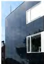
Walther-Hempel-Bau der TU Dresden: Dünnschicht-PV-Module in der Fassade (Foto: Horn 2014)
