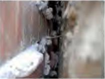
Durchgerostete verzinkte Luftschichtanker
