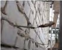
Ausbulungen und Abrisse können ein Hinweis auf eine nicht mehr funktionierende Verankerung sein. Erst in der Ausgabe November 1974 der DIN 1053 wurden Luftschichtanker aus Edelstahl zwingend vorgeschrieben. Noch bis 1976 wurden vereinzelt verzinkte Drahtanker verwendet.
